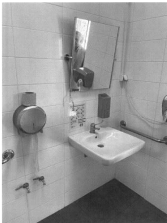
Zdjęcie nr 9 Wnętrze toalety dla osób z niepełnosprawnością.
