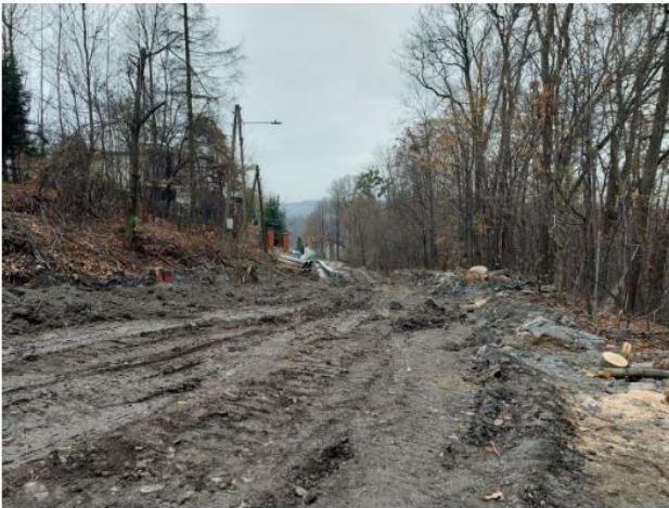
ul. Błogocka przed modernizacją
