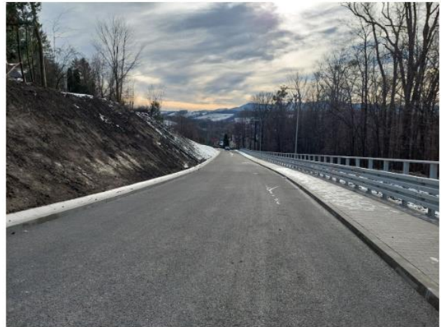
ul. Błogocka po modernizacji
