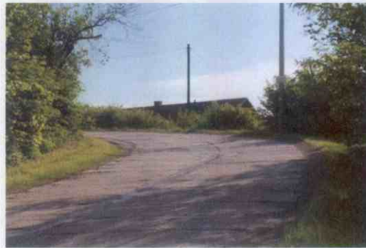
Ul. Zamarska- zakręt od strony wjazdu do góry
