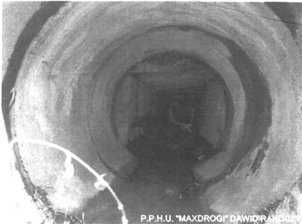
Fot. 2. Widok wnętrza części przelotowej przepustu na prefabrykaty rurowe z betonu zbrojonego od strony wylotu
