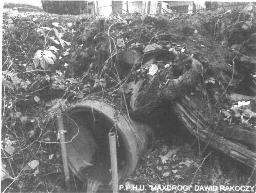
Fot. 1. Widok przepustu od strony zachodniej, tj. od strony wylotu
