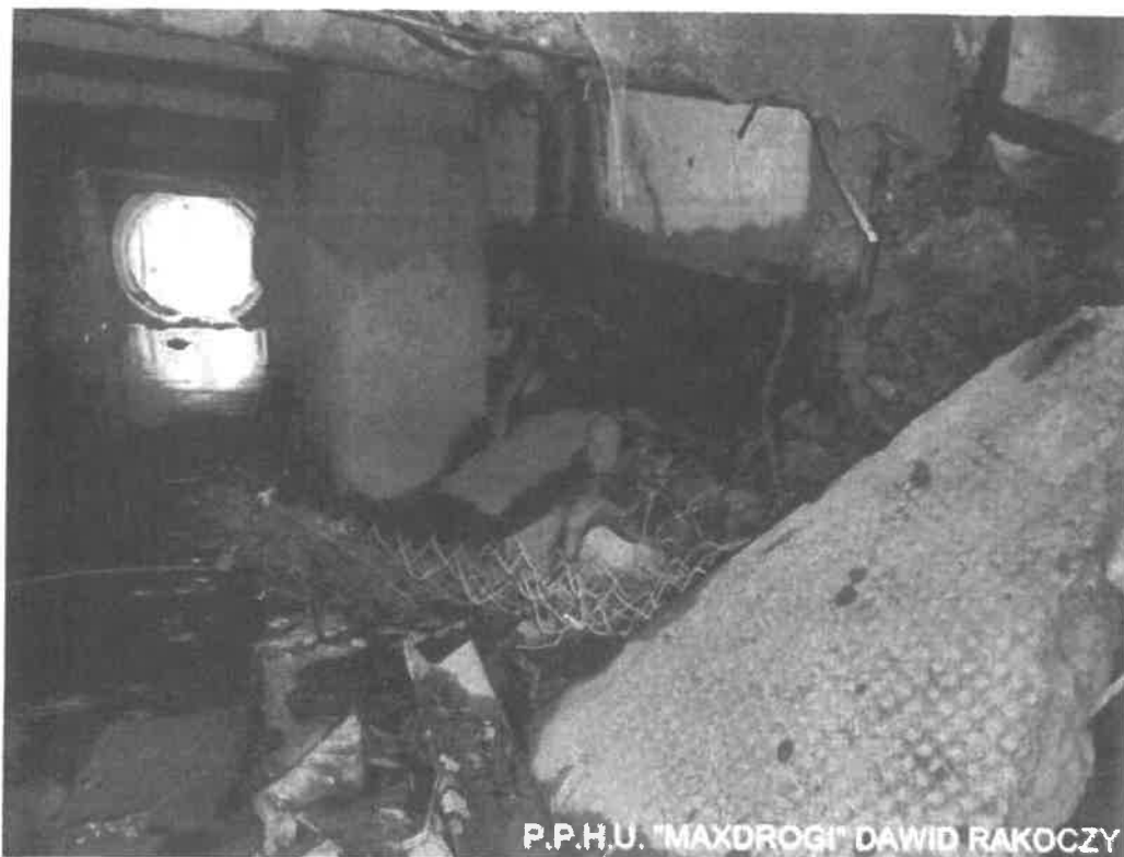
Fot. 13. Od strony wlotu do przepustu w miejscu braku umocnienia skarpy gruzem występują pustki zagrażające miejscowym zapadnięciem się korpusu drogowego
