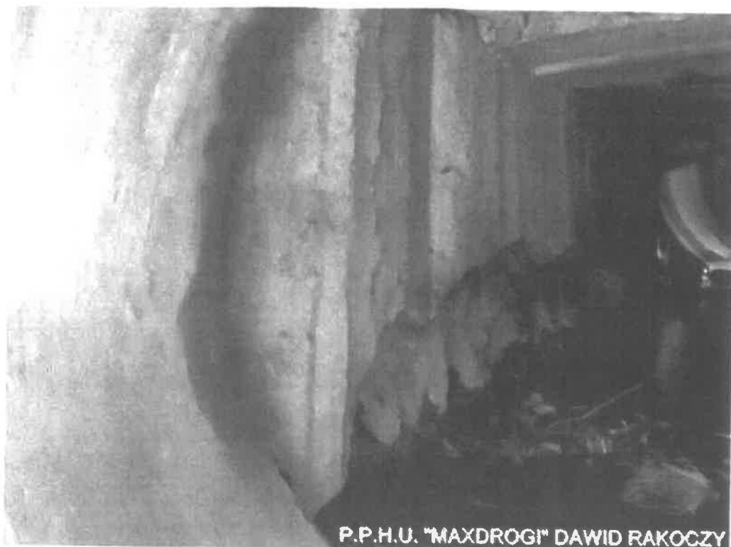
Fot. 10. Betonowe ściany przepustu w części przekroju prostokątnego wykazują obszerne ubytki erodującego betonu, co negatywnie wpływa na nośność użytkową obiektu
