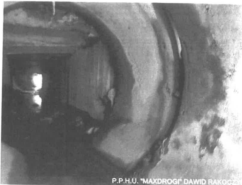
Fot. 9. Widoczne kręgi części wylotowej przepustu, które są [przesunięte względem siebie, nie są ustabilizowane typową zasypką, lecz zalega na nich gruz bez jakiegokolwiek izolacji
