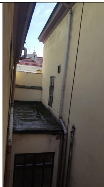
Widok od strony dziedzińca pomiędzy kinem a ratuszem, wymiana rynien , okna do zamurowania widok od ul. Srebrnej
