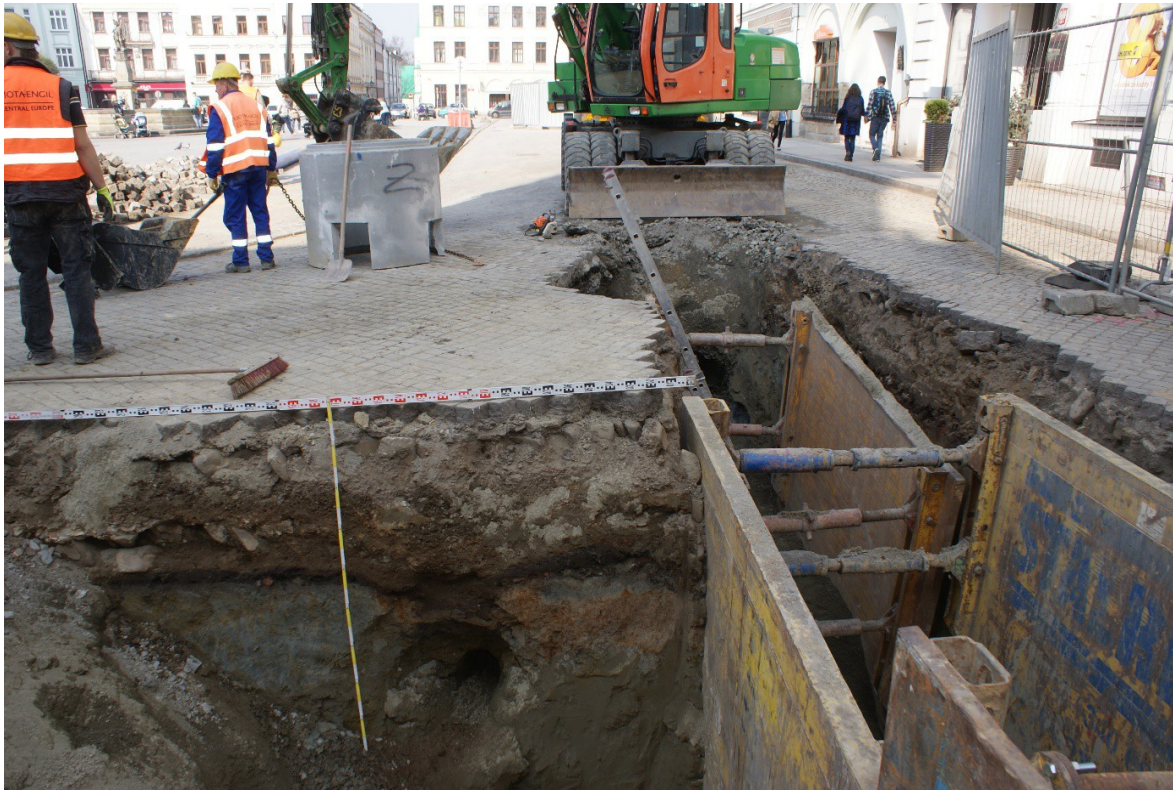
Il. 5.4. Wykop kanalizacyjny pod ratuszem z bardzo wąską warstwą średniowieczną.
