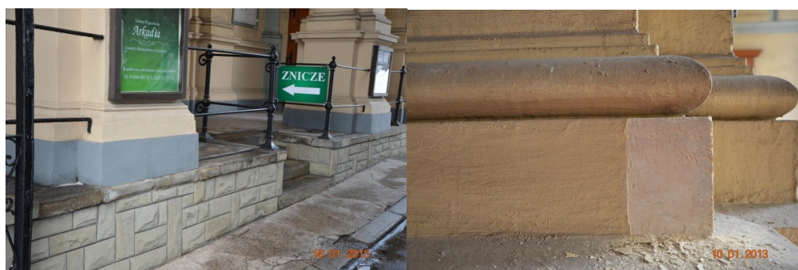
Fot. 29., 30. Brama, sień przejazdowa – współczesna okładzina kamienna (do usunięcia), wtórne zacierki na bazach filarów
