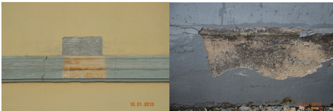
Fot. 7., 8. Stan zachowania. Widoczne przemalowania i zacierki na fragmentach dekoracji.
