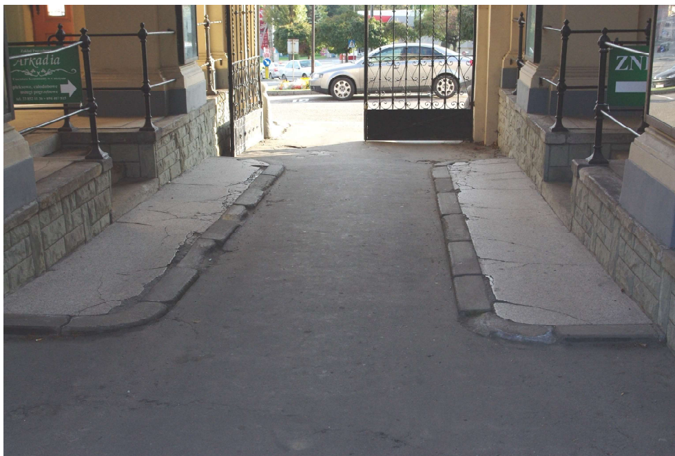
Fot 10: Przejazd przez sień- nawierzchnia do remontu.
