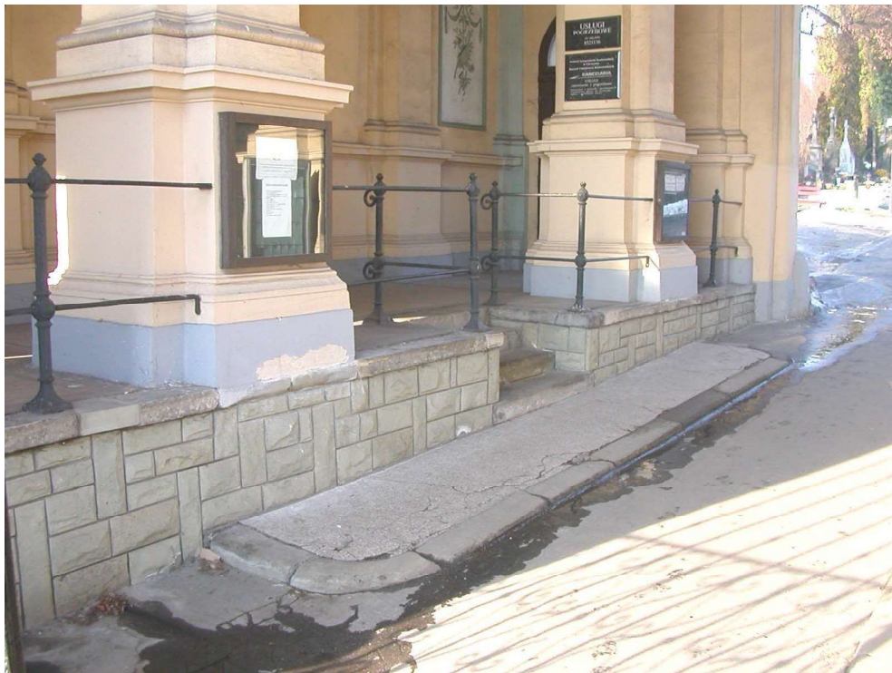
Fot 9: Przejazd przez sień „łupanka” breneńska na cokole do usunięcia.
