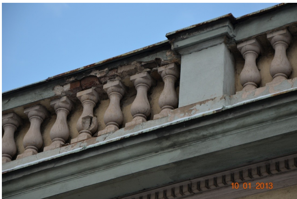
Fot.9. Stan zachowania attyki w formie balustrady na pawilonach bocznych
