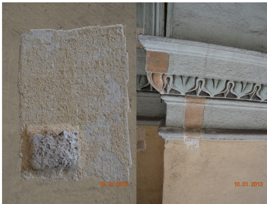
Fot.1, 2. Sondy in situ , widoczne warstwy pierwotnych wypraw
