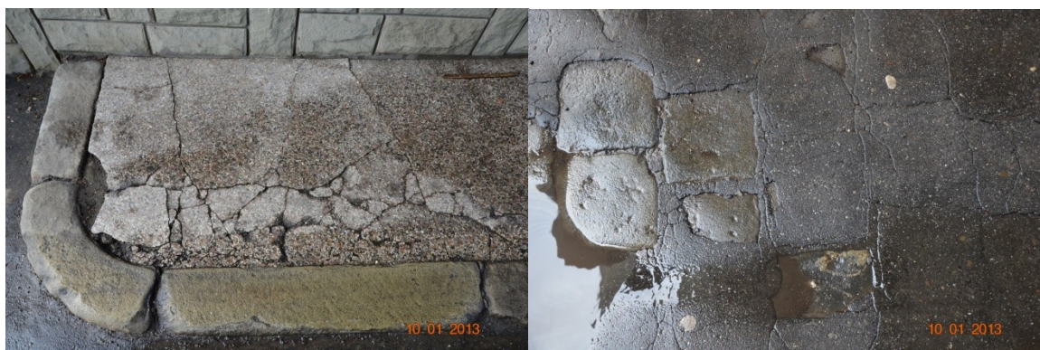
Fot. 23., 24. Sien przejazdowa, stan zachowania – widoczne fragmenty oryginalnego bruku
