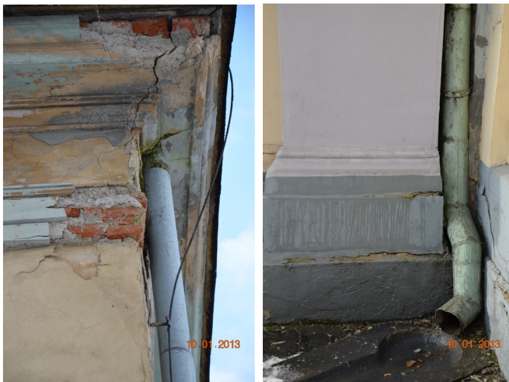
Fot. 3., 4. Stan zachowania. Widoczne zniszczenia spowodowane stałym zawilgoceniem partii elewacji
