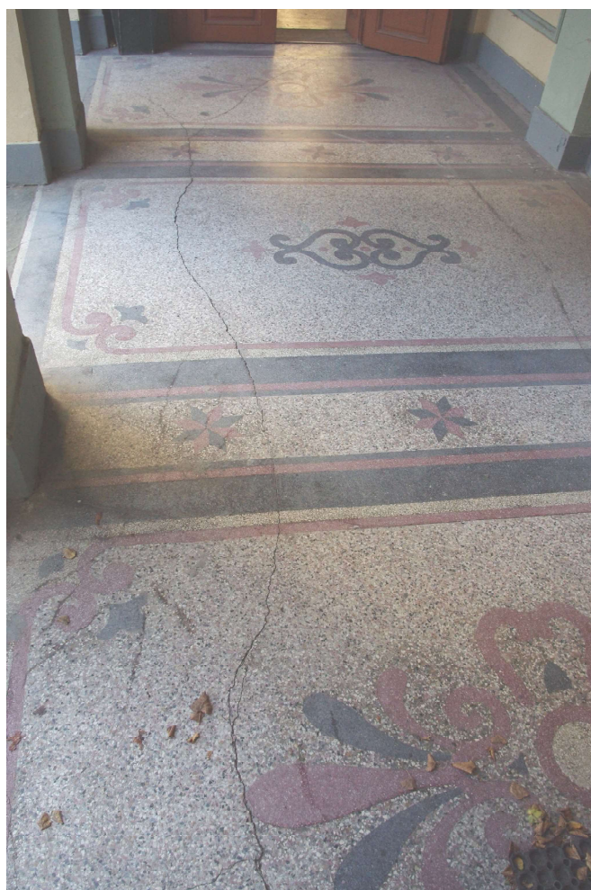
Fot 14: Widok posadzki lastriko do renowacji.
