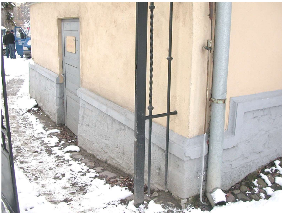
Fot 13: Partie cokołowe- okładziny kamienne do odtworzenia.
