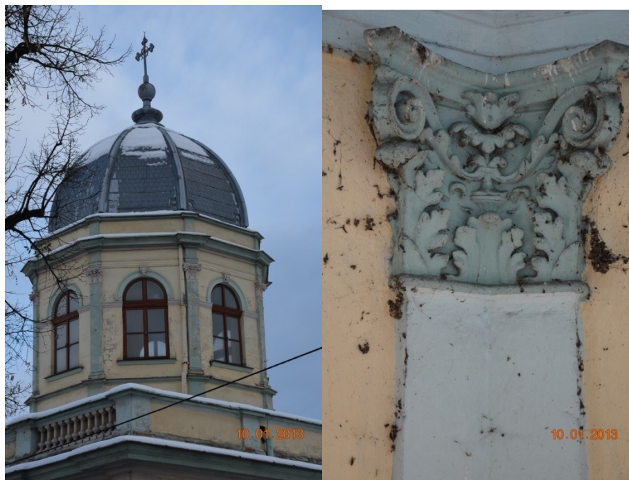
Fot. 5., 6. Stan zachowania. Widoczne zabrudzenie fragmentów dekoracji.
