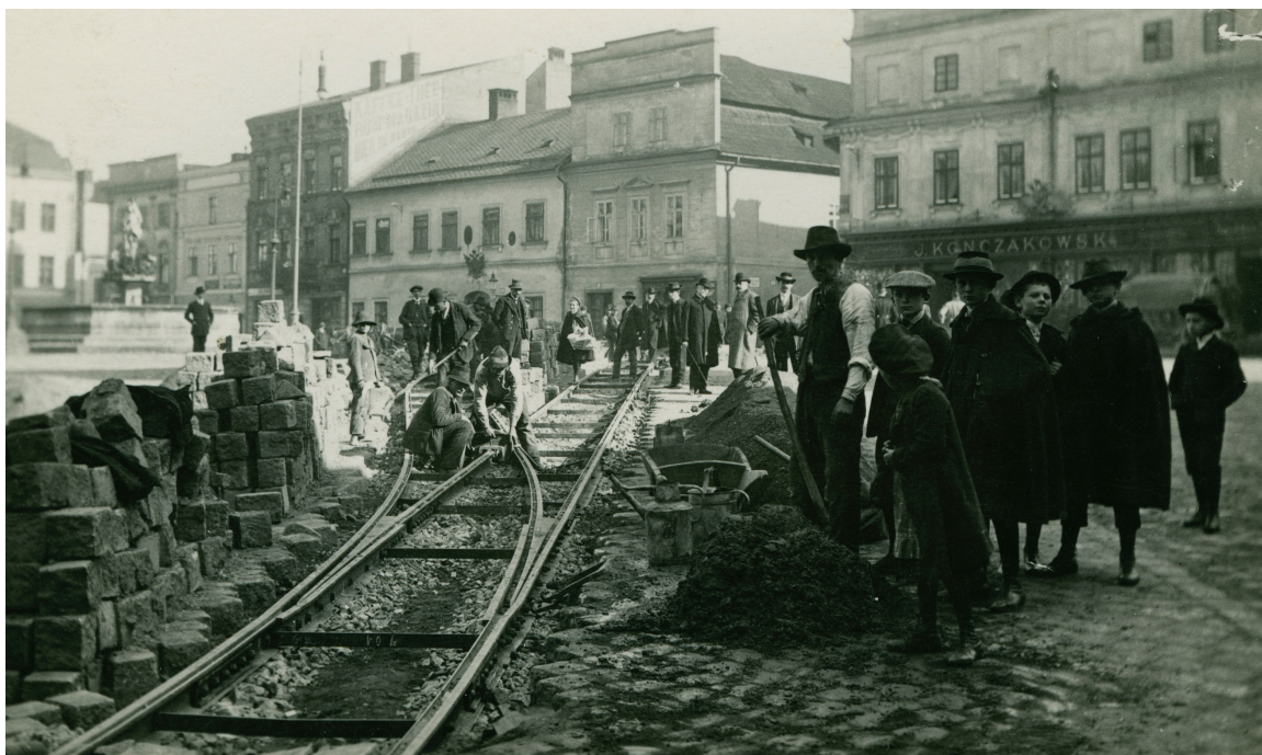
Ryc.13 kładzenie szyn linii tramwajowej, rok 1910
