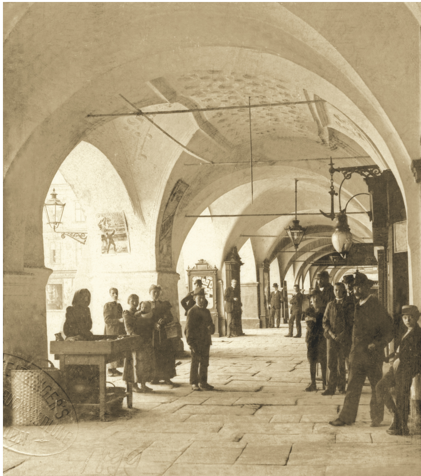
Ryc.16 Podcienia przyrynkowe, tzw. Grosse Laube
