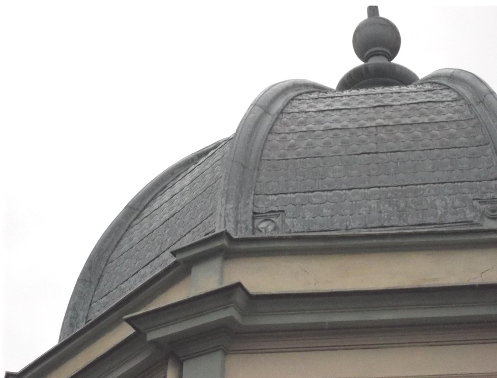
Zdj. 3. Pokrycie dachu- korozja.
