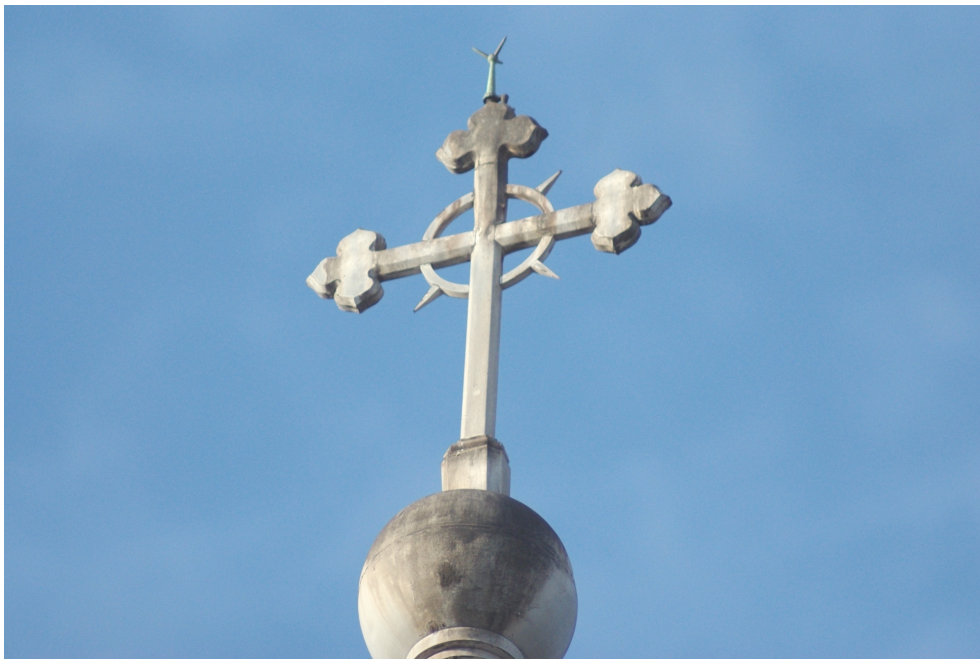
Zdj.5.Krzyż- widok brakującego detalu na obręczy krzyża.
