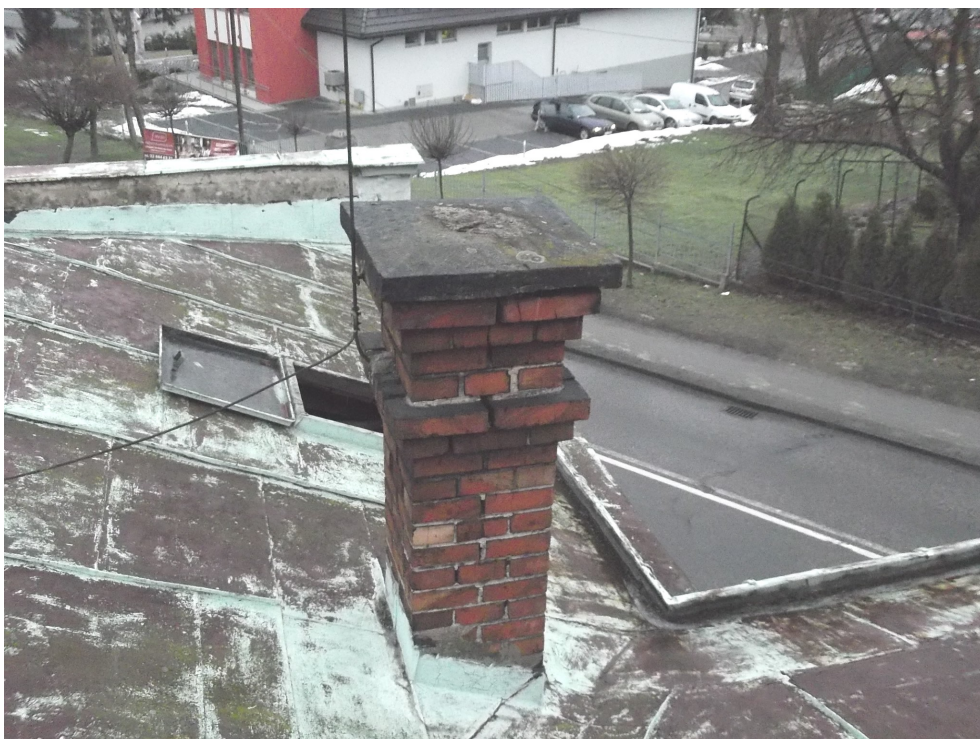
Zdj 6. Komin– do przemurowania.
