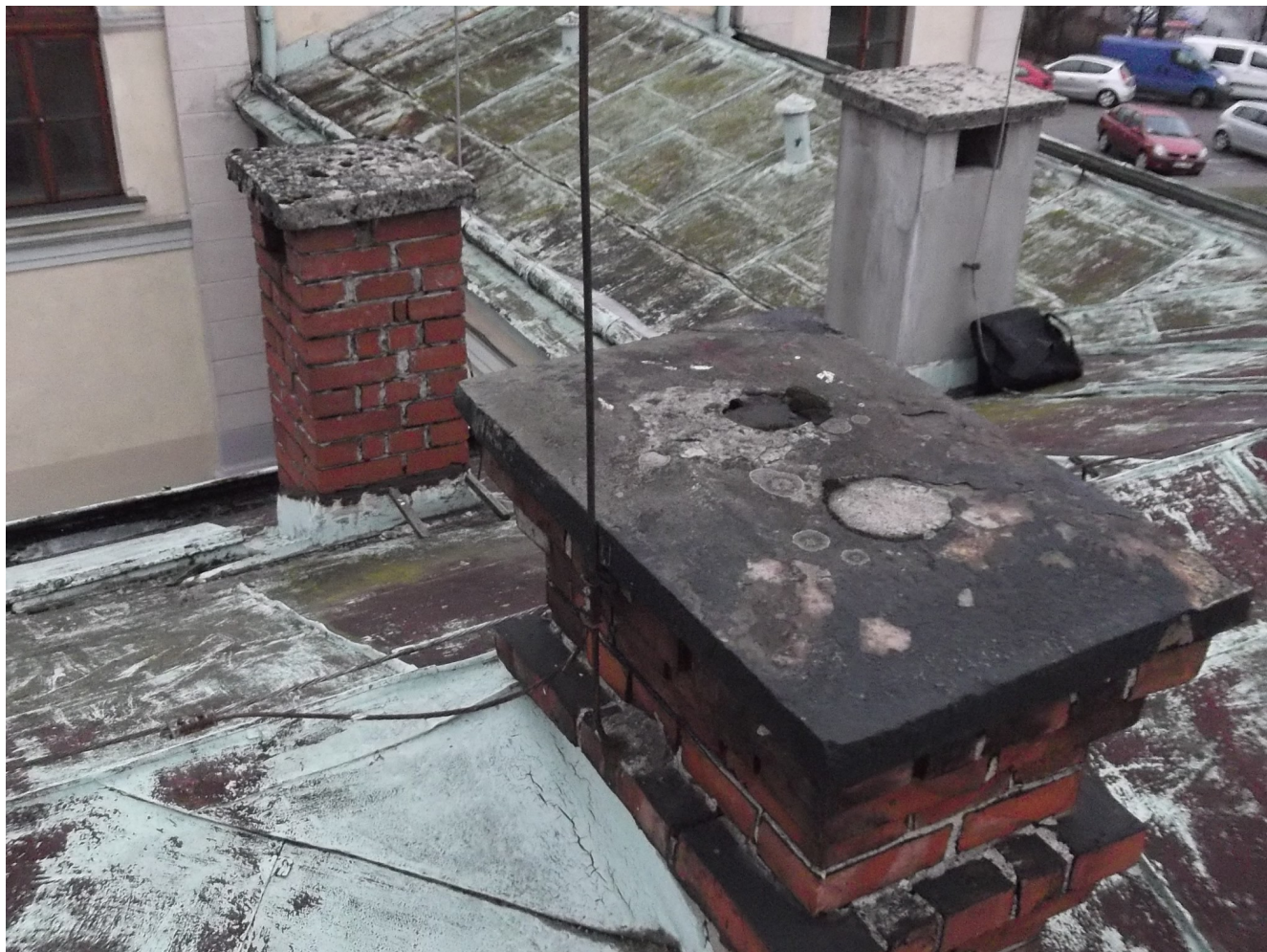
Zdj 7. Komin– do przemurowania.
