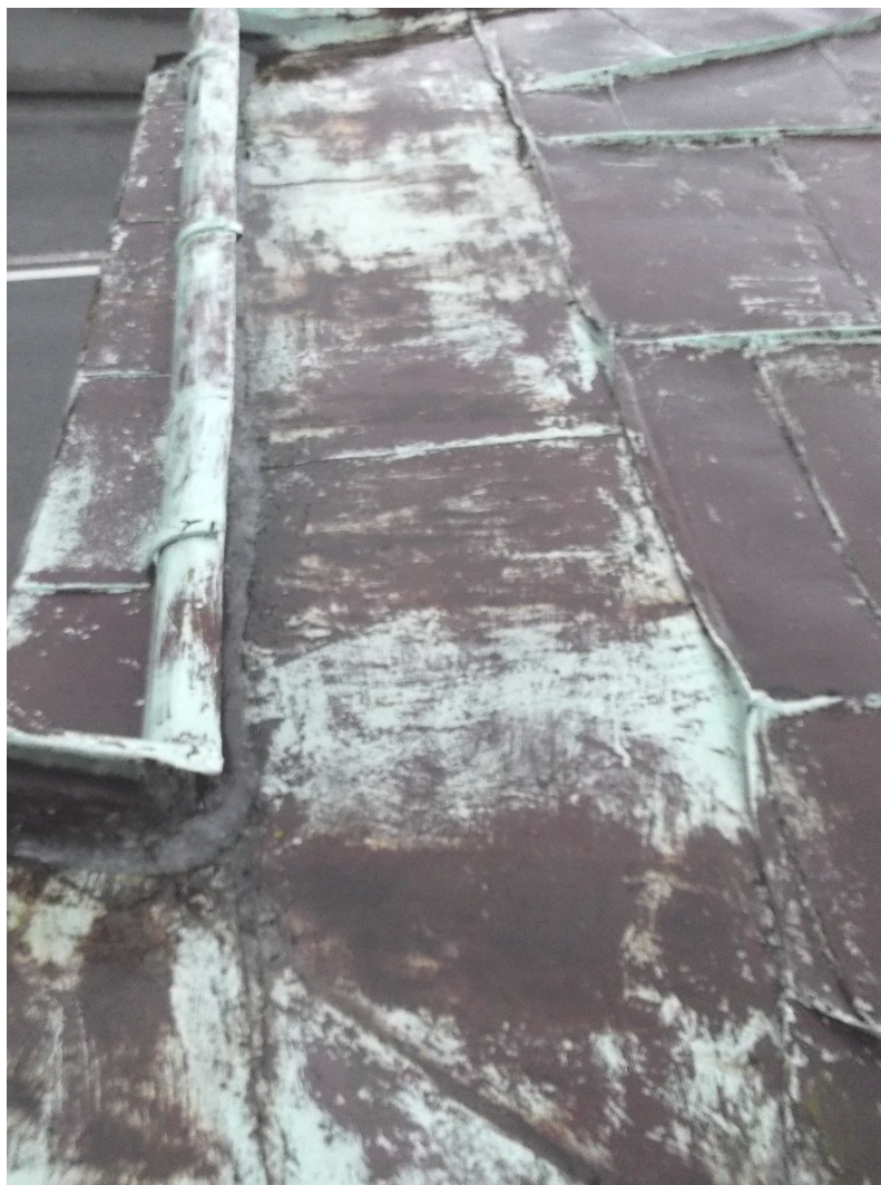
Zdj. 3. Pokrycie dachu- korozja.
