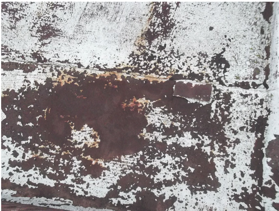
Zdj.1. Stan pokrycia dachu- widoczna korozja.
