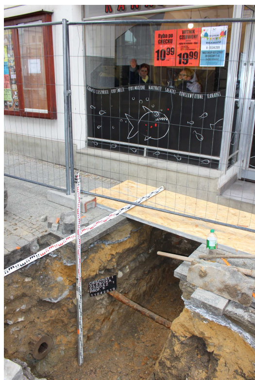
Fot. 22, 23. Sieć wodociągowa odkryta pod kamienicą nr 1 w 2019 r.
