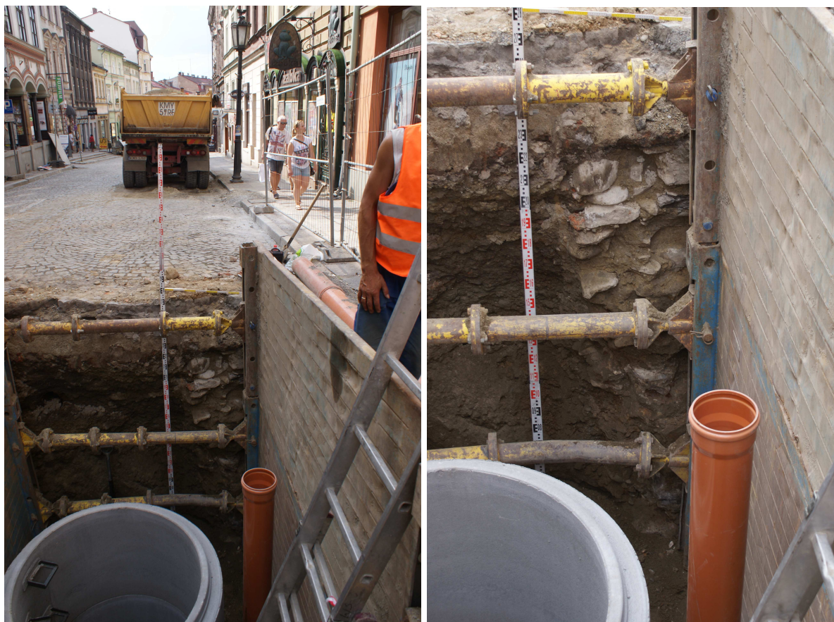
Fot. 25, 26. Wykop kanalizacyjny pod kamienicą nr 18, kamienne fundamenty podcieni
