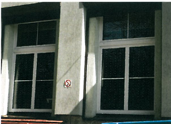
Łatwy w montażu i estetyczny sposób zabezpieczenia szyb produktem Fundacji Szklane Pulapki
