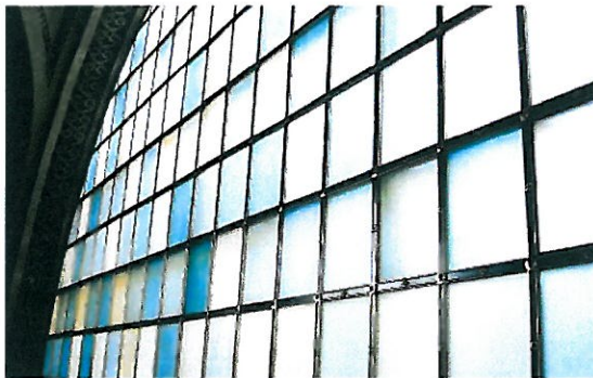
Mleczne, różnokolorowe szklane panele na fasadzie budynku
