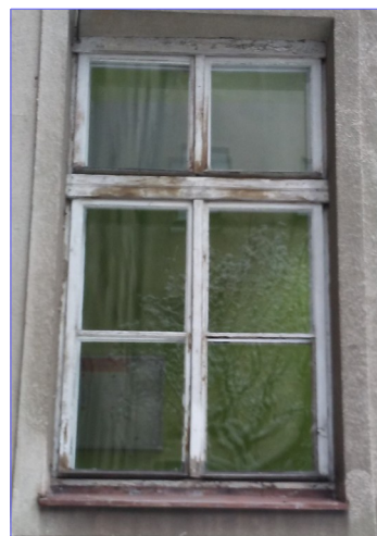
Okno ścianie podwórzowej dot. części 1 PZ
