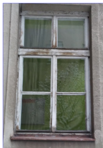
Okno ścianie podwórzowej dot. części 1 PZ
