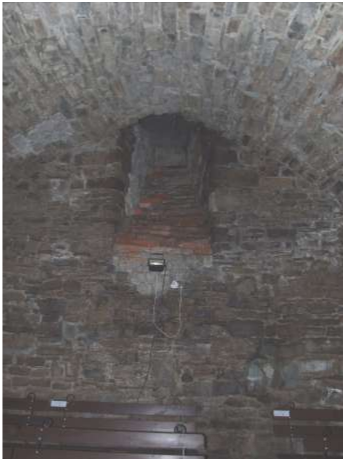
Widok okienka do zamurowania w piwnicy
