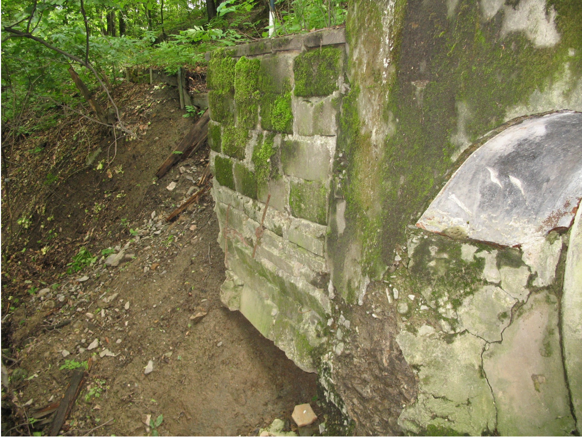
Fot. 7. Wylot. Skrzydło prawobrzeżne.
