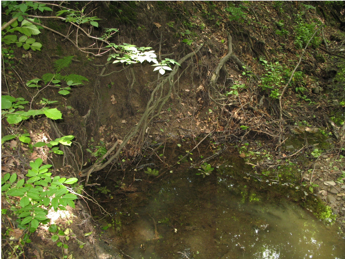
Fot. 9. Ubytki dna potoku poniżej wylotu.
