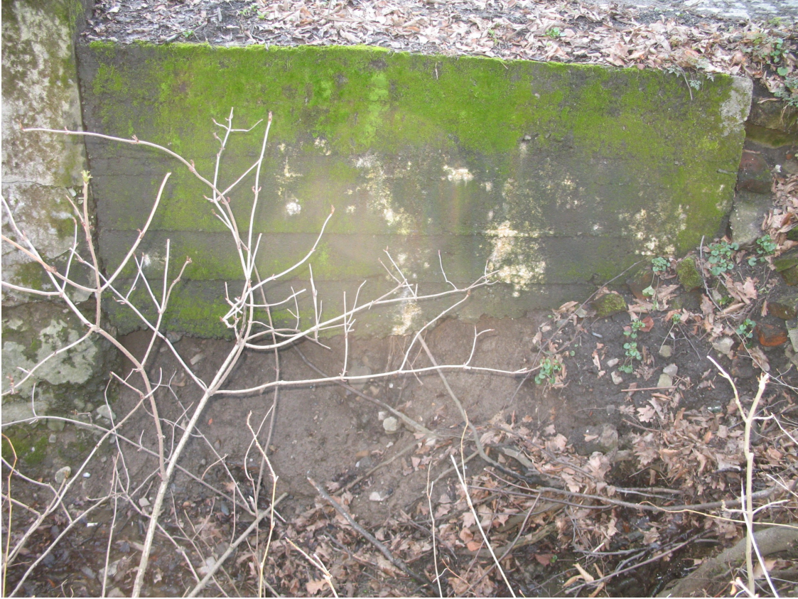
Fot. 5. Wylot. Skrzydło lewobrzeżne.
