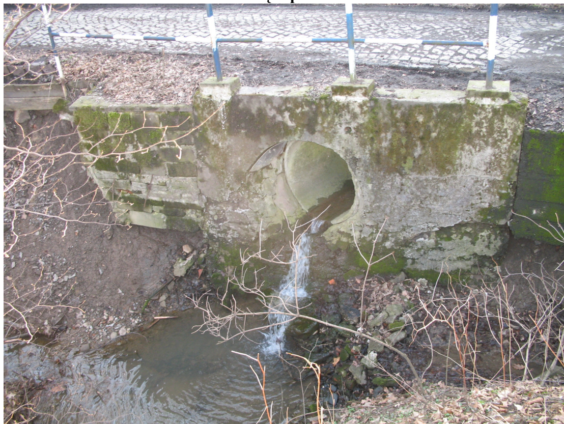
Fot. 4. Obudowa wylotu. Widać skrzydło prawobrzeżne.
