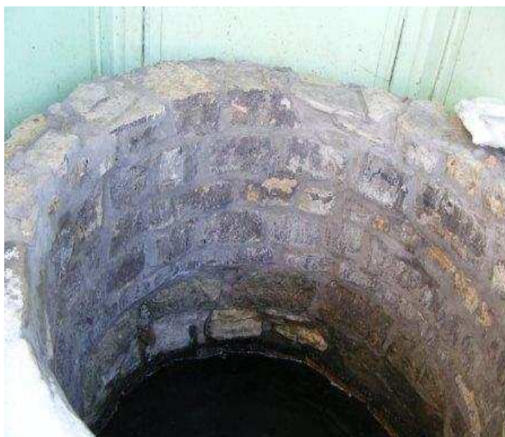
Zdjęcie nr 4 widok na studnię
