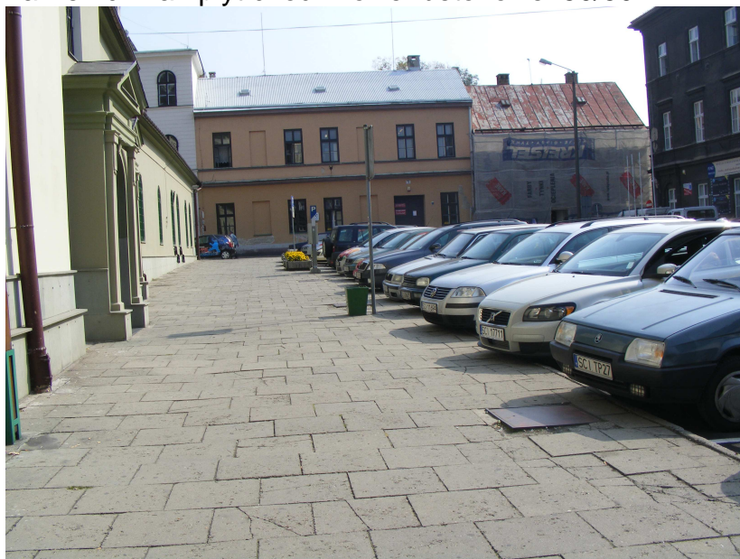
Zdjęcie 027,028 przejazd od strony Pl. Sw Krzyza chodnik wzdłuż zabudowy ł. chodnikowe ulica kostka granitowa 20/20 cm do przebrukowania
