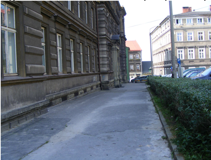
Zdjęcie 020,021 chodnik wzdłuż zabudowy budynku Szkoły i Parafii .
