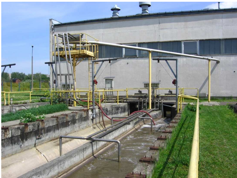
Rys. 16. Widok układu tłoczego pulpy piaskowej.
