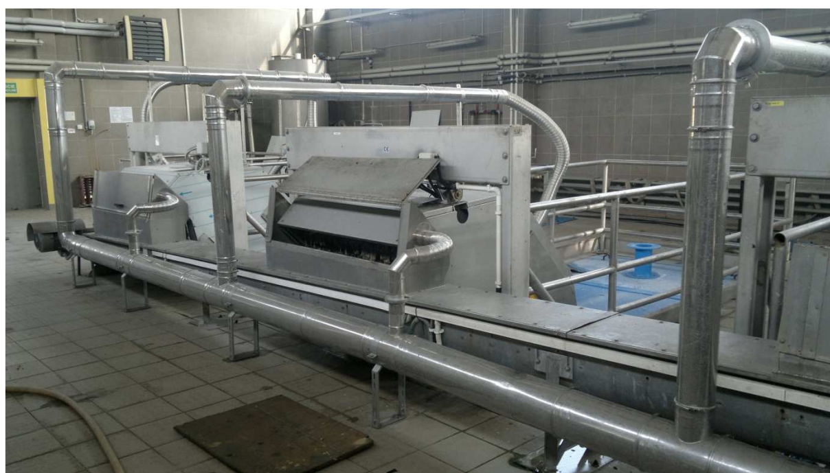
Rys. 7. Widok hermetyzacji układu krat i przenośników skratek.
