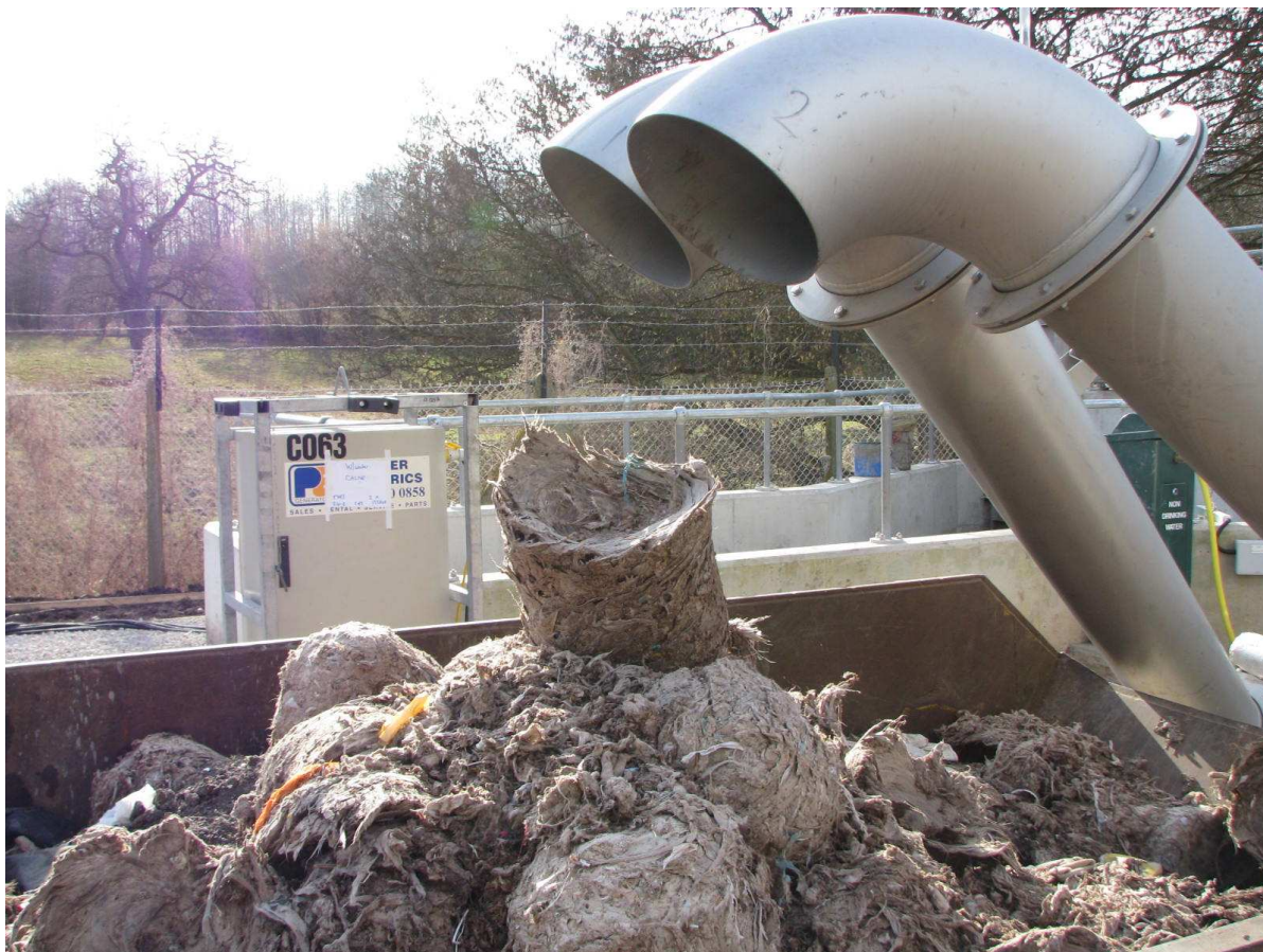
Rys. 5. Widok dobrze odwodnionych i sprasowanych skratek.
