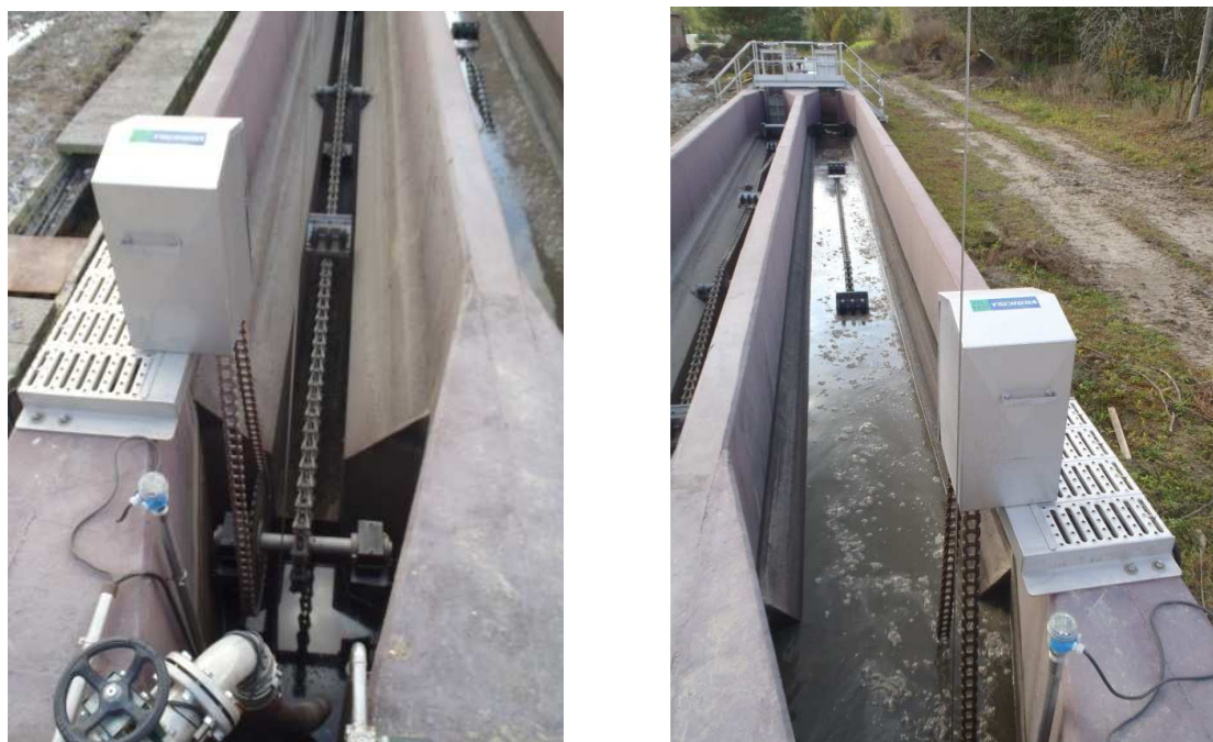
Rys. 10. Układ łańcuchowego zgarniania piasku.
