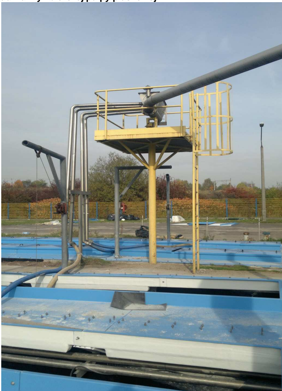
Rys. 12. Układ wanny zbiorczej pulpy piaskowej.
