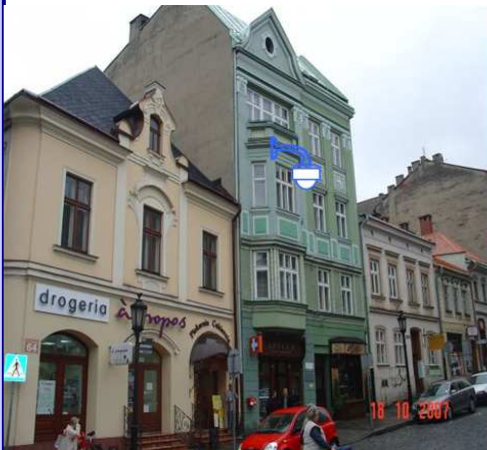
Lewy narożnik budynku przy ulicy Głęboka 62, montaż na wysokości 2p.
