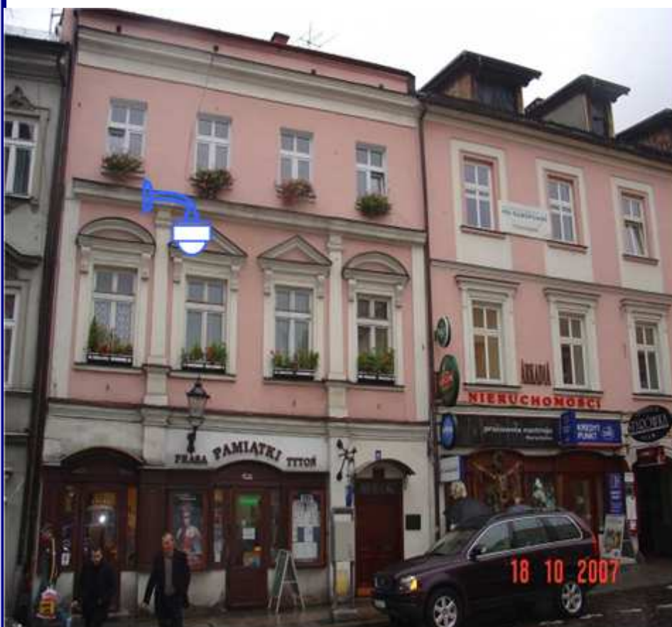
Budynek przy ulicy Mennicza 22, elewacja budynku na wysokości 1p.
