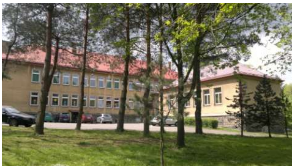
Widok elewacji tylnej
