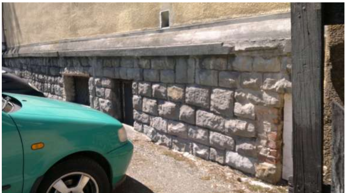
Widok cokołu elewacji tylnej
