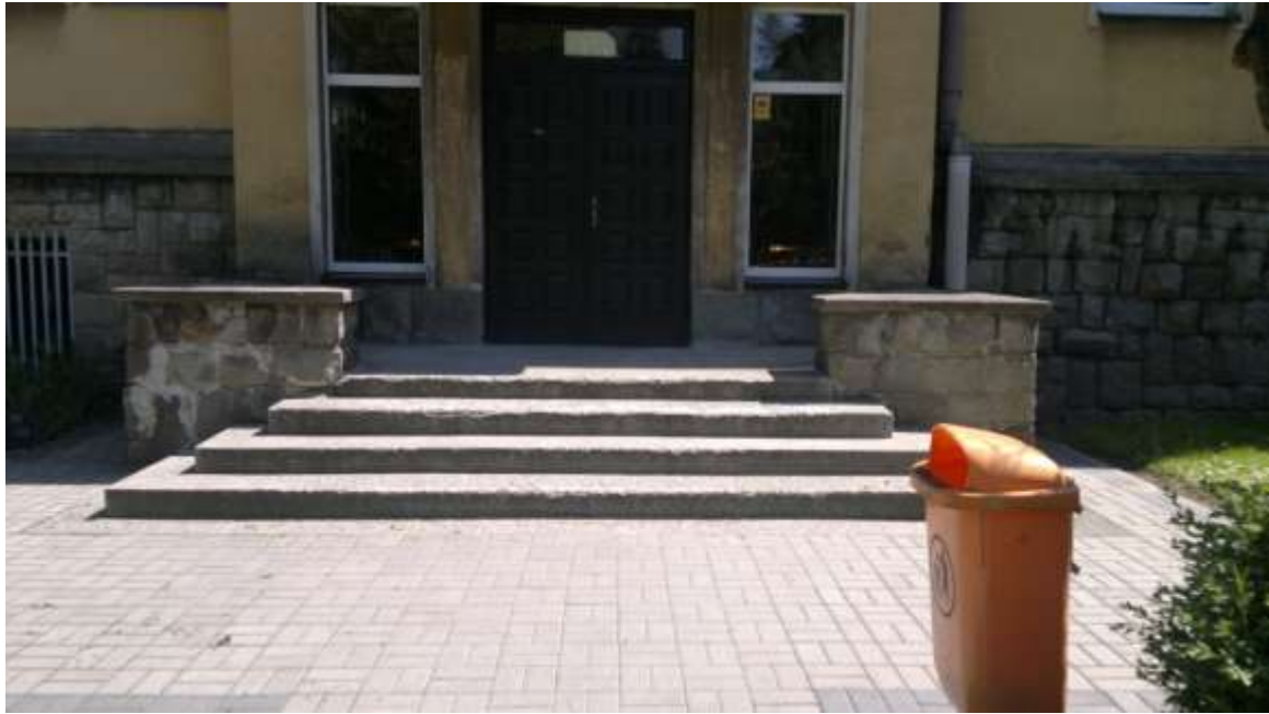
Widok schodów wejście główne , elewacja frontowa
