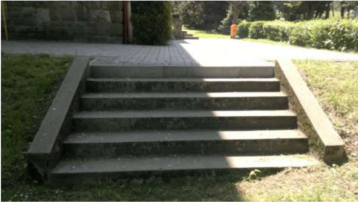
Widok na schody terenowe , stan istniejący
