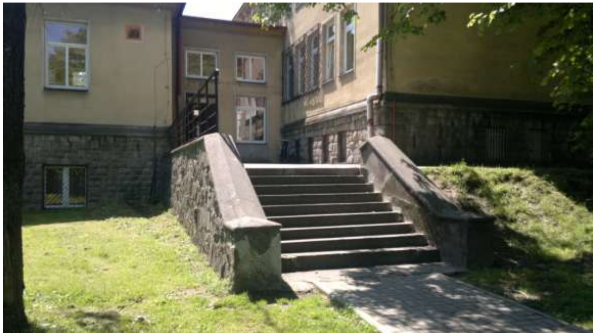
Widok schodów elewacja boczna , zejście na boiska
