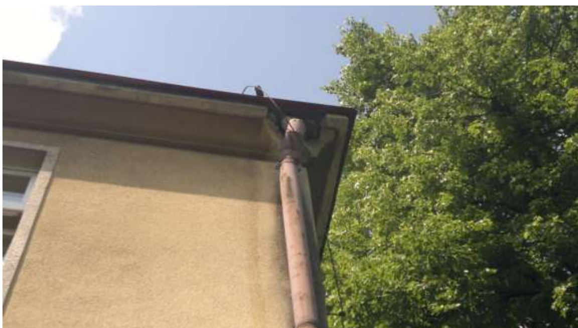
Widok gzymsu wieńczącego
