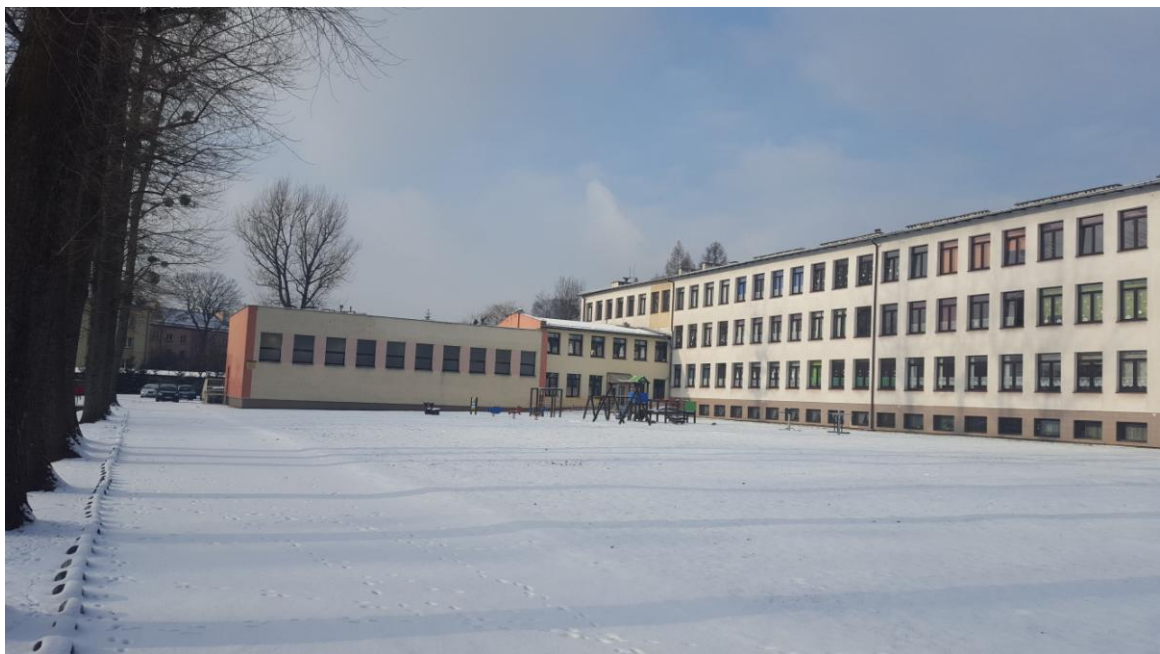
Elewacja tylna - stan istniejący
