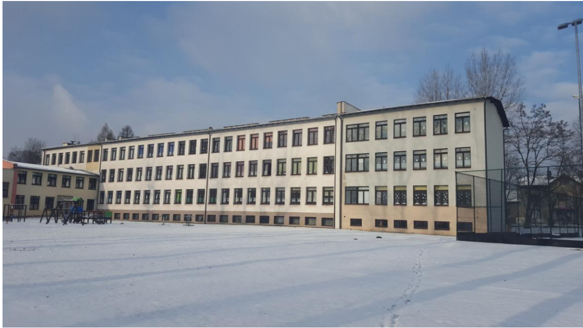
Elewacja tylna - stan istniejący
