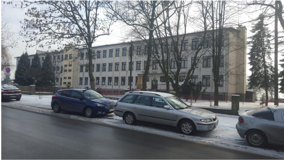
Elewacja frontowa – stan istniejący
