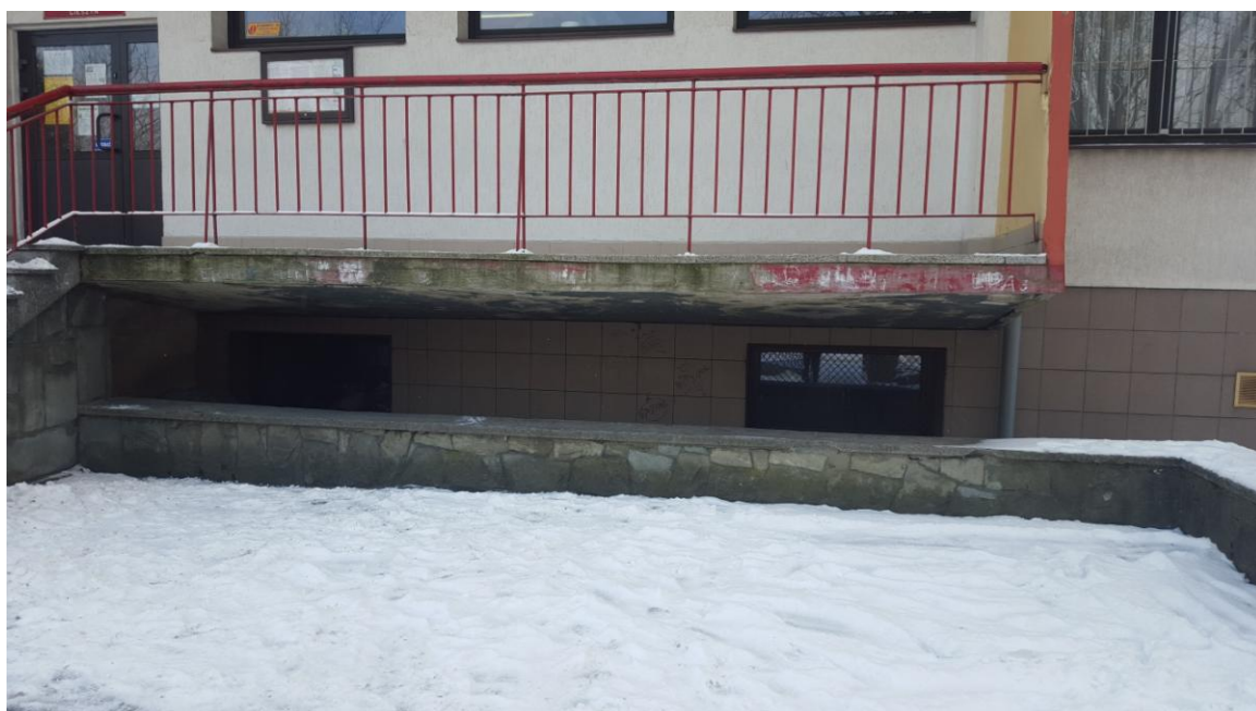
Elewacja frontowa – stan istniejący
