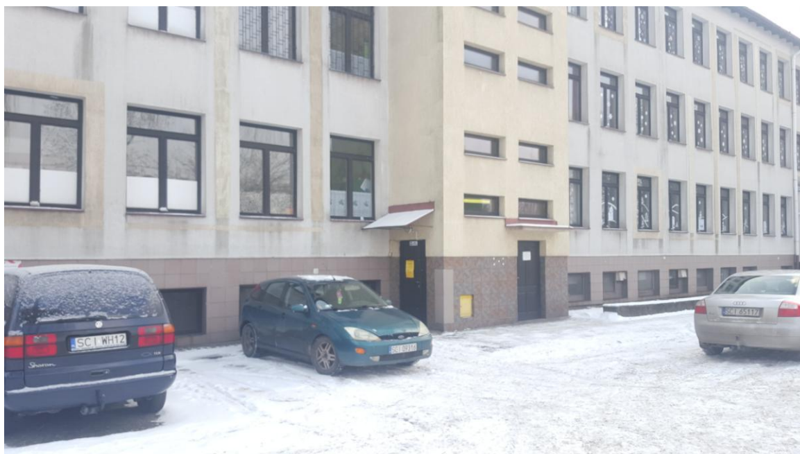
Elewacja frontowa – stan istniejący
