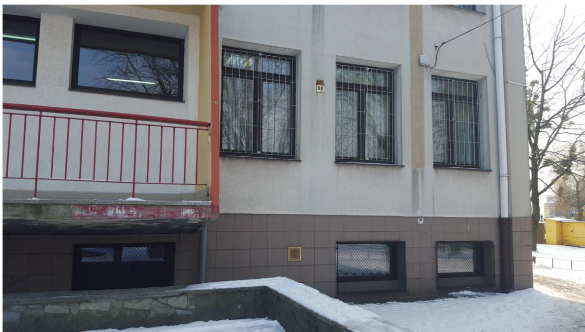
Elewacja frontowa – stan istniejący
