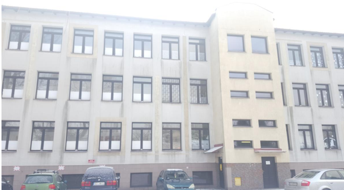
Elewacja frontowa – stan istniejący
