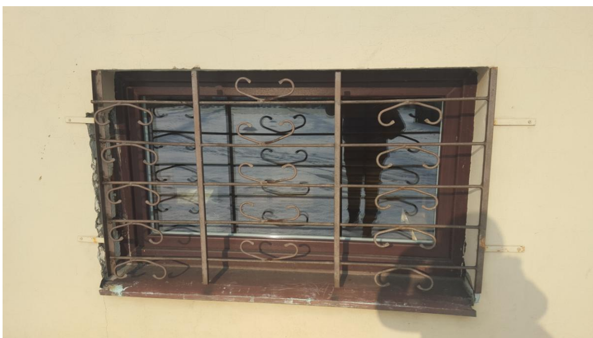
Elewacja tylna – stan istniejący
