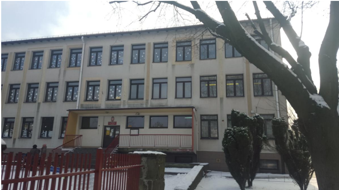
Elewacja frontowa – stan istniejący
