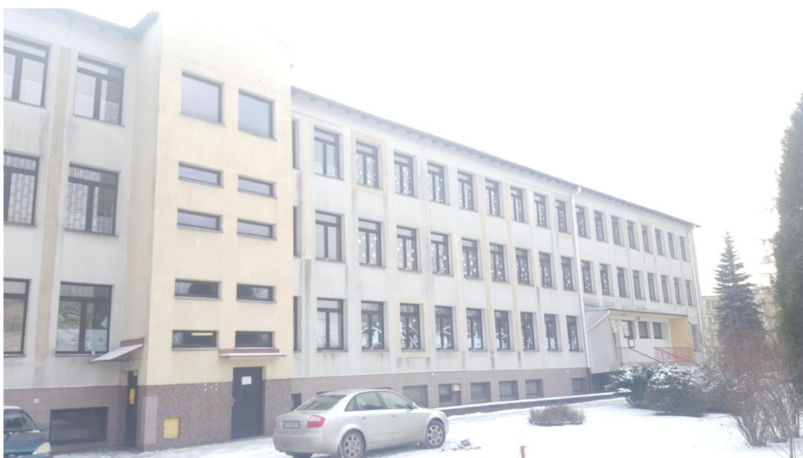
Elewacja frontowa – stan istniejący
