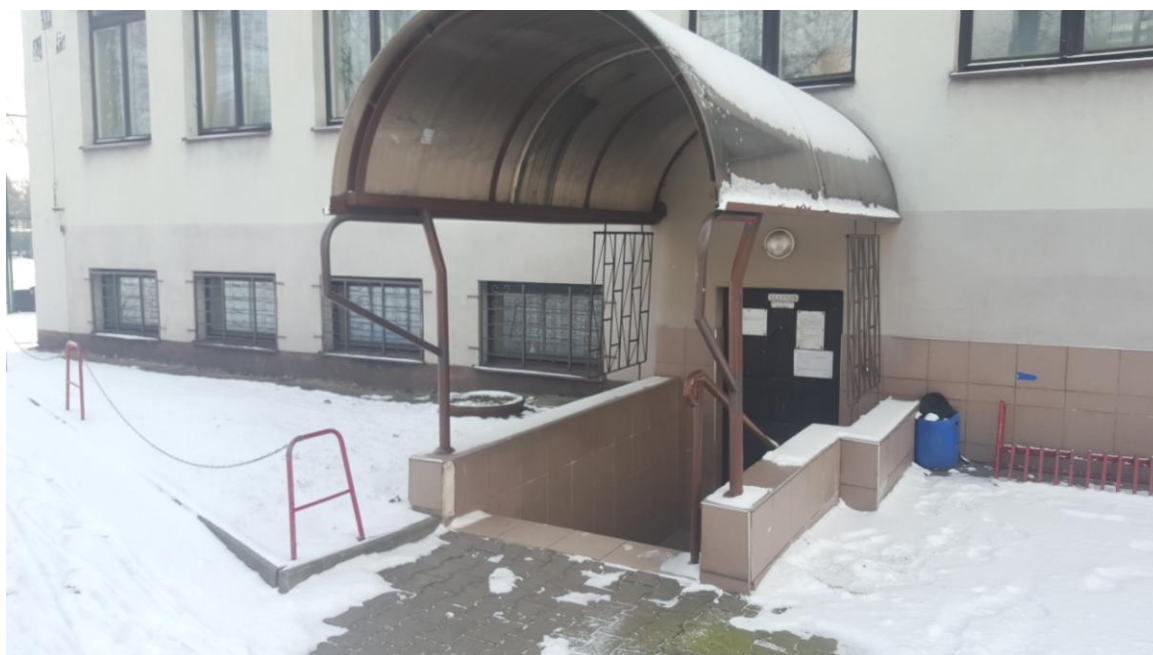
Elewacja frontowa – stan istniejący
