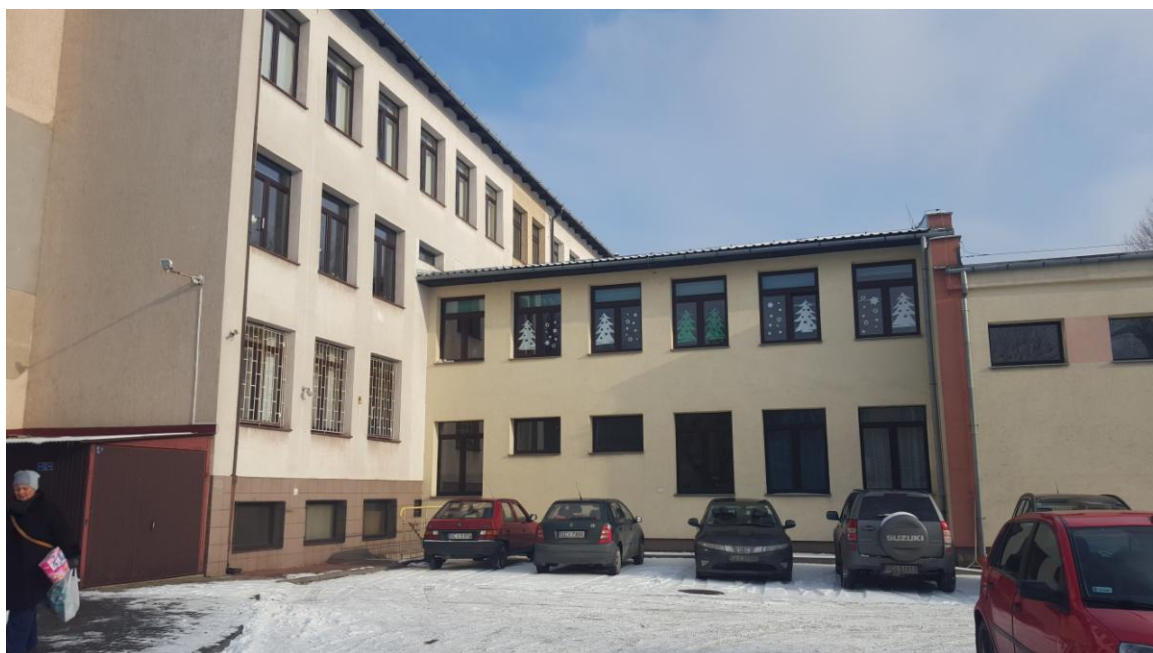
Elewacja tylna - stan istniejący
