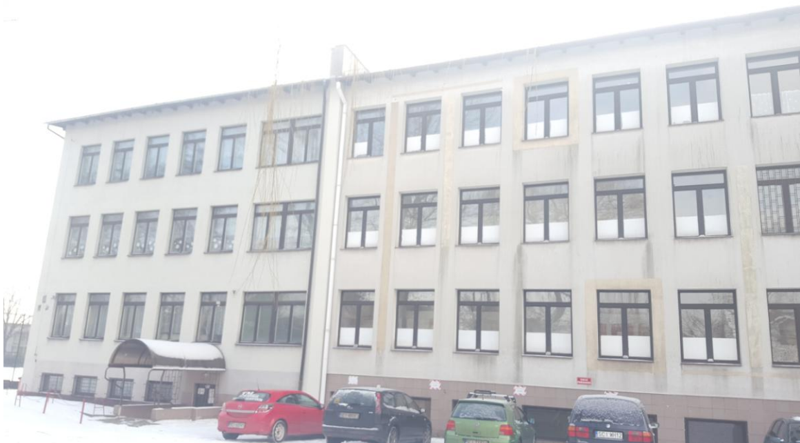
Elewacja frontowa – stan istniejący
