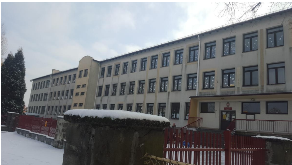
Elewacja frontowa – stan istniejący
