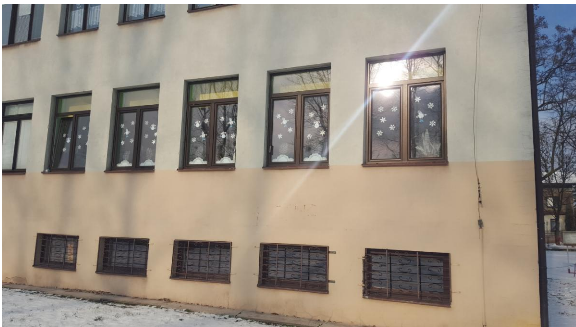
Elewacja tylna – stan istniejący
