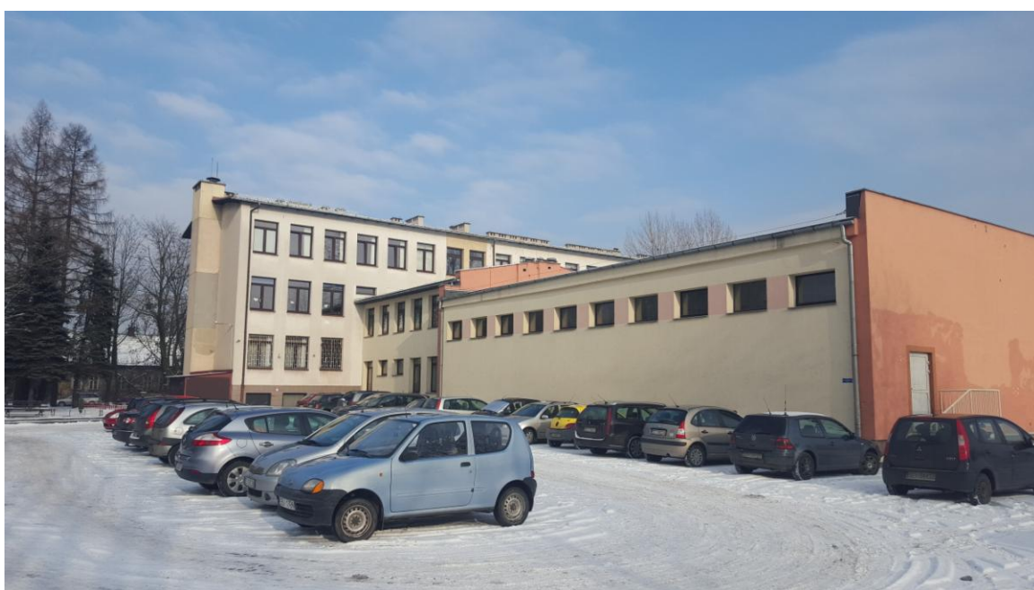
Elewacja tylna - stan istniejący
