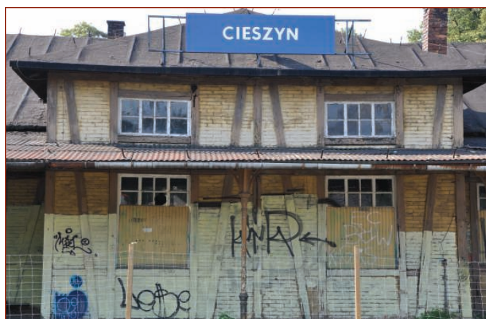
Fot. 14. Ryzalit w ścianie od strony peronów
