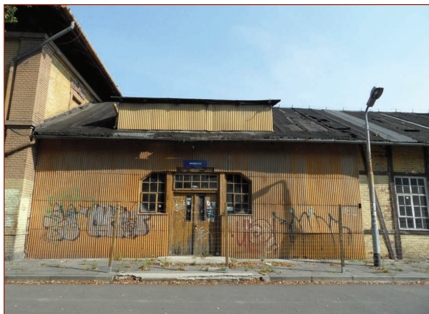
Fot. 16. Część ściany przy ul. Hajduka oraz naświetle dachowe pokryto blachą trapezową
