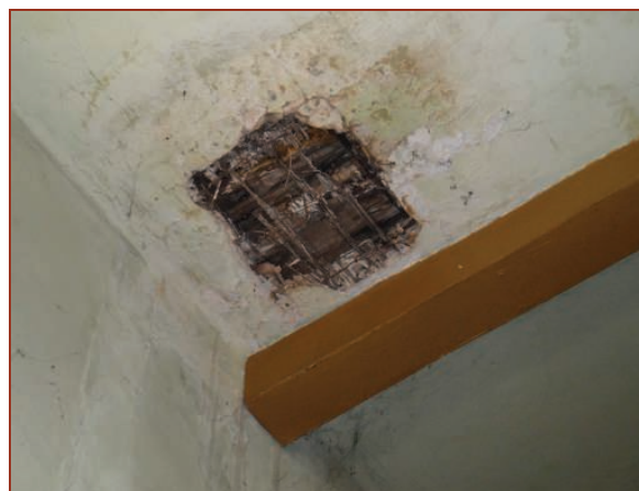
Fot. 32b. Odkrywka sufitu w pomieszczeniu nr 3.10.
