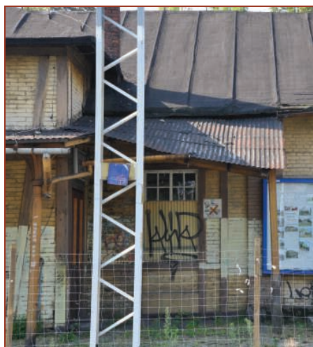
Fot. 66a. Daszek o konstrukcji drewnianej
