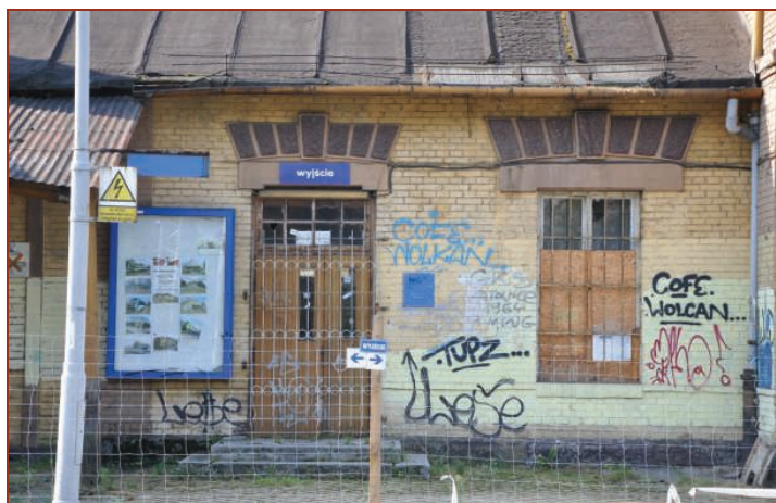
Fot.29. Drzwi hallu głównego i okno kasy w ścianie od strony peronów
