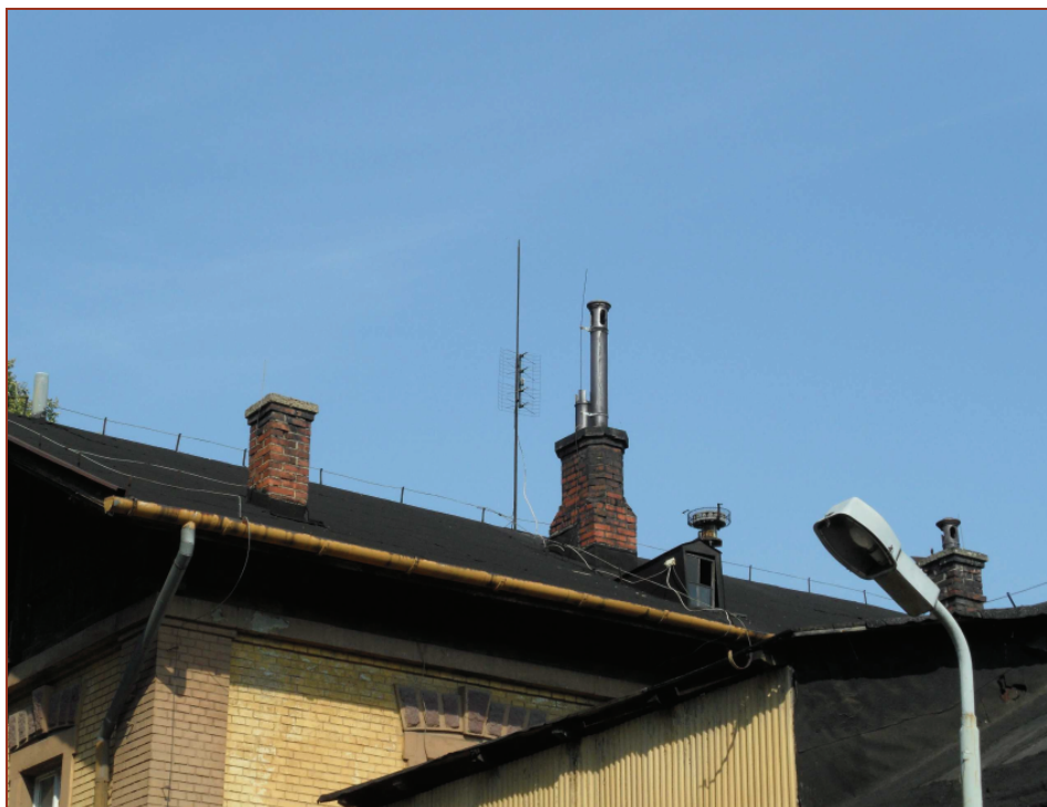
Fot.25. Kominy ponad dachem murowane z cegły klinkierowej
