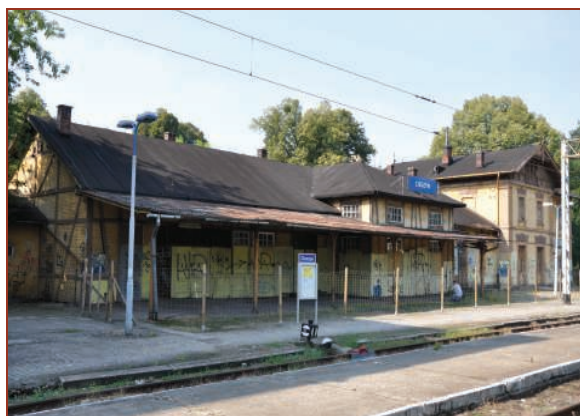
Fot. 12. Budynek parterowy – widok od strony peronów
