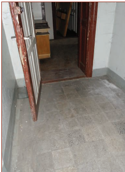
Fot. 21. Posadzka z płytek lastrykowych w korytarzu
