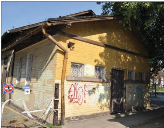
Fot. 67. Ściana szczytowa i boczna budynku wc
