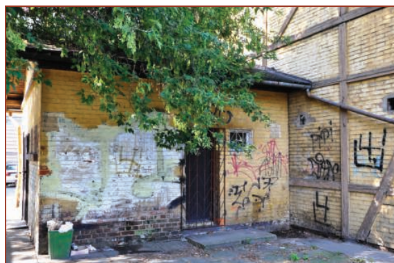
Fot. 19. Budynek wc – widok od strony peronów
