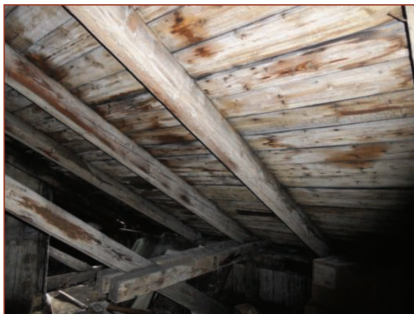
Fot. 48. Zamknięte elementy więźby krokiew i deskowanie
