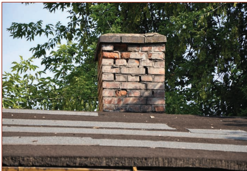
Fot. 64. Komin ponad dachem budynku parterowego
