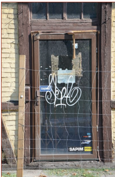
Fot.35. Drzwi wejściowe do pomieszczenia 3.5
