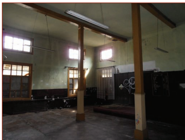
Fot.32a. Budynek parterowy – część 3 wnętrze pomieszczenia nr 3.10
