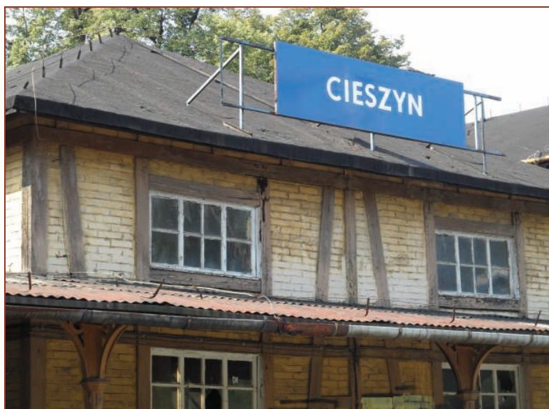
Fot. 57. Oczep i rygle okienne
