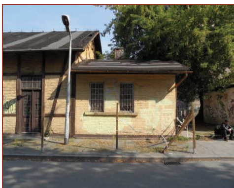
Fot. 18. Budynek wc – widok od ul. Hajduka
