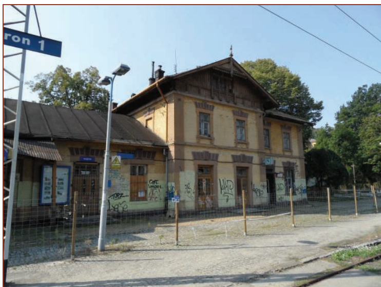
Fot. 6. Budynek wraz ze ścianą poczekalni od strony peronów stanowią najstarszą część zabudowań dworca
