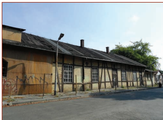
Fot. 13. Budynek parterowy – widok od ul. Hajduka
