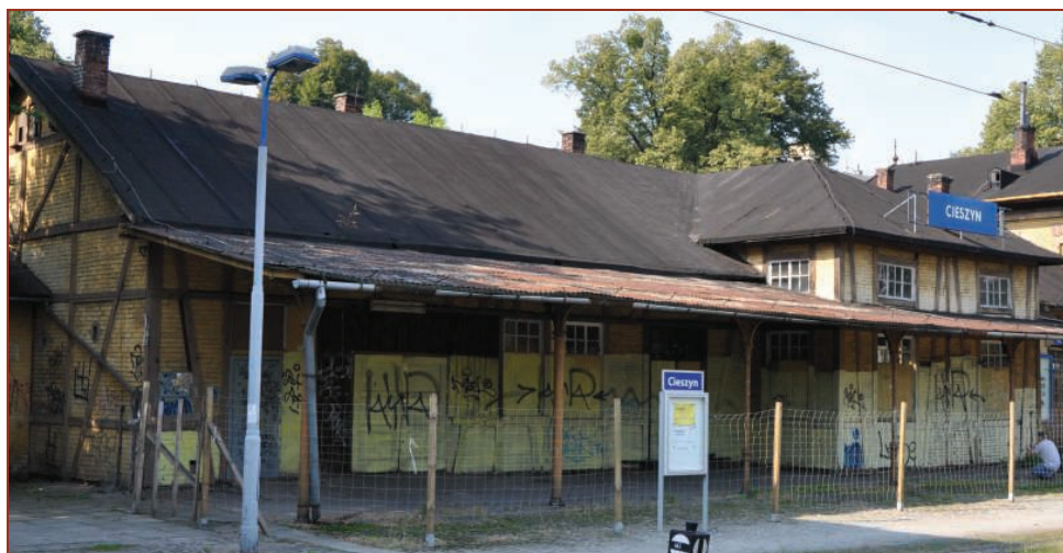
Fot.31. Budynek parterowy – część 3 – widok od strony peronów
