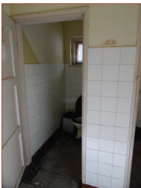
Fot.36. Wnętrze toalety męskiej
