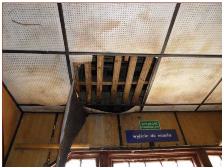
Fot.28. Odkrywka sufitu podwieszonego w hallu głównym
