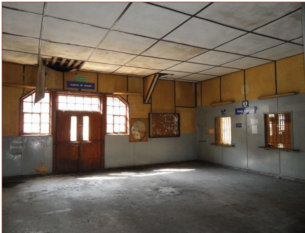
Fot.26. Budynek parterowy – część 2 – hall główny dworca kolejowego (pomieszczenie nr 2.1)
