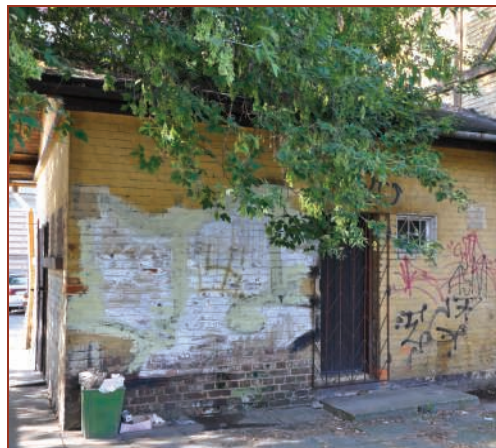
Fot. 68. Ściana boczna bud. wc od strony peronów
