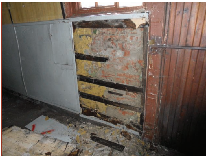
Fot.27. Odkrywka boazerii na ścianie zewnętrznej w hallu głównym dworca
