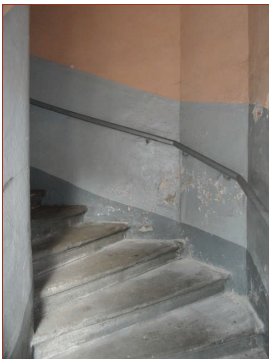
Fot. 22. Schody w budynku piętrowym
