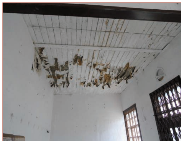
Fot. 62. Strop w pomieszczeniach 3.5 i 3.6
