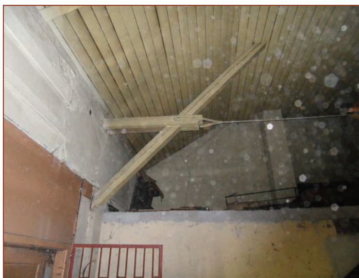
Fot. 17. Zastrzał i ściąg więzara głównego w pomieszczeniu nr 3.12
