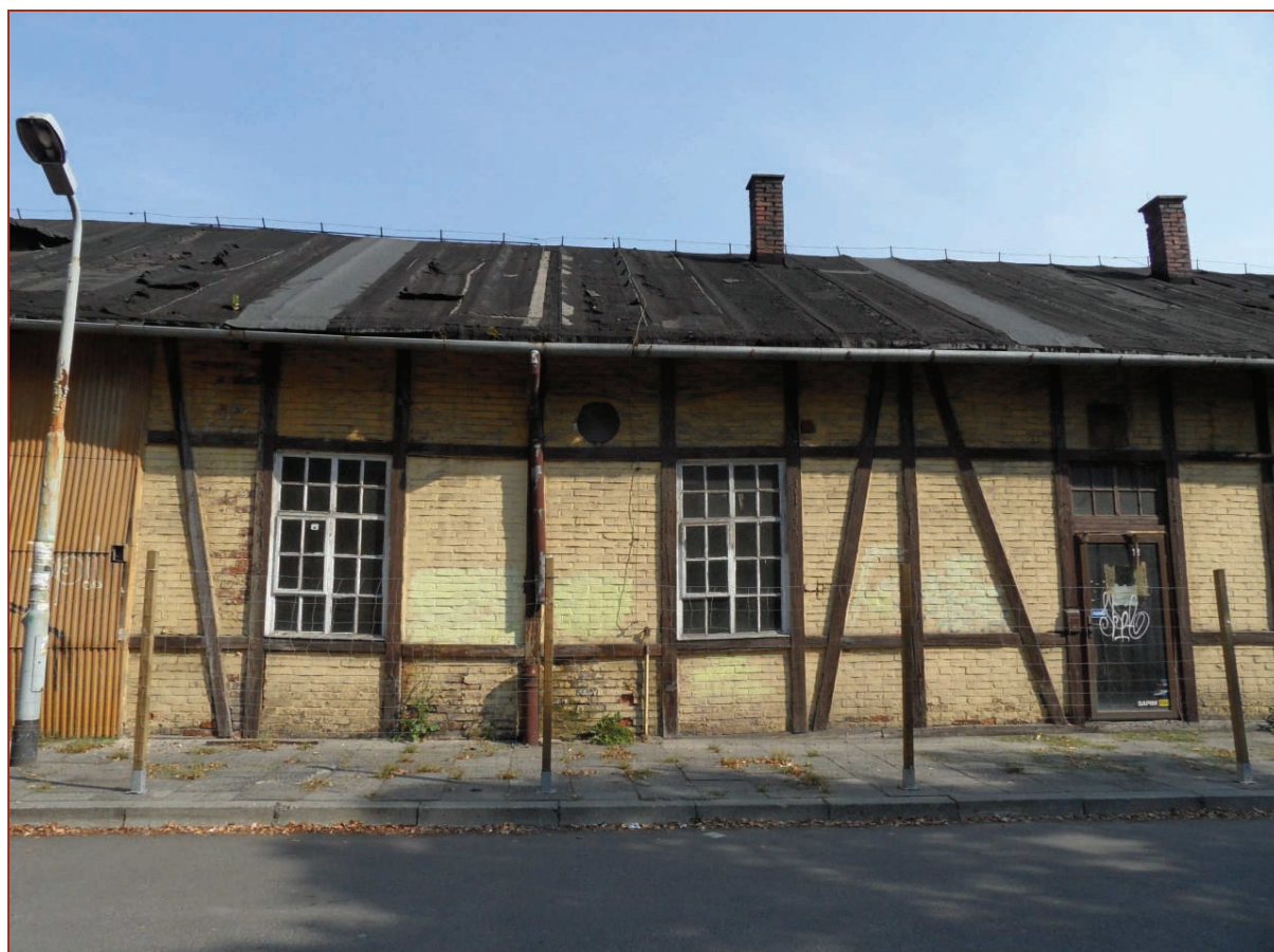
Fot. 15. Fragment muru pruskiego – widok od ulicy Hajduka
