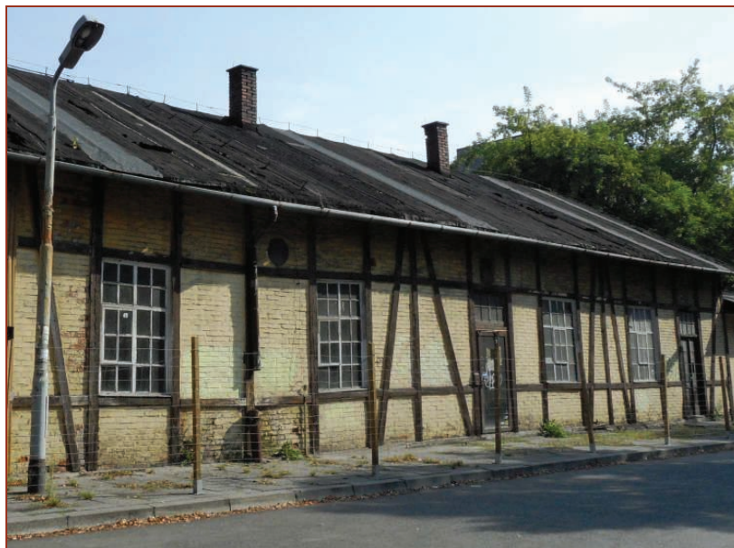
Fot.30. Budynek parterowy – część 3 – widok z ul. Hajduka
