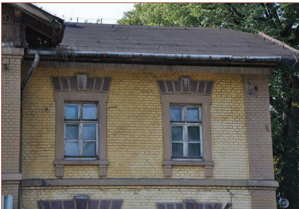
Fot. 23. Okna drewniane skrzynkowe malowane farbą olejną w kolorze białym
