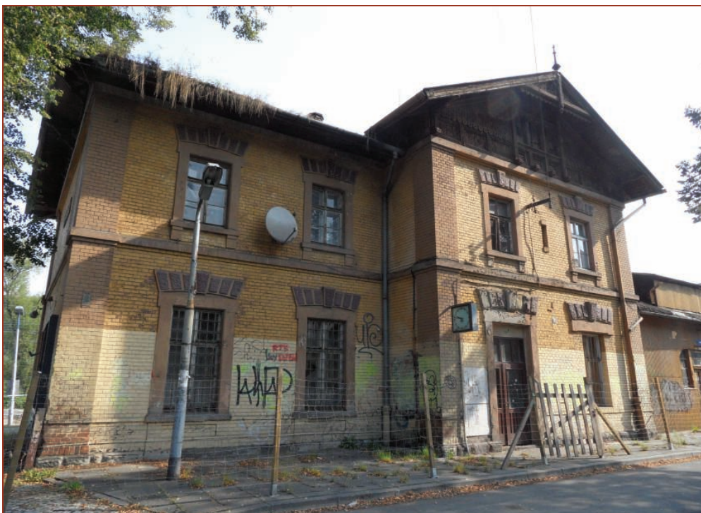
Fot. 4. Część 1 – budynek piętrowy – widok od ulicy Hajduka
