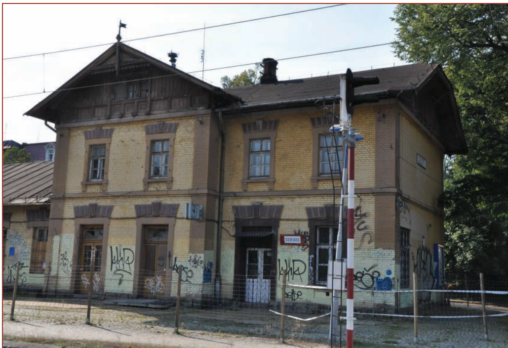
Fot. 5. Część 1 – budynek piętrowy – widok od strony peronów
