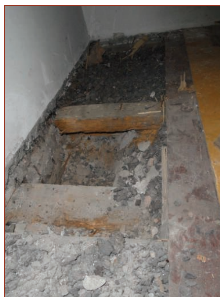
Fot. 9. Odkrywka stropu o rozpiętości 6,82 m nad parterem
