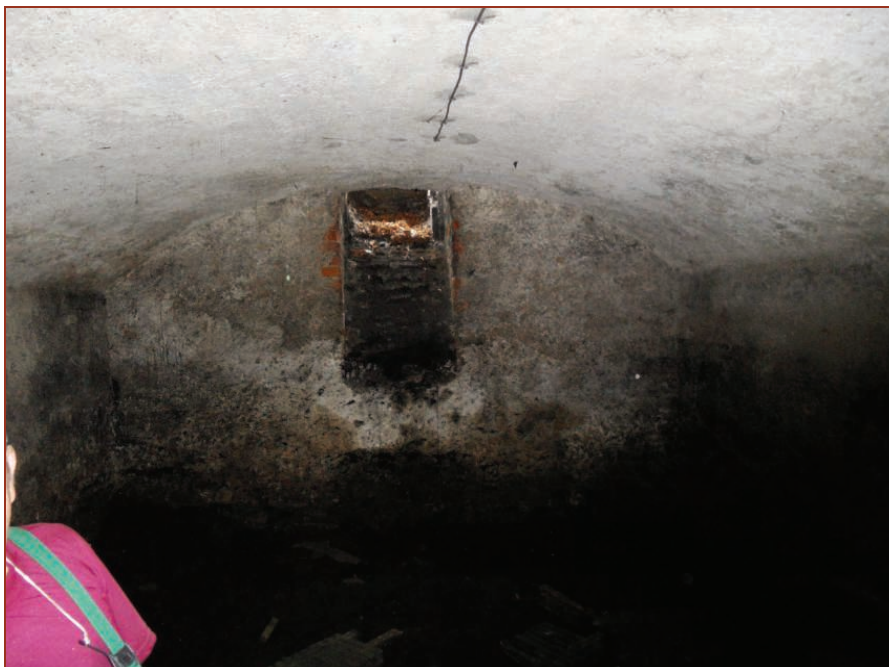
Fot. 39. Piwnica w budynku piętrowym
