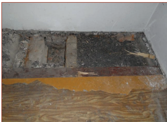
Fot. 8. Odkrywka stropu o rozpiętości 6,82 m nad parterem
