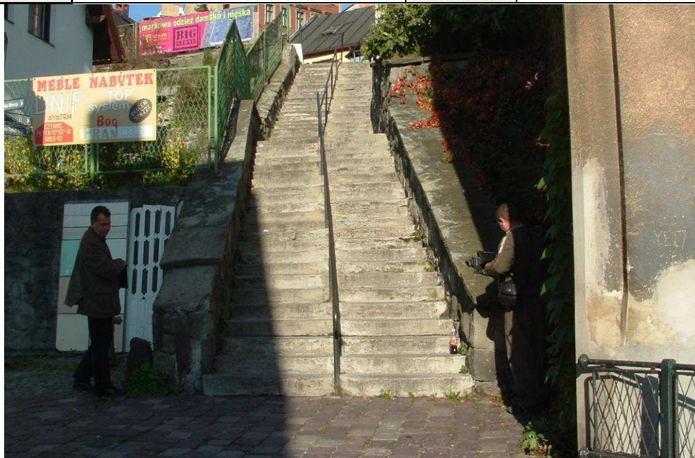
Fot. Widok schodów
