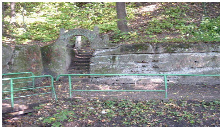
Widok muru betonowego MK-2 przewidzianego do naprawy i konserwacji
