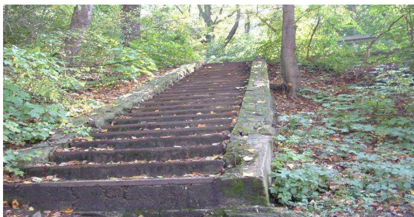
Fot. Widok schodów
