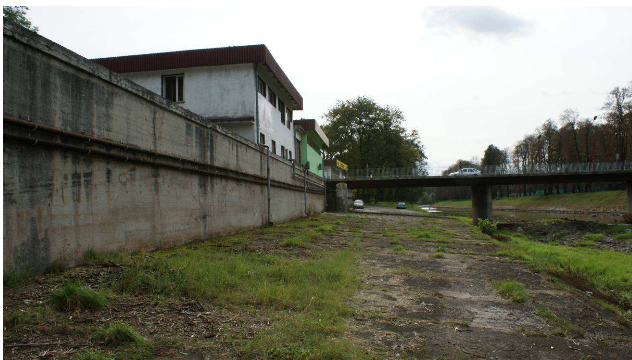
Widok betonowych płyt za budynkiem byłej straży granicznej – stan istniejący
