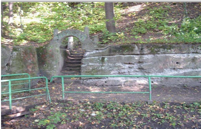
Widok muru betonowego MK-2 przewidzianego do naprawy i konserwacji
