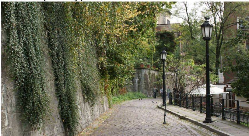
Widok muru MK-1 przewidzianego do konserwacji
