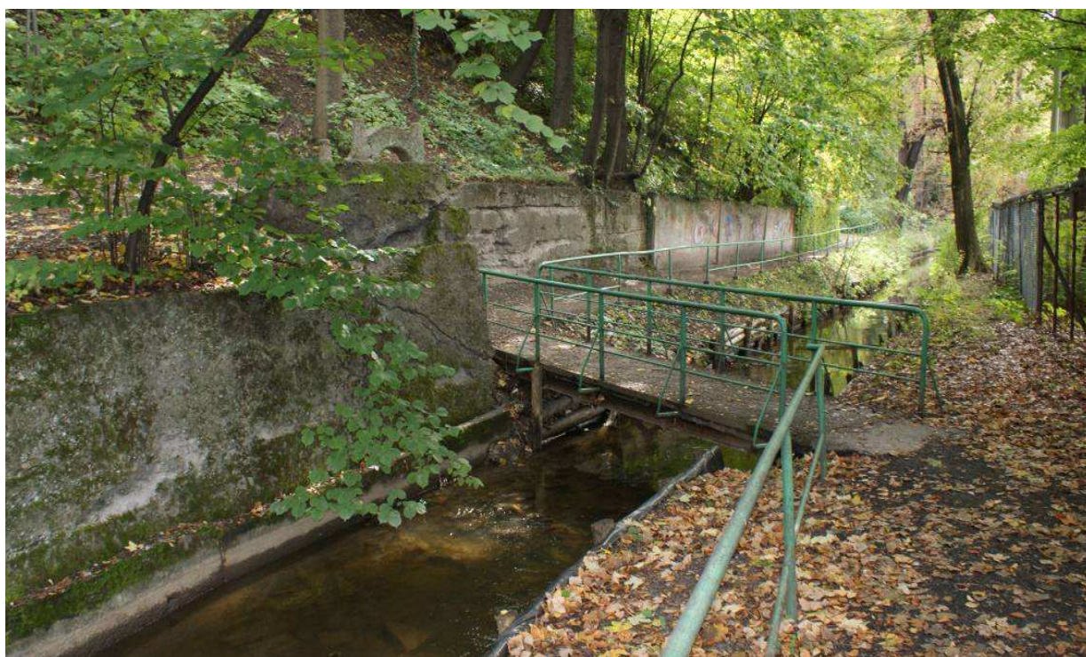
Widok ul. Przykopa na odcinku od ul. Schodowej do ul. 3-Maja
