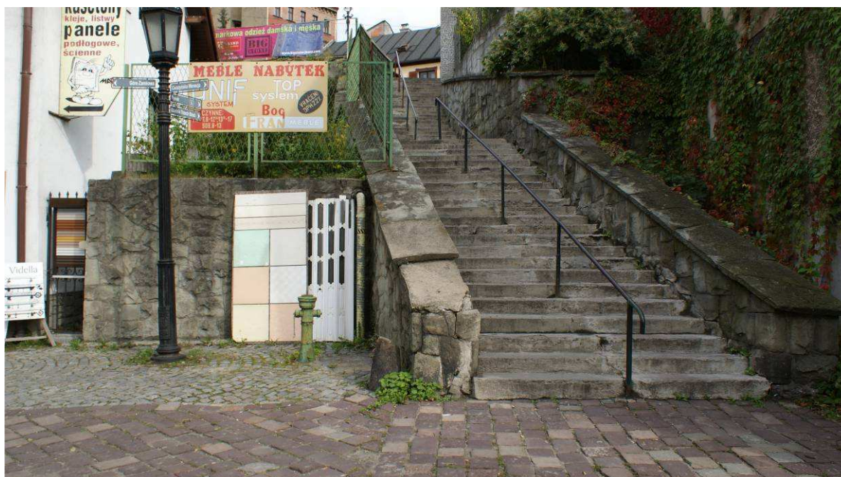
Widok schodów łączących ul. Przykopa z ul. Śrutarską – stan istniejący
