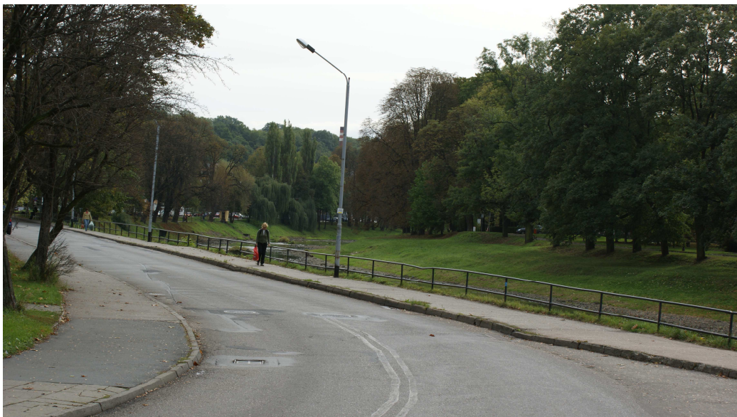
Fot. Stan istniejący zabezpieczenia chodnika wzdłuż rzeki Olzy
