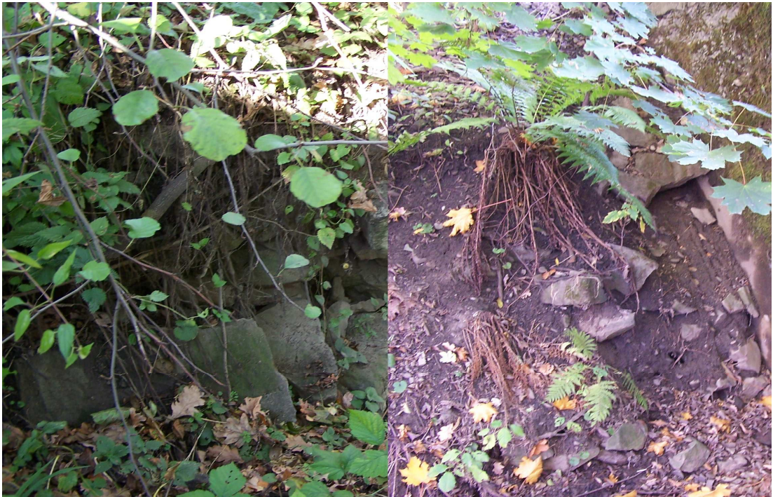
Fot. 4. Aktualny stan ubezpieczenia na wylocie do rzeki Bobrówki.
