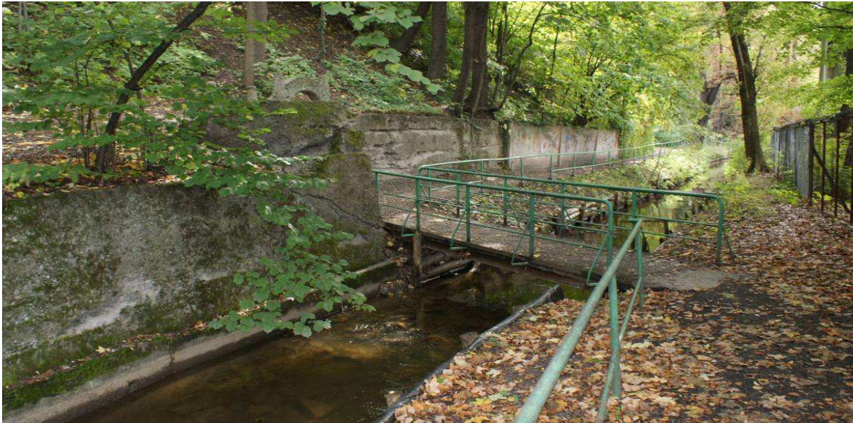
Widok ul. Przykopa na odcinku od ul. Schodowej do ul. 3-Maja
