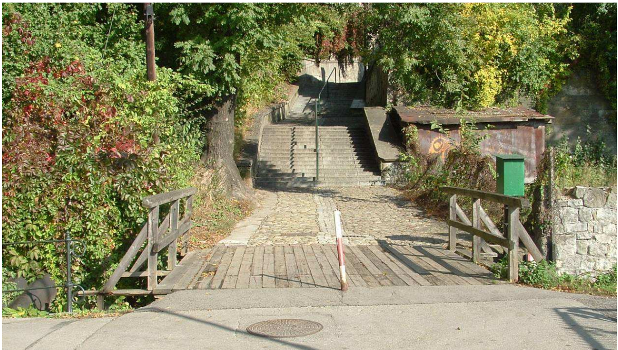
Fot. Widok kładki nad kanałem rzeki młynówki w rejonie ul. Schodowej
