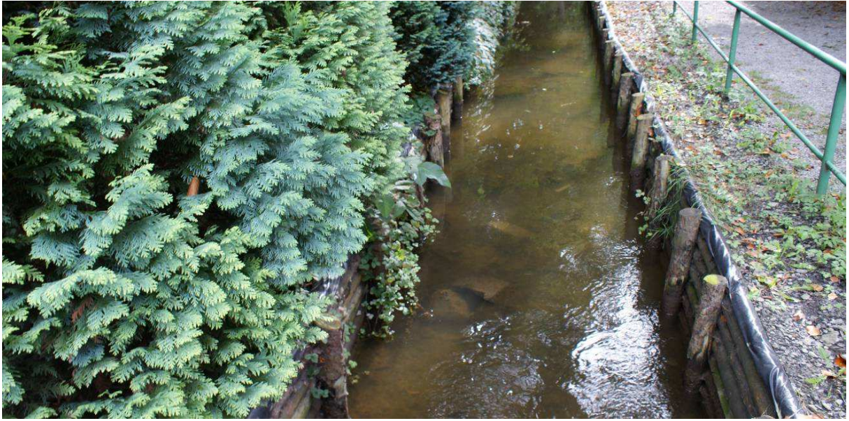
Fot. Istniejąca obudowa drewniana przewidziana do wymiany
