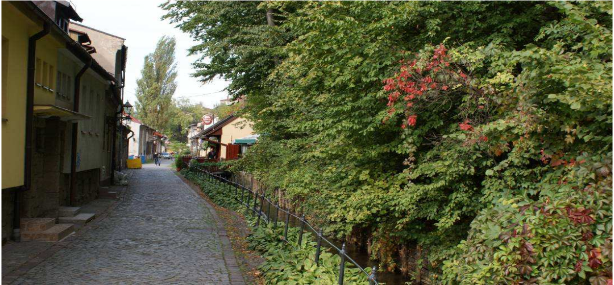
Widok ul. Przykopa na odcinku od ul. Młyńska Brama do ul. Schodowej – stan istniejący
