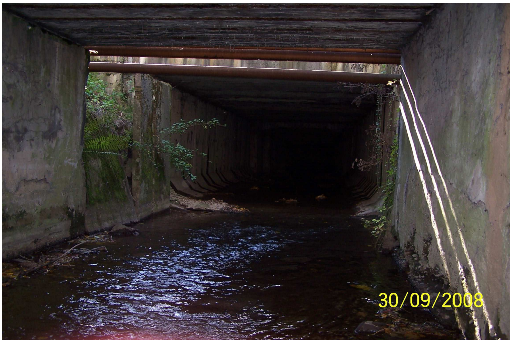
Fot. 3. Zakończenie odcinka zakrytego przebiegającego pod zakładem Energetyki
