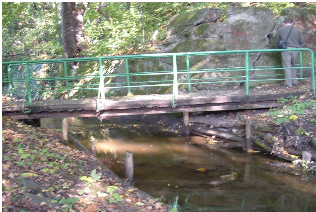
Fot. Widok kładki pieszej w rejonie ul. 3-Maja
