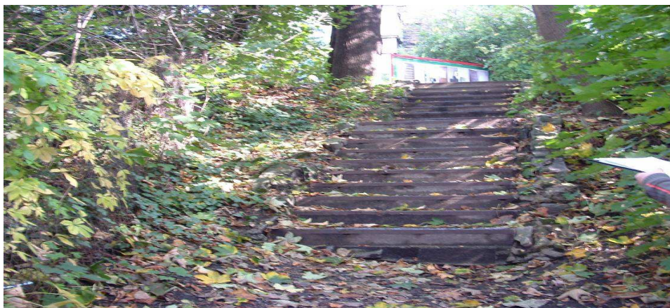
Fot. Widok schodów
