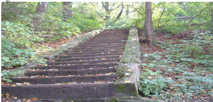
Fot. Widok schodów
