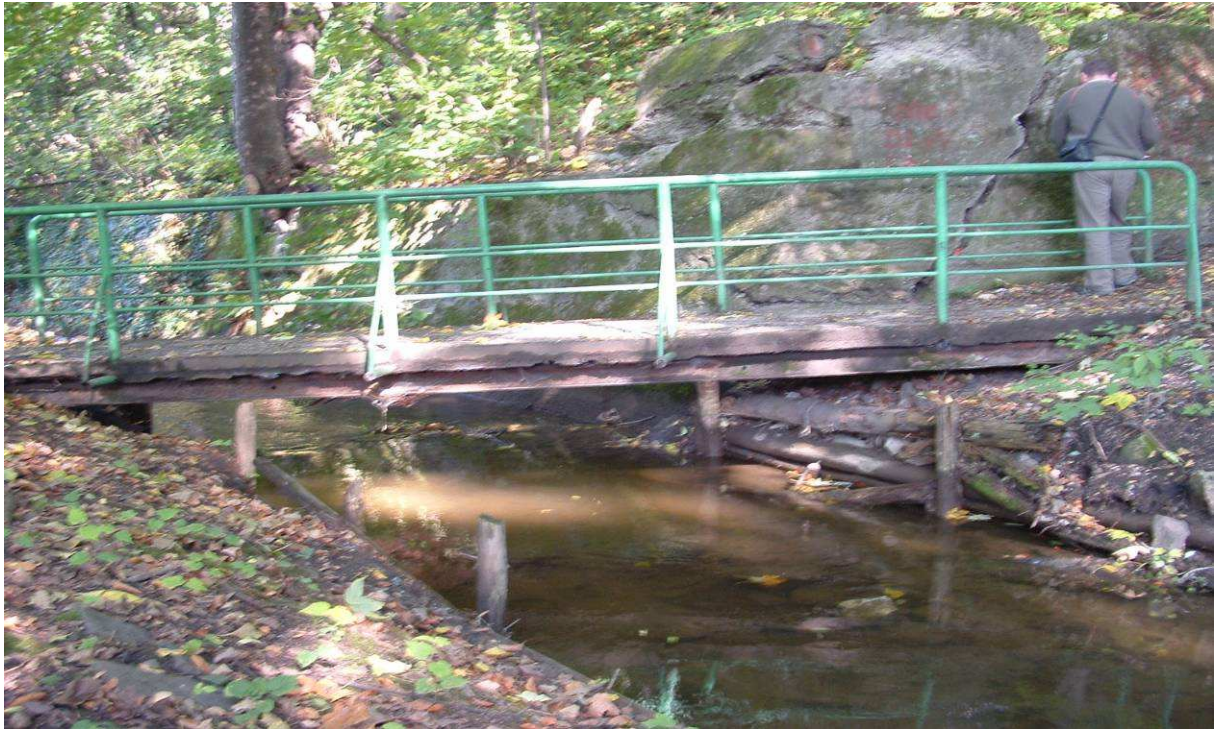
Fot. Widok kładki pieszej w rejonie ul. 3-Maja
