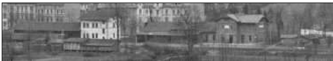
Fot.3. Stacja Cieszyn po rozbudowie (źródło: [1])
