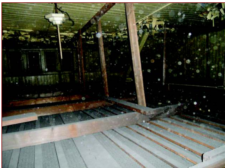
Fot. 63. Dodatkowe podparcie wieżby nad sufitem podwieszonym w części 2.
