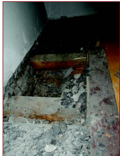
Fot. 9. Odkrywka stropu o rozpiętości 6,82 m nad parterem
