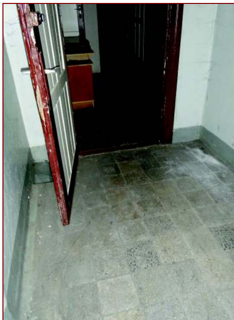
Fot. 21. Posadzka z płytek lastrykowych w korytarzu
