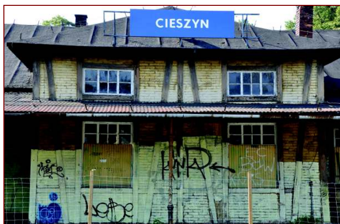
Fot. 14. Ryzalit w ścianie od strony peronów
