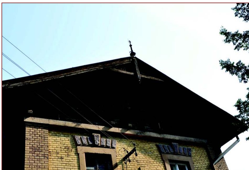
Fot.24. Fragment ściany szczytowej poddasza
