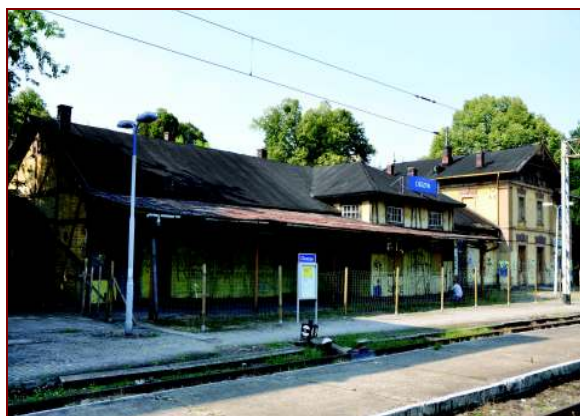
Fot. 12. Budynek parterowy – widok od strony peronów
