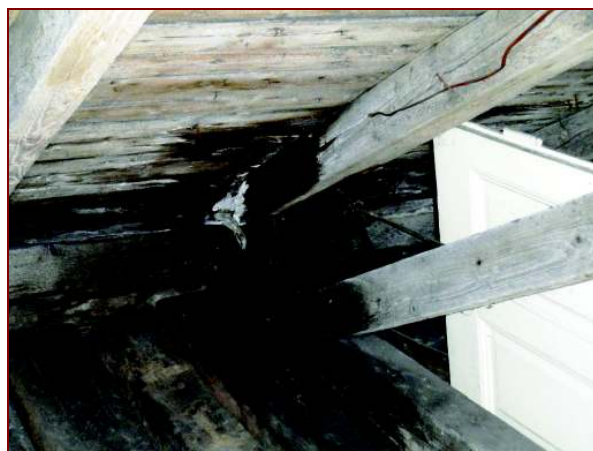
Fot. 50. Zagrybione elementy wężara dwuwieszakowego
