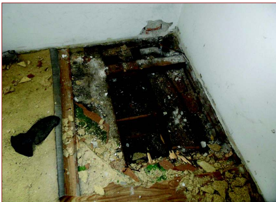
Fot. 7. Odkrywka stropu o rozpiętości. 5,5 m nad parterem
