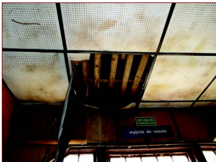
Fot.28. Odkrywka sufitu podwieszonego w hallu głównym
