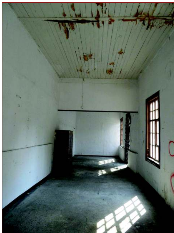
Fot.33. Budynek parterowy – część 3 – wnętrza pomieszczeń nr 3.6 i 3.5
