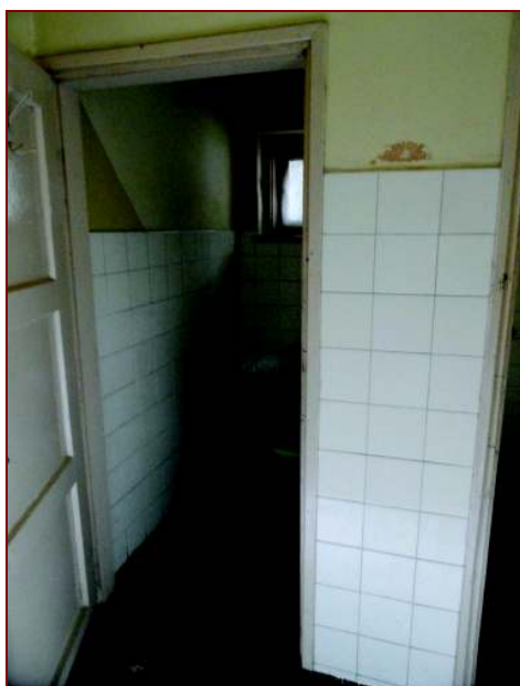
Fot.36. Wnętrze toalety męskiej
