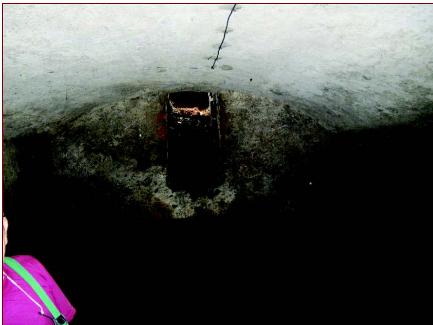
Fot. 39. Piwnica w budynku piętrowym
