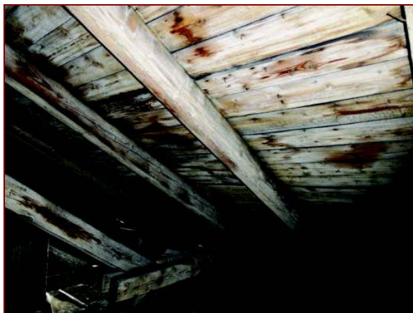
Fot. 48. Zamknięte elementy więźby krokiew i deskowanie
