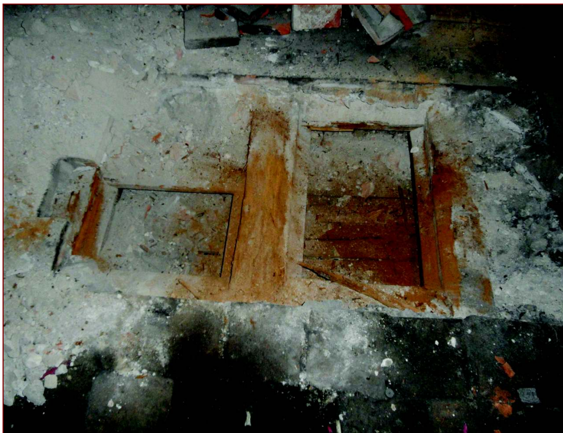
Fot. 11. Odkrywanie stropu o rozpiętości 6,82 m nad piętrzem
