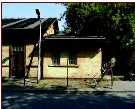
Fot. 18. Budynek wc – widok od ul. Hajduka
