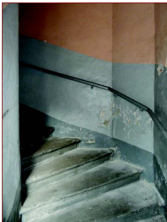
Fot. 22. Schody w budynku piętrowym
