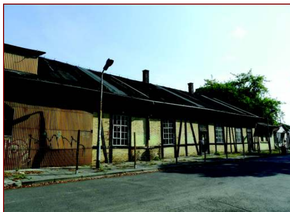
Fot. 13. Budynek parterowy – widok od ul. Hajduka
