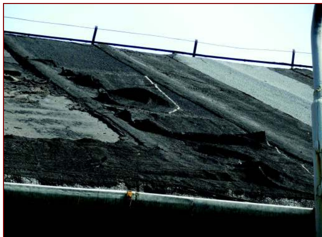
Fot. 79. Stan pokrycia dachowego w budynku parterowym
