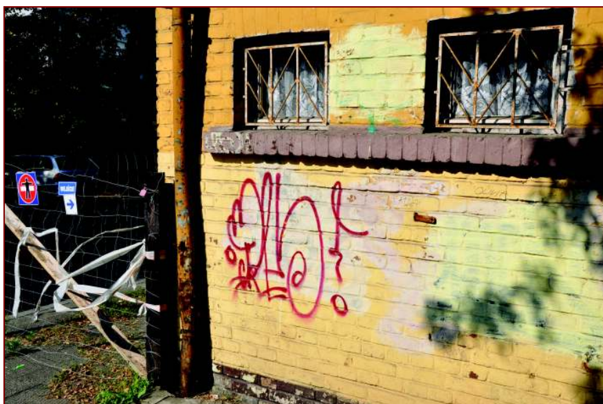
Fot. 83. Dziurawa rura spustowa w budynku wc
