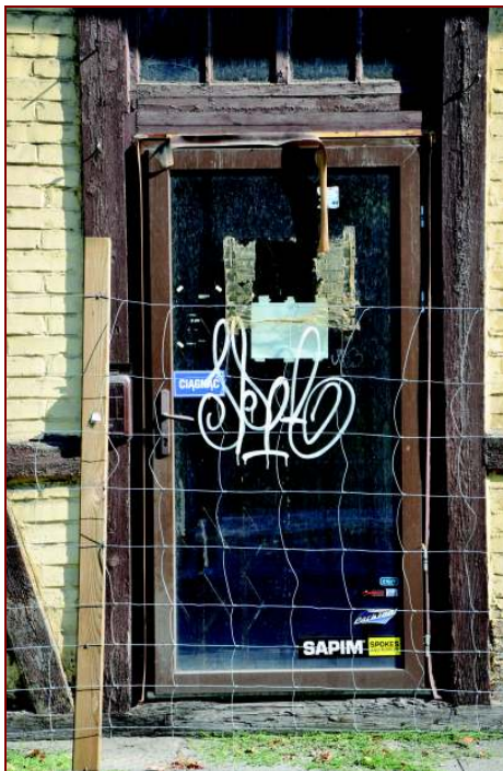
Fot.35. Drzwi wejściowe do pomieszczenia 3.5
