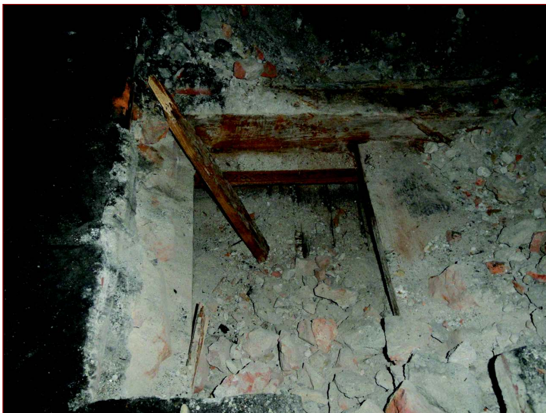
Fot. 10. Odkrywka stropu o rozpiętości. 5,5 m nad piętnem
