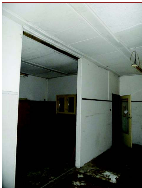
Fot.34. Budynek parterowy – część 3 – wnętrza pomieszczeń nr 3.7 i 3.8
