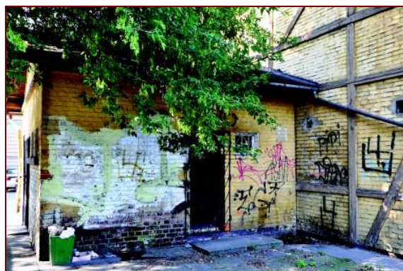
Fot. 19. Budynek wc – widok od strony peronów
