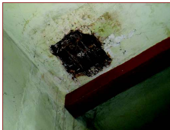
Fot. 32b. Odkrywka sufitu w pomieszczeniu nr 3.10.
