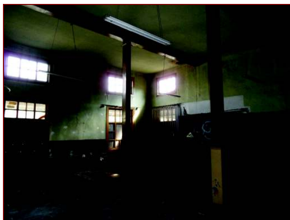
Fot.32a. Budynek parterowy – część 3 wnętrze pomieszczenia nr 3.10
