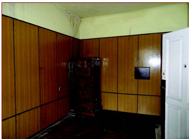
Fot. 20. Boazeria z płyt laminowanych w pomieszczeniu nr 1.10
