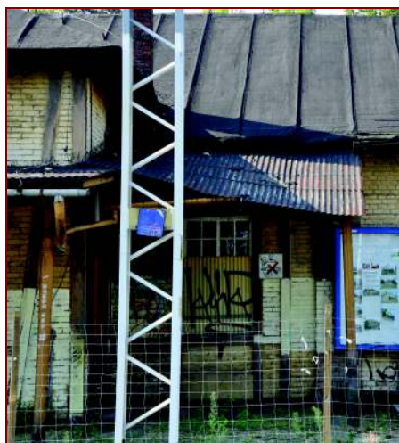
Fot. 66a. Daszek o konstrukcji drewnianej
