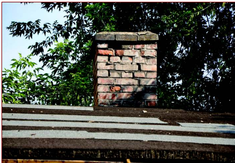
Fot. 64. Komin ponad dachem budynku parterowego
