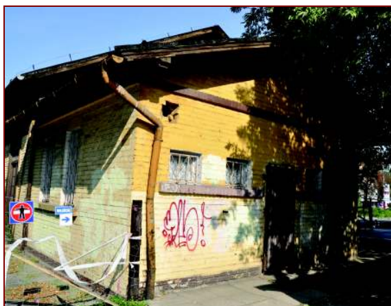
Fot. 67. Ściana szczytowa i boczna budynku wc
