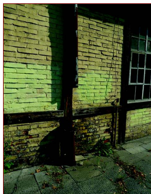
Fot. 80. Oberwana rura spustowa
