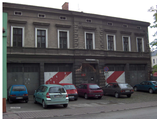
Zdj. nr 8 – Widok na elewację frontową adaptowanego dla potrzeb Straży Miejskiej w Cieszynie (skrajny, lewy wjazd do garażu pełnić będzie funkcję wyjazdu z projektowanego parkingu).
