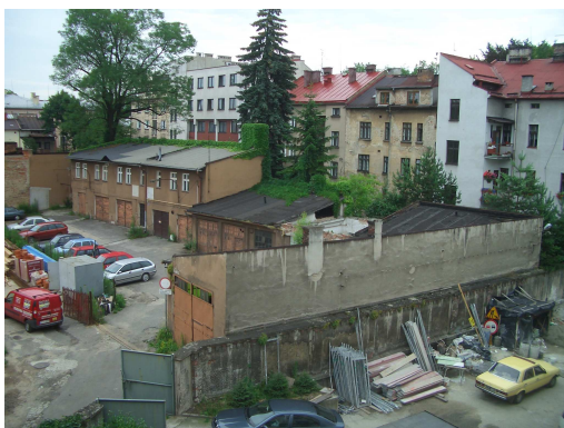
Zdj. nr 5 – Widok na tereny przeznaczone pod budowę parkingu (istniejącą zabudowę przeznaczono do wyburzenia).
