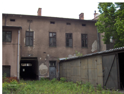
Zdj. nr 2 – Widok na tylną elewację PSP i na blaszaną Wiatę.
