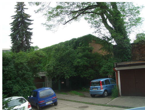
Zdj. nr 4 – Widok na porośniętą pnączami tylną elewację przeznaczonych do wyburzenia budynków gospodarczych.
