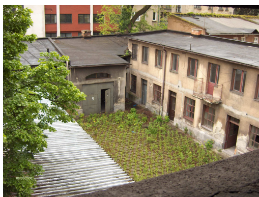
Zdj. nr 1 – Widok na wewnętrzny plac gospodarczy. i przeznaczony do częściowego wyburzenia budynek.
