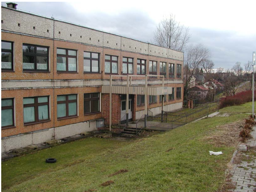
Widok elewacji frontowej –stan istniejący
