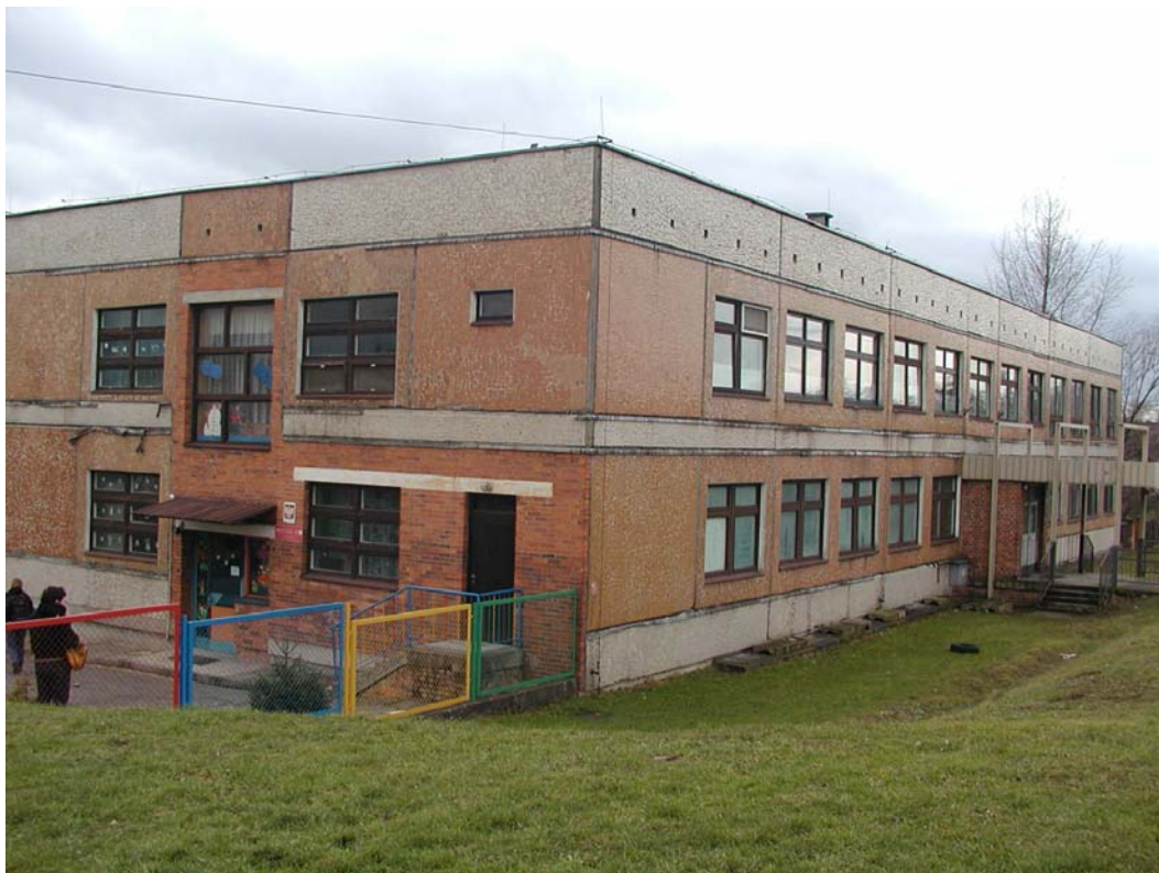
Widok elewacji frontowej –stan istniejący
