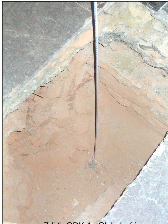
Zdj.5. ODK-1 –Głębokość Sklepienia nad Piwnicą pom. P.3 P.3
