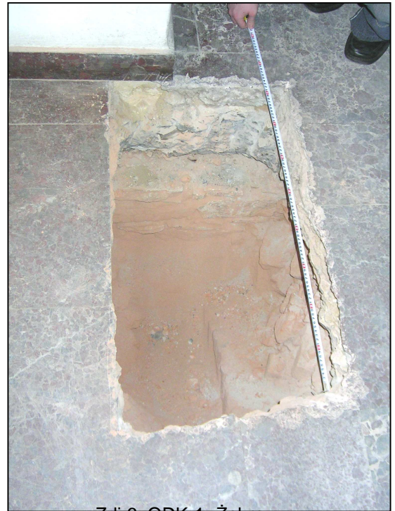
Zdj.6. ODK-1 –Żebro Sklepienia nad Piwnicą pom.
