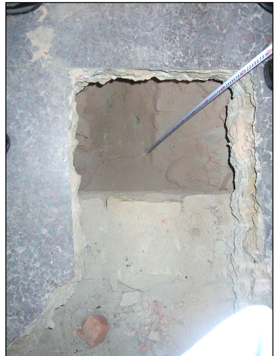
Zdj.4. ODK-2 Głębokość sklepienia nad Piwnicą pom. P.2
