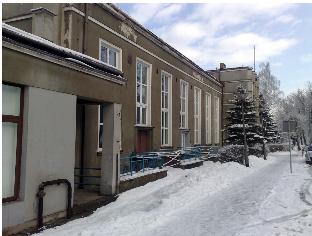
Zdj.: Fragment elewacji wejściowej.
