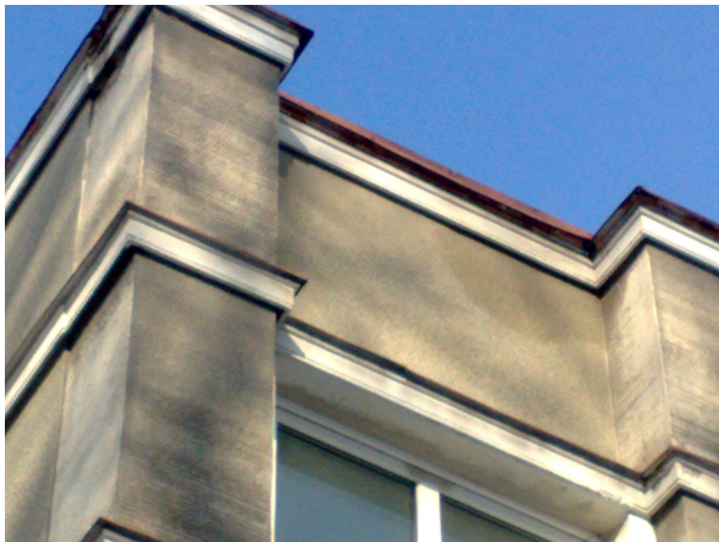
Zdj. Kolejny fragment elewacji budynku nad wejściem głównym – widoczne szczegóły opaskowych gzymsów pośrednich oraz wieńczącego – do bezwzględnego odtworzenia.
