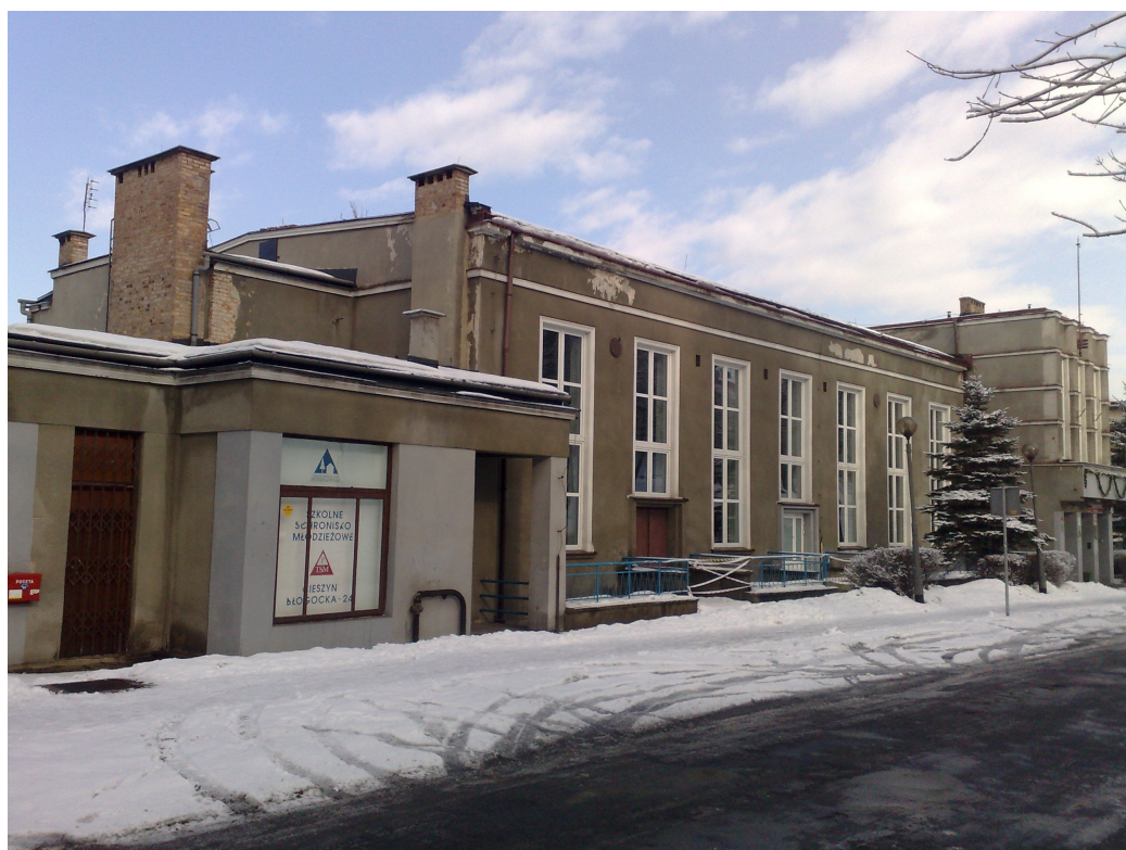
Zdj.: widok budynku od strony połudnowo-wschodniej. Widoczna bryła wielofunkcyjnej sali widowiskowo-rozrywkowej.
