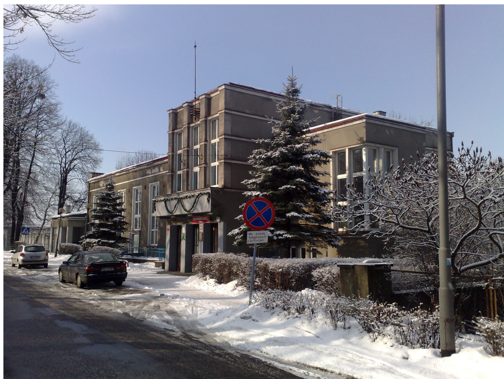
Zdj.: bryła budynku od strony wschodniej – widoczne człony bryły.
