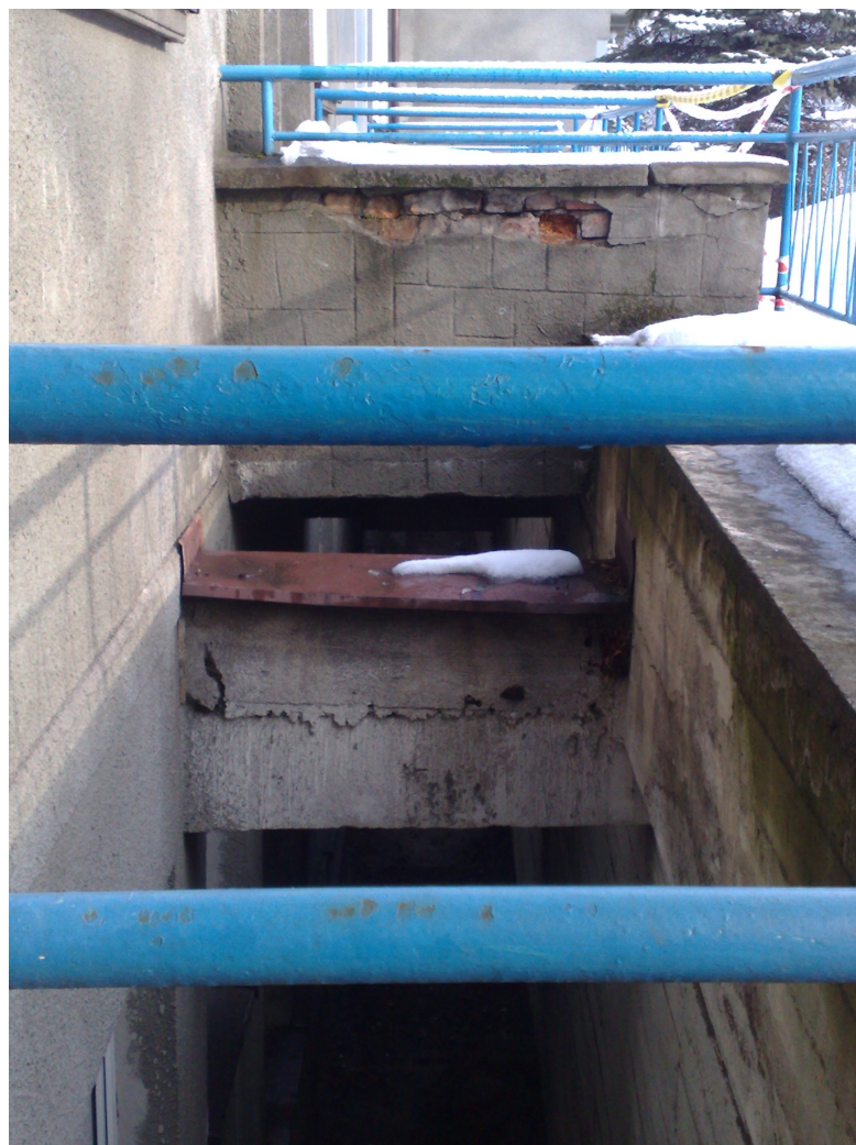
Zdj. Fragment fosi ochronnej, biegnącej wzdłuż budynku od strony ulicy.
