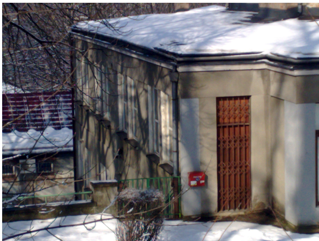
Zdj.: widok budynku od strony połudnowo-wschodniej. Na pierwszym planie -główna część noclegowa – pod ziemią – pomieszczenie kotłowni.
