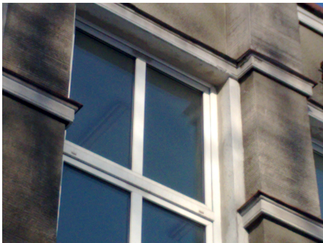
Zdj. Kolejny fragment elewacji budynku nad wejściem głównym – widoczne szczegóły
