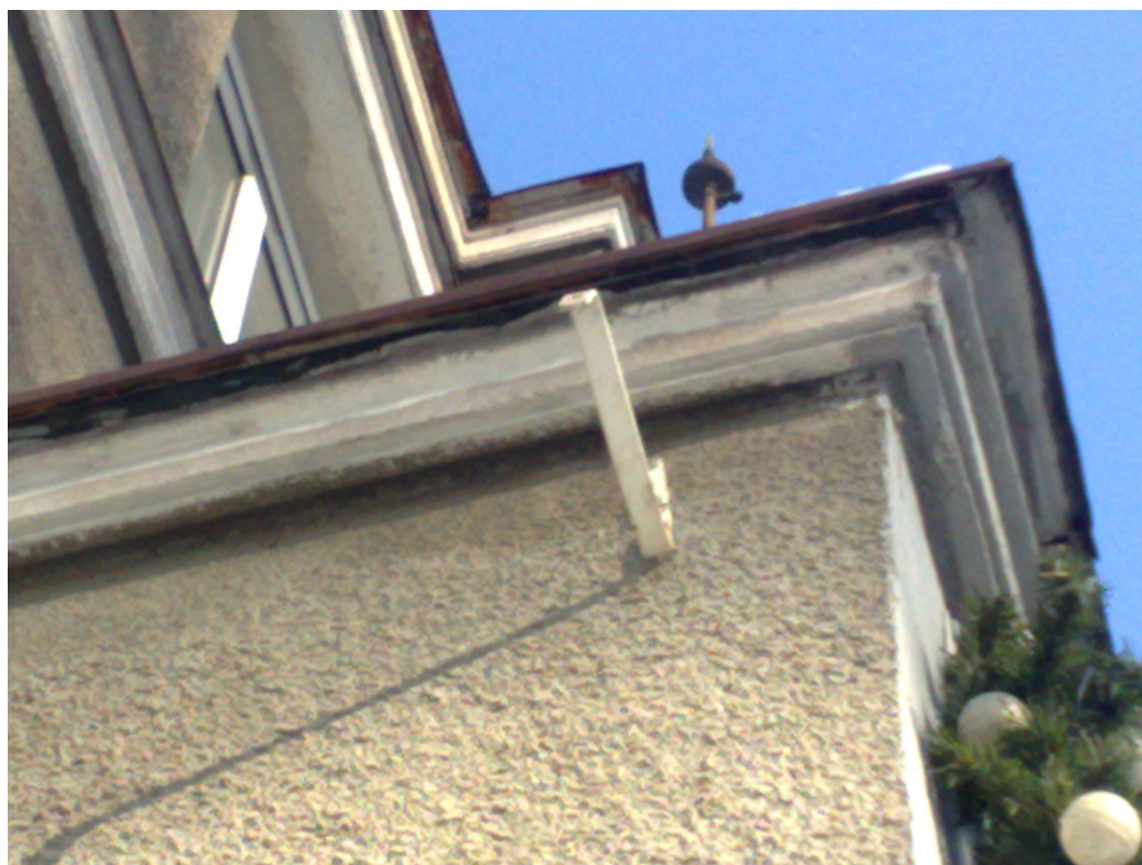
Zdj. Fragment elewacji budynku nad główną częścią noclegową – widoczne szczegóły opaskowych gzymsów wieńczących – do bezwzględnego odtworzenia.
