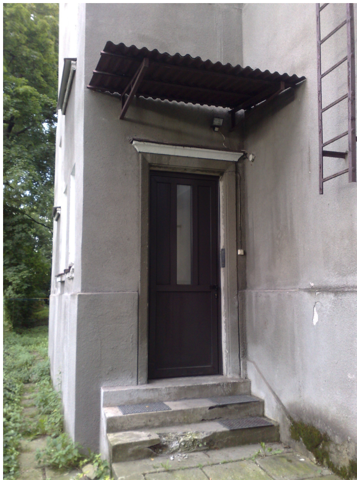
Zdj. Widok zadaszenia drzwi południo-zachodniego narożnika budynku.
