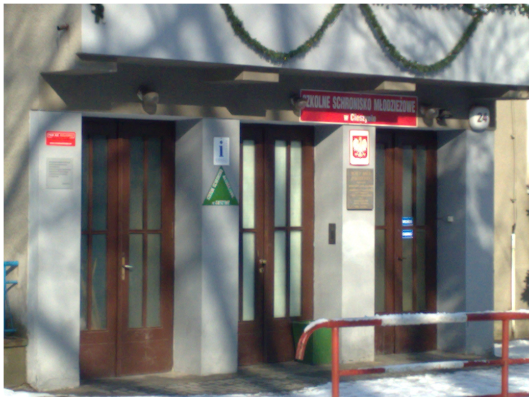
Zdj. Fragment elewacji budynku z wejściem głównym – widoczne główne drzwi wejściowe.
