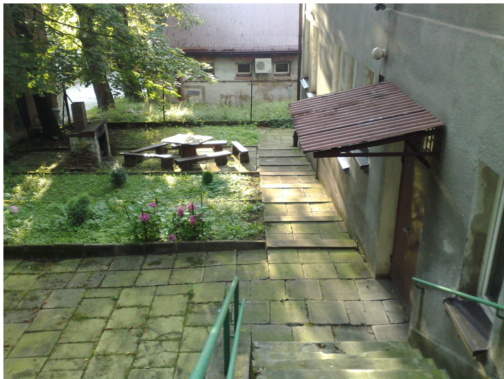
Zdj Fragment elewacji południowej budynku z wejściem do kotłowni – widoczne istniejące zadaszenie nad drzwiami – do wymiany.
