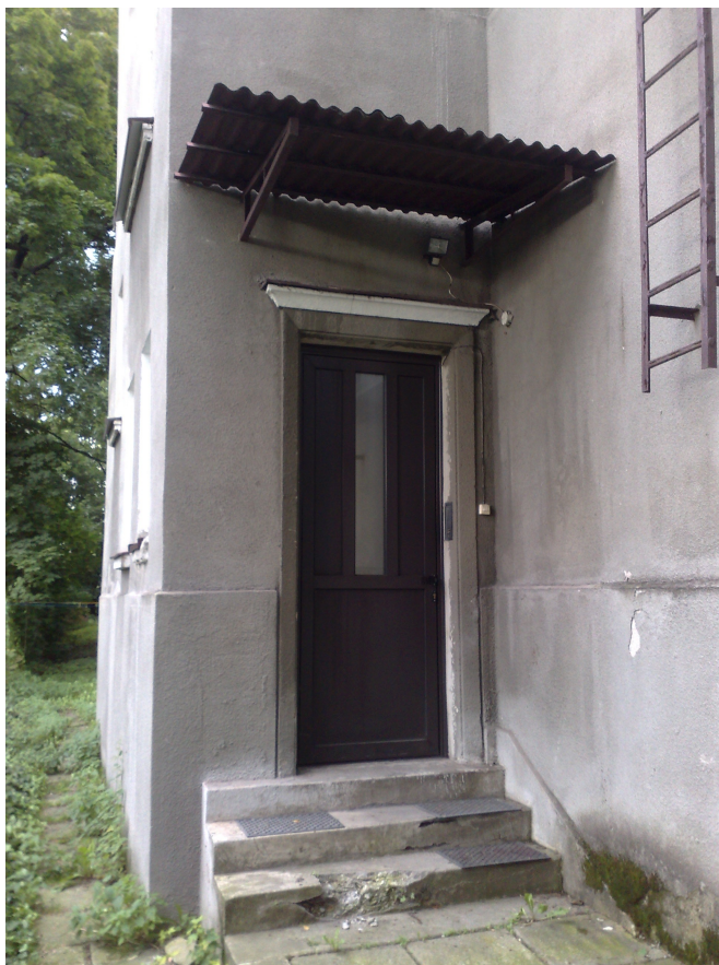
Zdj. Widok drzwi zewnętrznych południo-zachodniego narożnika budynku.
