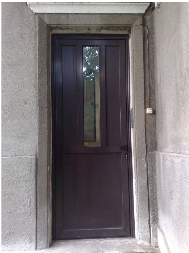
Zdj. Widok drzwi zewnętrznych południo-zachodniego narożnika budynku.
