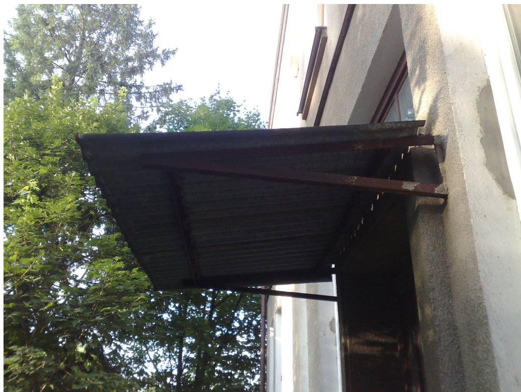
Zdj. Widok zadaszenia nad drzwiami zewnętrznymi zachodniej elewacji budynku.
