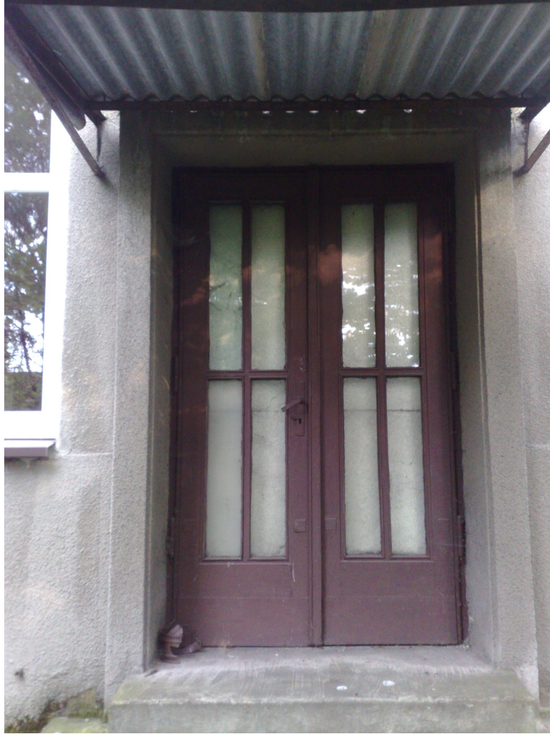
Zdj. Widok drzwi zewnętrznych zachodniej elewacji budynku.
