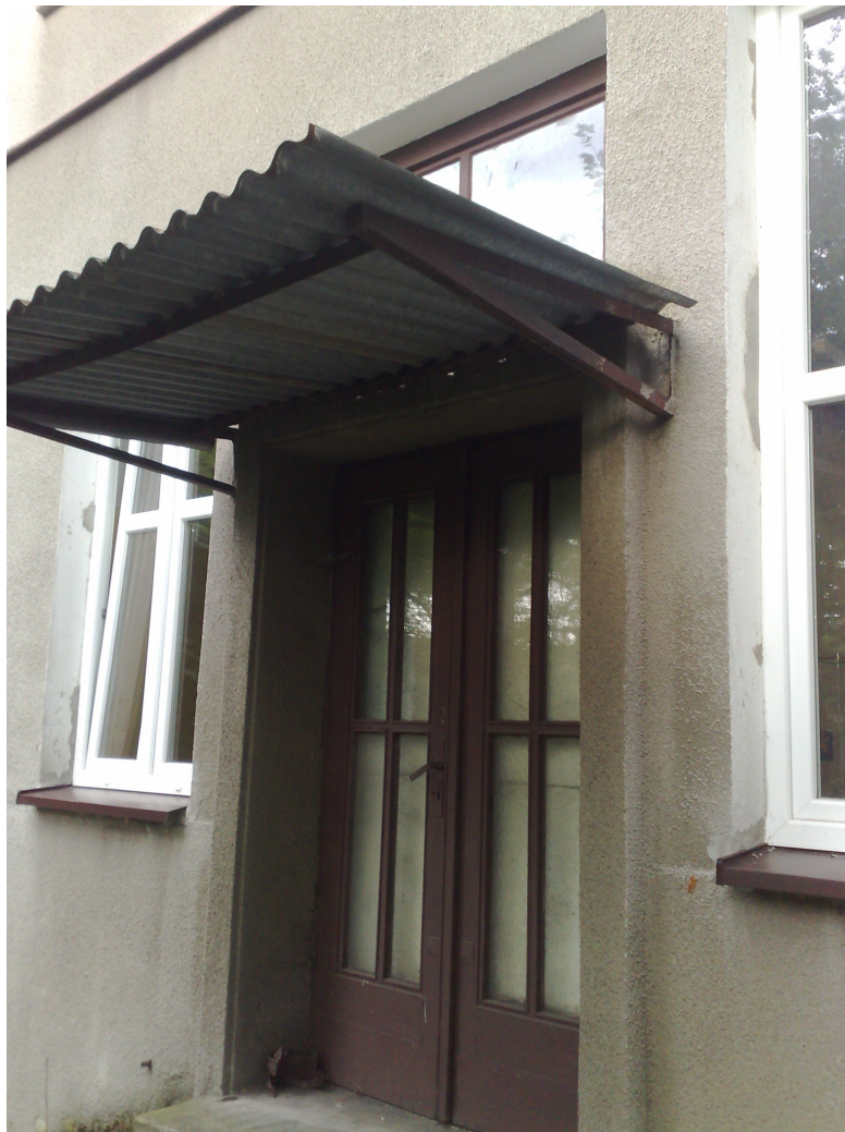
Zdj. Widok drzwi zewnętrznych zachodniej elewacji budynku.
