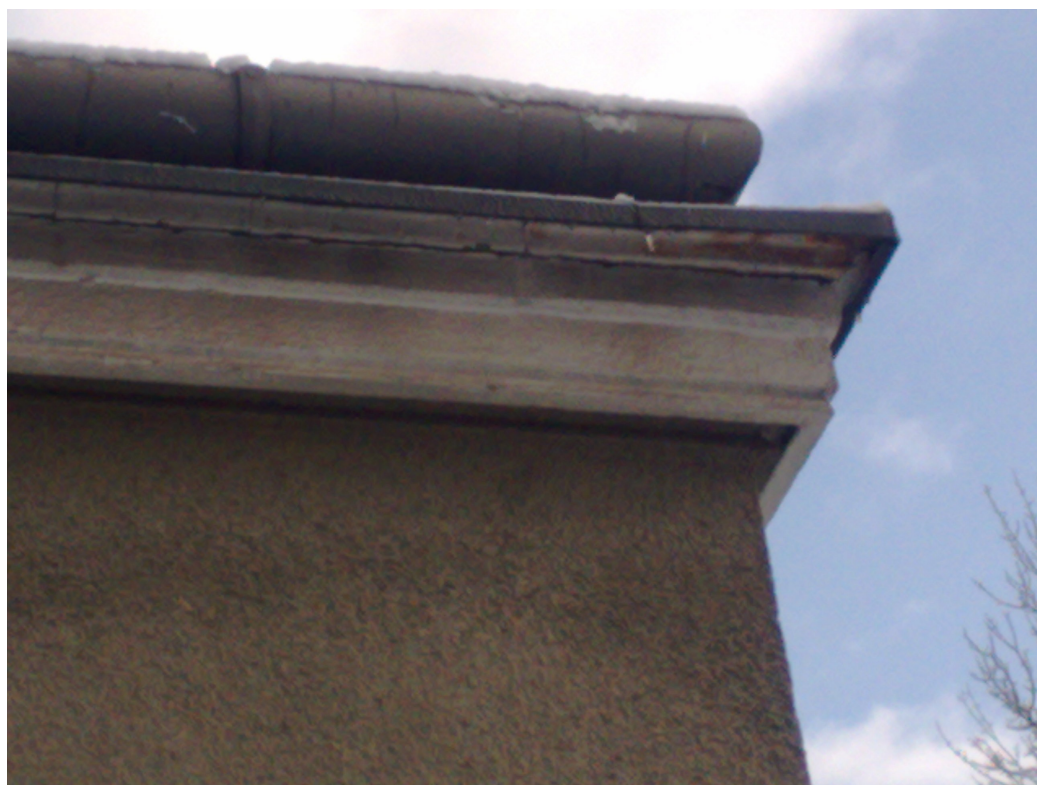
Zdj. Fragment elewacji budynku nad wejściem głównym – widoczne szczegóły gzymsów wieńczących wraz z orywnowaniem i okuciami.
