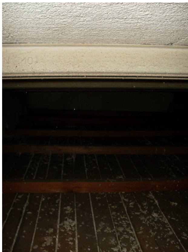
Zdj. Widok przestrzeni dachowej nad wielofunkcyjną salą widowiskowo-rekreacyjną – widoczna konstrukcja stalowa dachu oraz drewniana konstrukcja sufitu nad salą.
