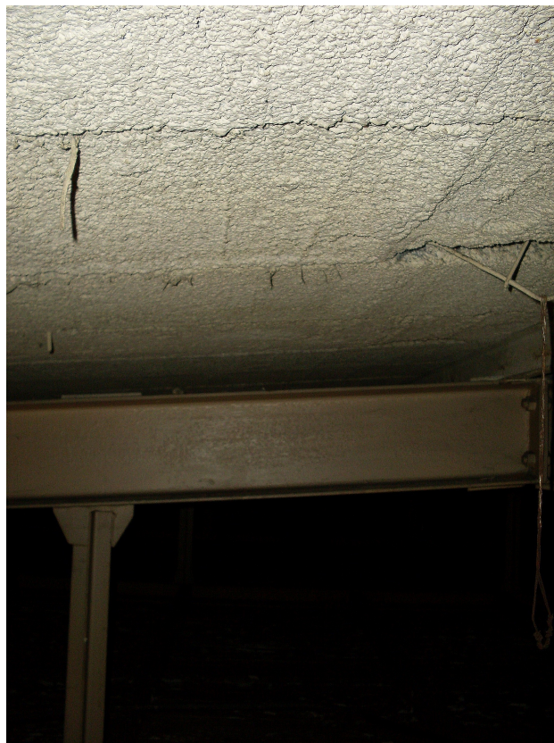
Zdj.: widok konstrukcji przestrzeni dachowej nad wielofunkcyjną salą wid.-rekreacyjną.
