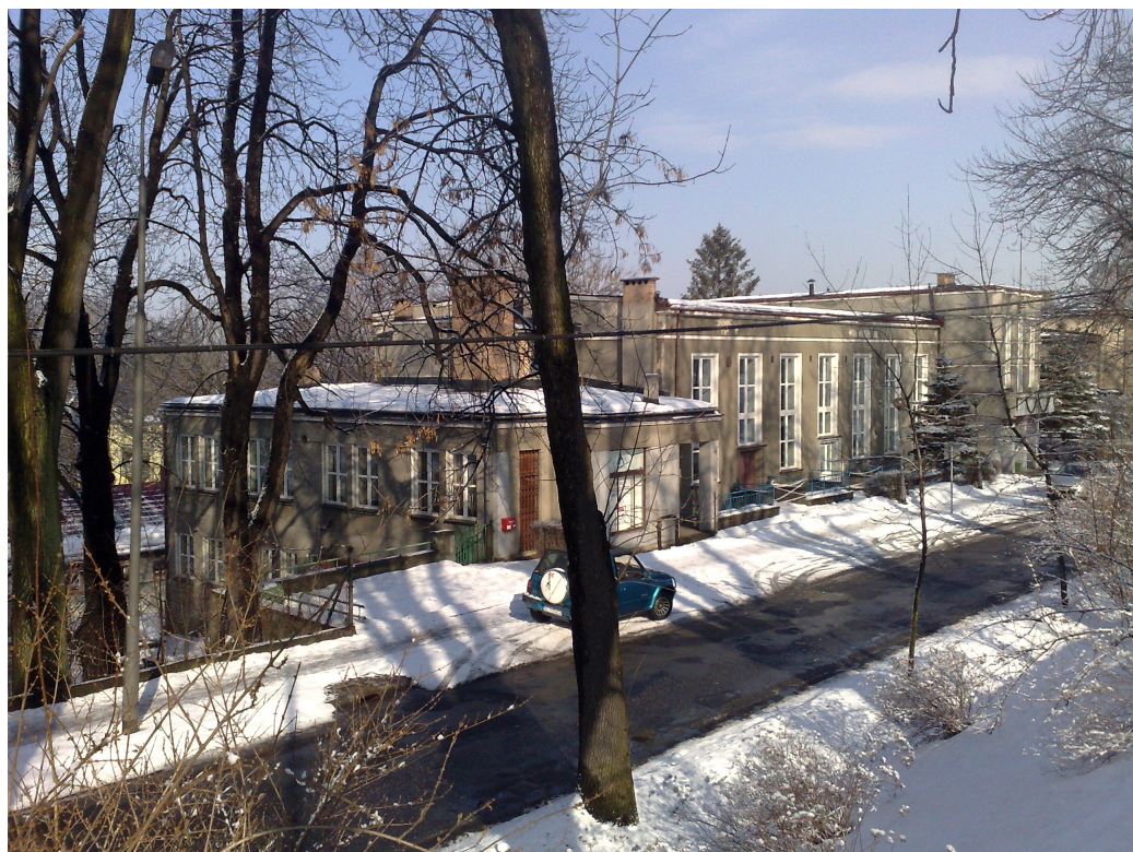
Zdj.: widok budynku od strony połudnowo-wschodniej. Na pierwszym planie -główna część noclegowa.
