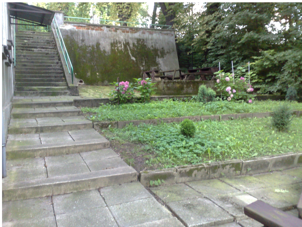
Fot.: Widok ściany oporowej od strony ogrodu.
