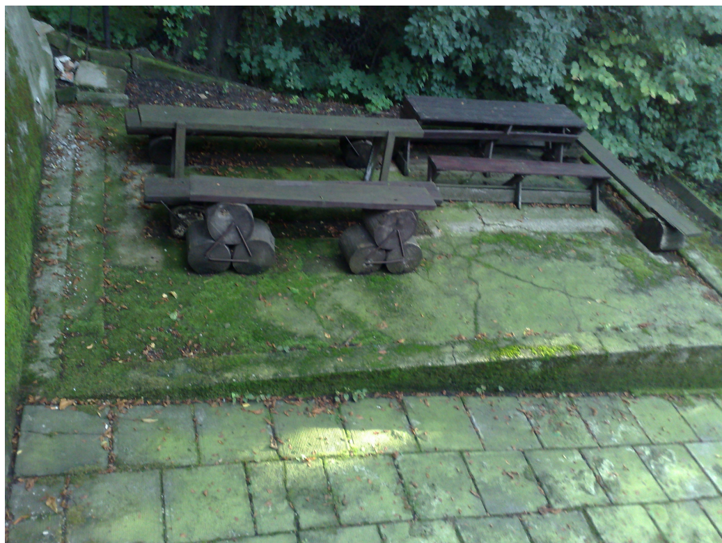
Fot. Fragment miejsca do siedzenia od strony południowej budynku – widoczna erozja nawierzchni.
