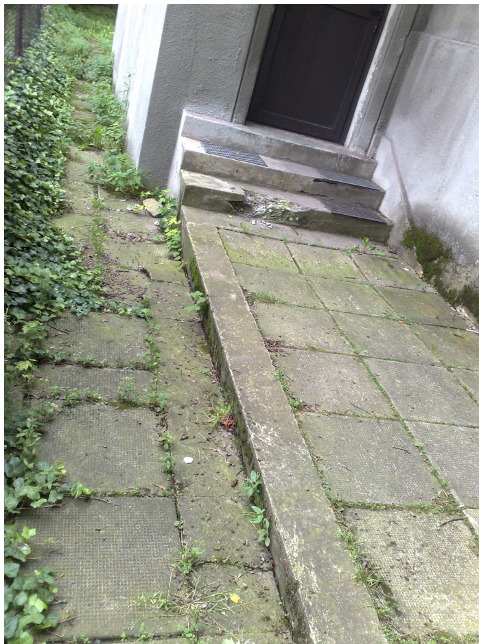
Fot. Fragment wejścia bocznego, od strony południowo-zachodniej budynku.
