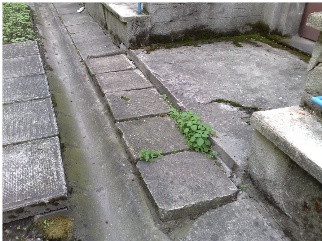
Fot. Fragment chodnika od strony frontowej budynku – widoczny element wyjścia ewakuacyjnego.
