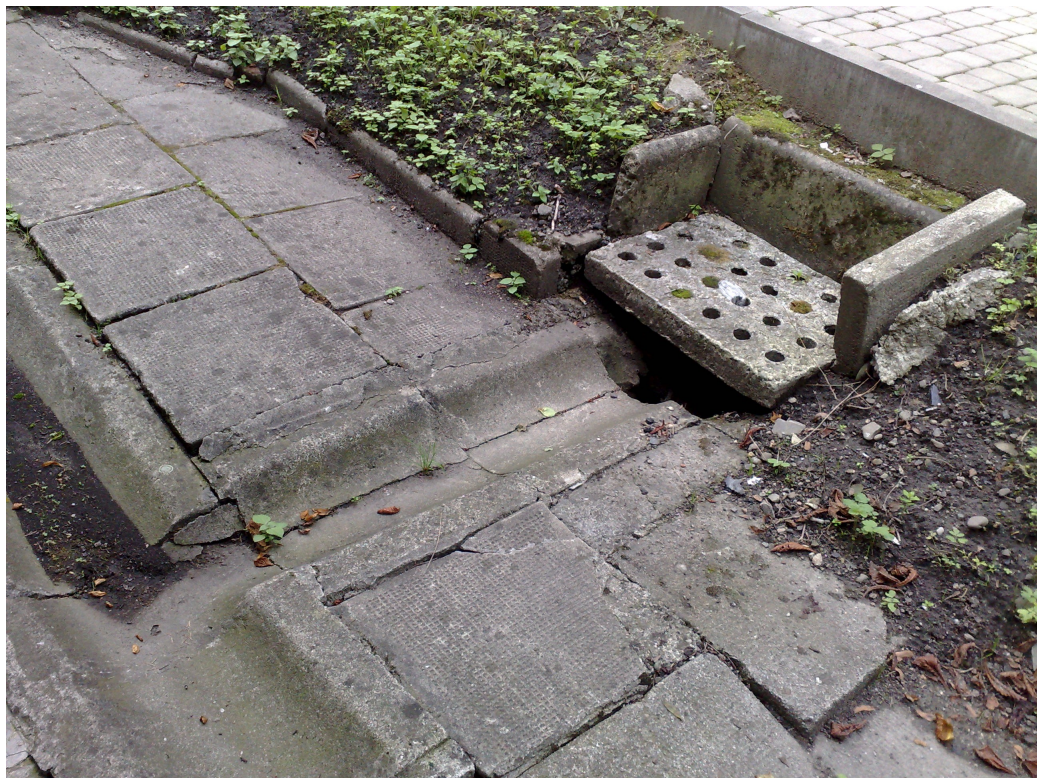
Fot. Fragment chodnika od strony frontowej budynku – widoczny ujście korytka odwadniającego
