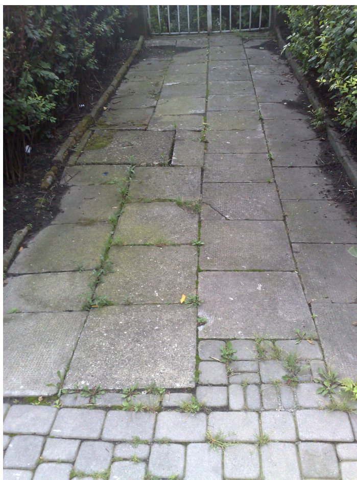
Fot. Fragment chodnika wejściowego do ogrodu od strony północnej budynku.
