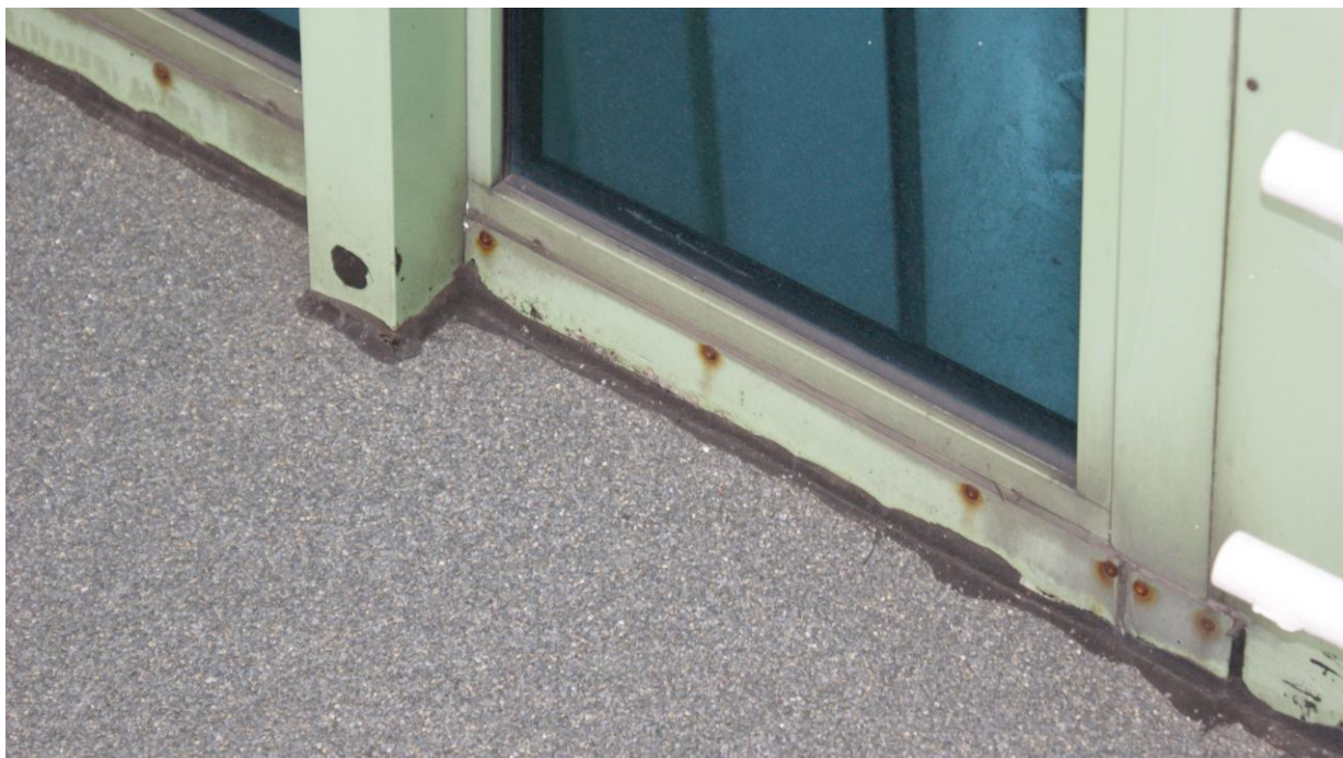
Zdjęcie nr 66 – zabezpieczone papą przejście dachowe do wentylatorowi
