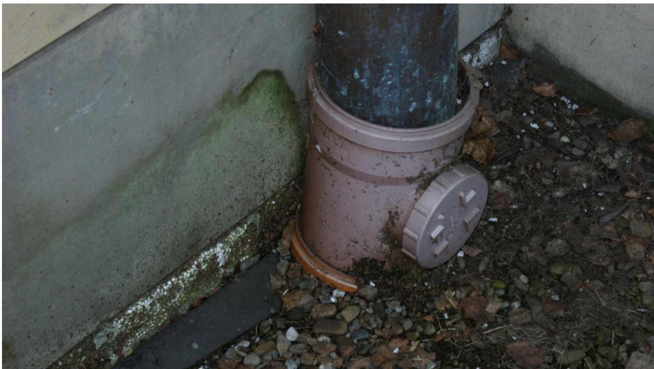
Zdjęcie nr 37 – Okładzina kamienna ułożona na płycie styropianowej/ styk elewacji z gruntem /
