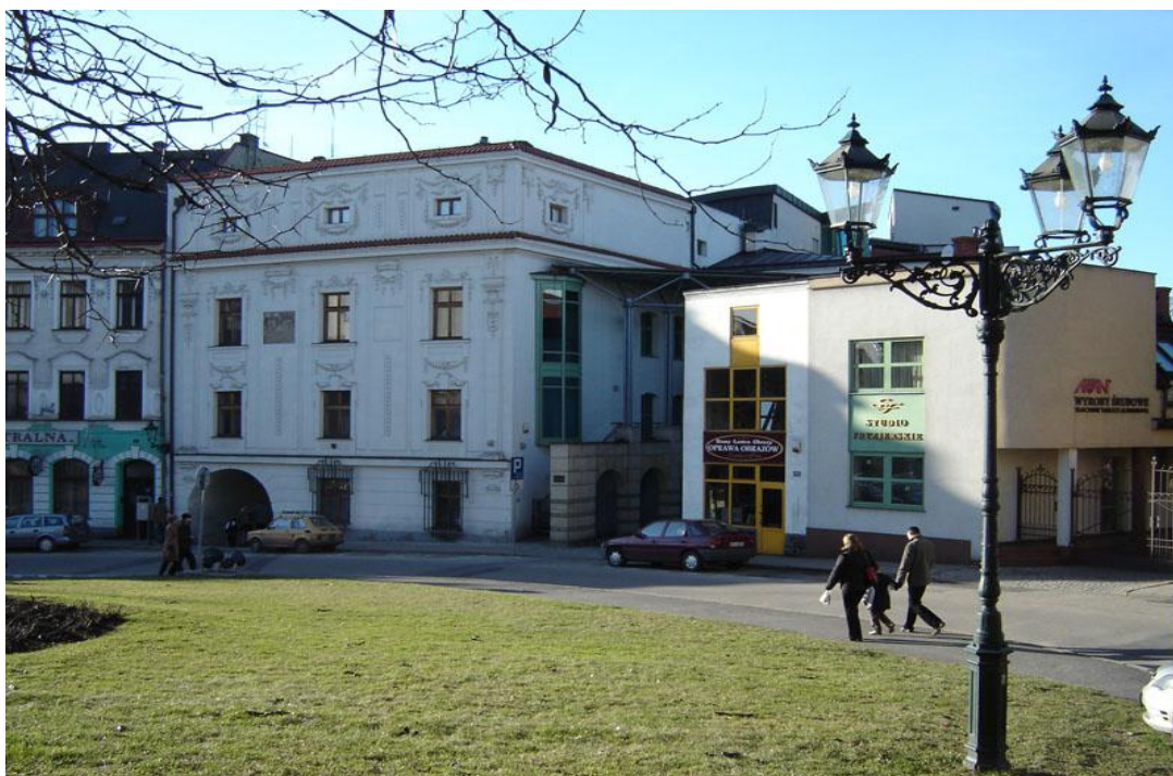
Widok elewacji frontowej / południowo - wschodniej / obiektu opiniowanego
