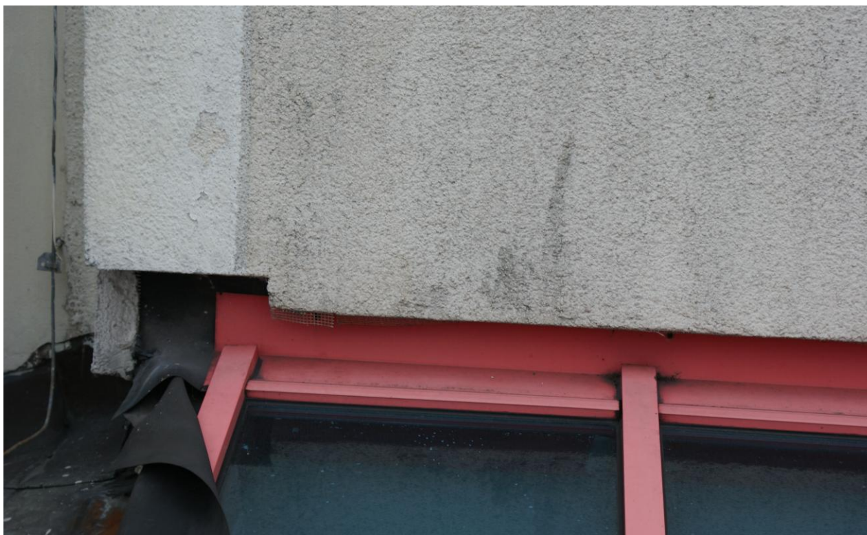
Zdjęcie nr 30 – przykład miejsca gdzie brak jest listwy startowej
