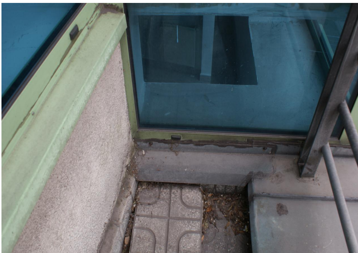
Zdjęcie nr 64- Przykład obróbek blacharskich tarasu , zamocowania barierki tarasowej
