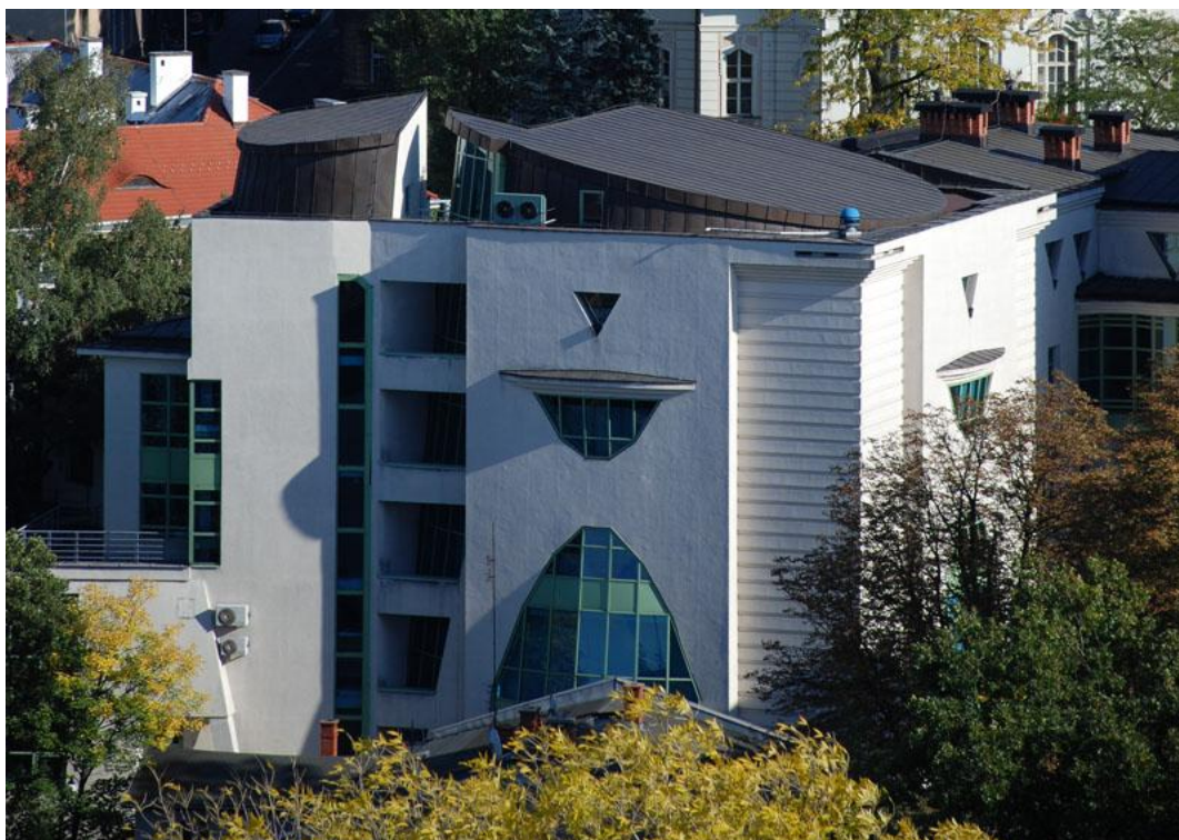
Widok elewacji północno zachodniej opiniowanego obiektu
