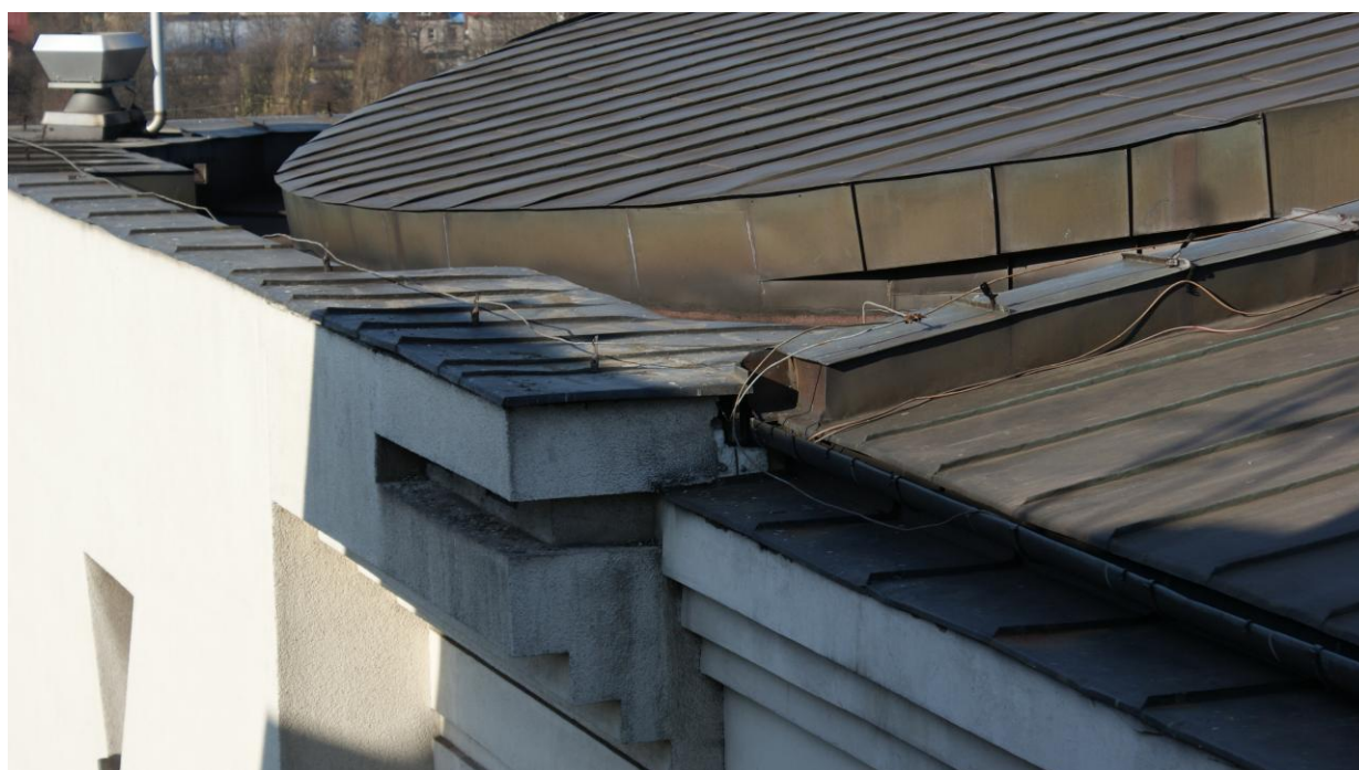
Zdjęcie nr 9 – uchwyty ocynkowane instalacji odgromowej
