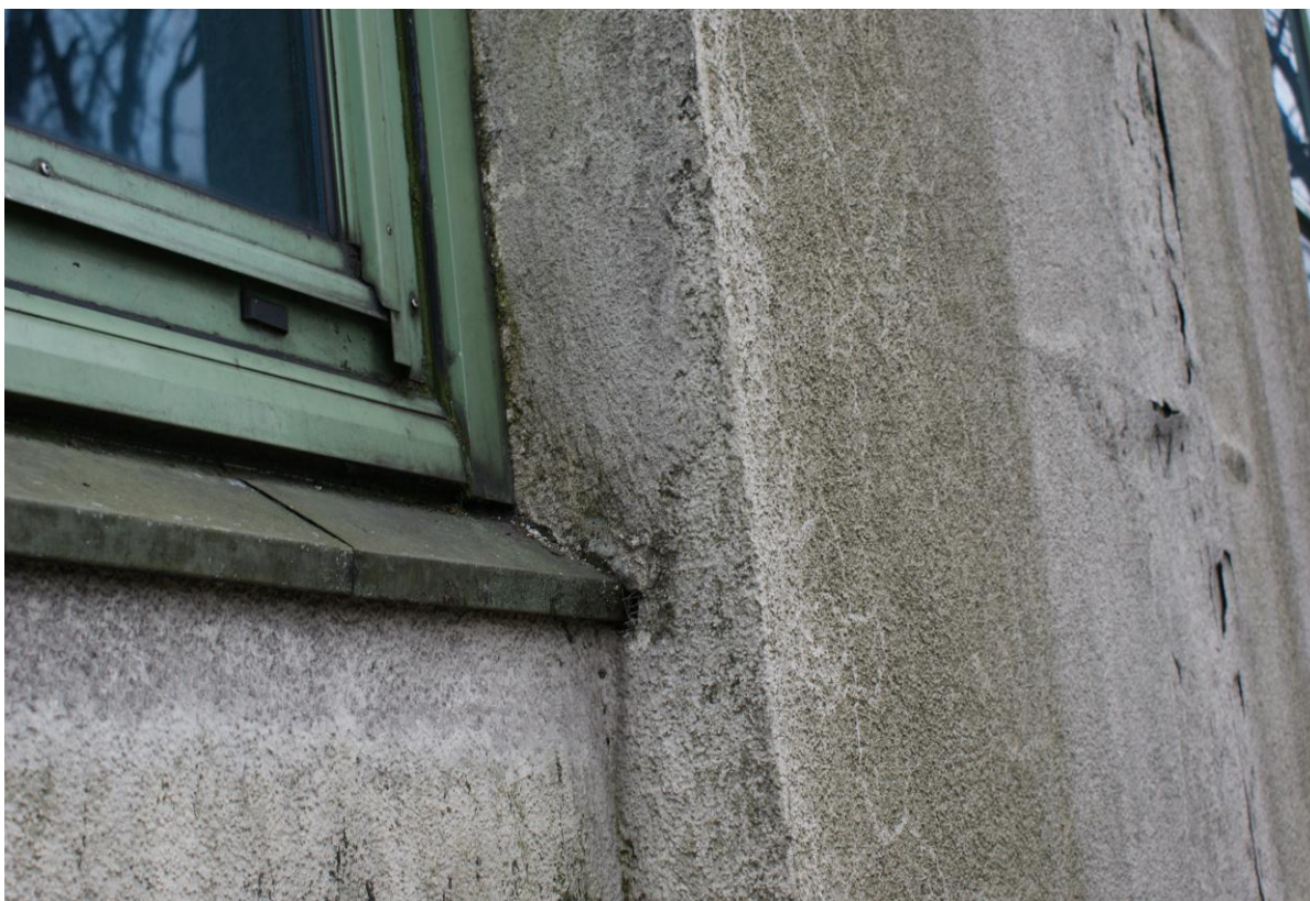
Zdjęcie nr 32 – przykład braku listwy wykańczającej na styku okno tynk
