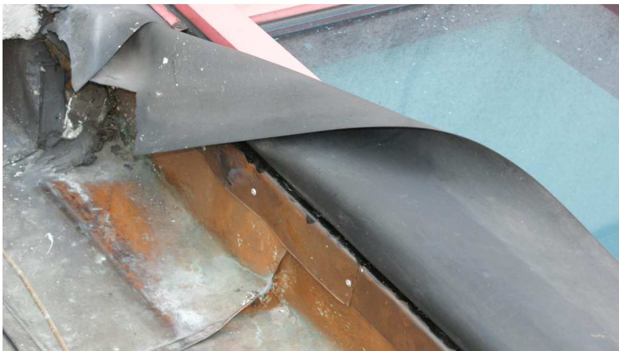
Zdjęcie nr 22 – ruchoma obróbka świetlika z gumy i blach miedzianych
