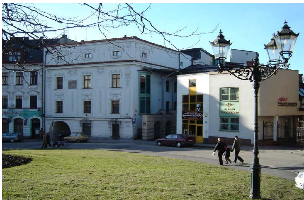
Widok elewacji frontowej / południowo - wschodniej / obiektu opiniowanego
