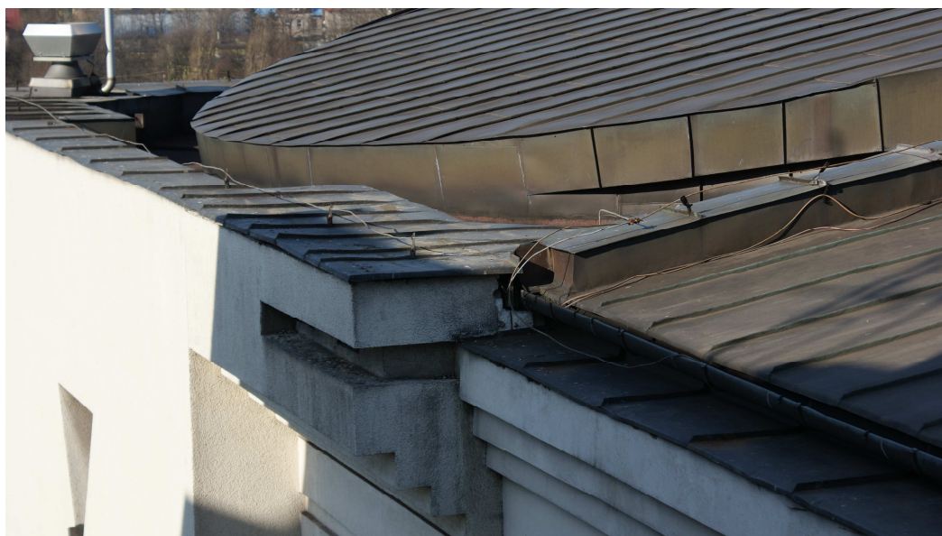
Zdjęcie nr 9 – uchwyty ocynkowane instalacji odgromowej
