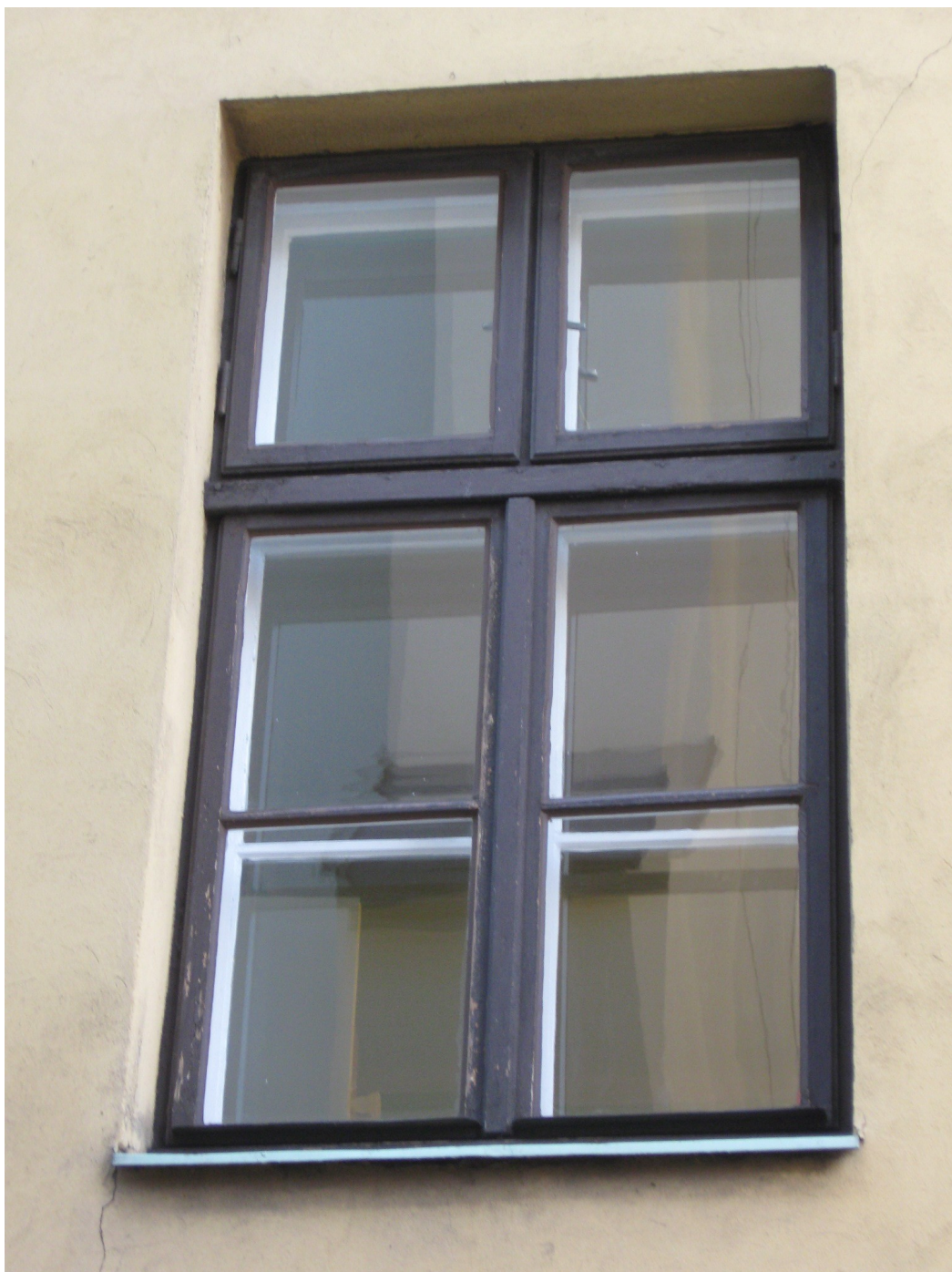
Fotografia nr 8. Elewacja podwórzowa i tylna budynku administracyjnego Rynek 1 podwórzowa – okno w osi
