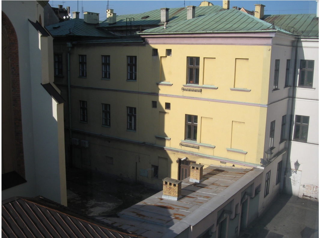
Fotografia nr 4. Elewacja podwórzowa budynku administracyjnego Rynek 1 (południowa: odcinek B – C) od strony kościoła parafialnego
