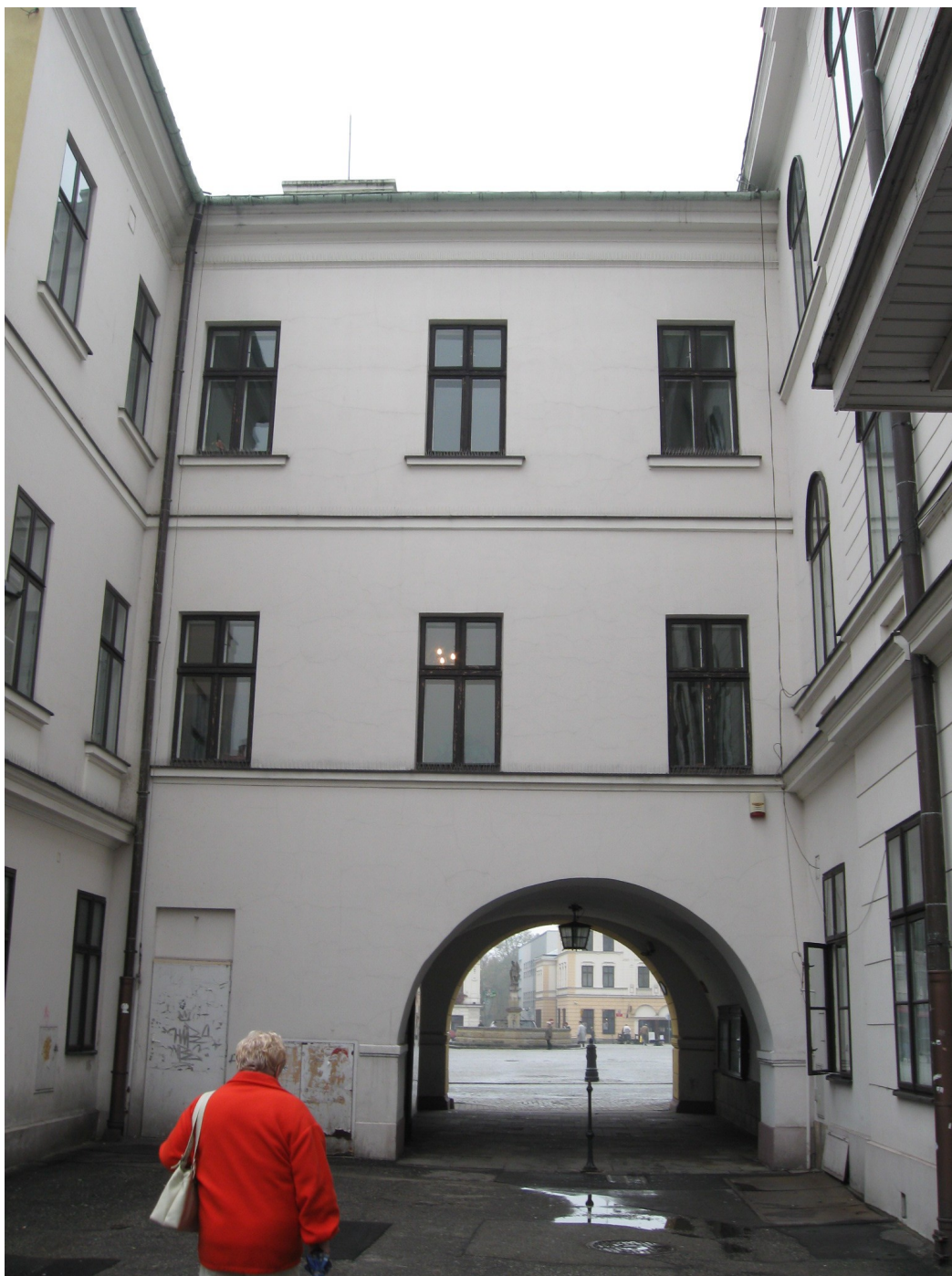
Fotografia nr 6. Elewacja tylna budynku administracyjnego Rynek 1 (południowa: odcinek D - E) od strony ul. Ratuszowej
