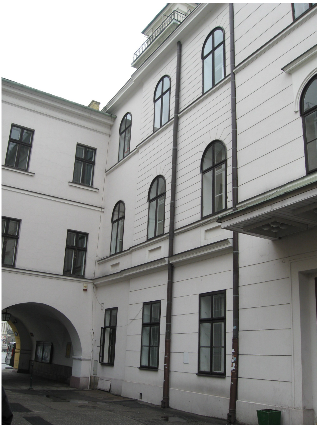
Fotografia nr 7. Elewacja tylna budynku administracyjnego Rynek 1 (zachodnia: odcinek E - F) od strony ul. Ratuszowej
