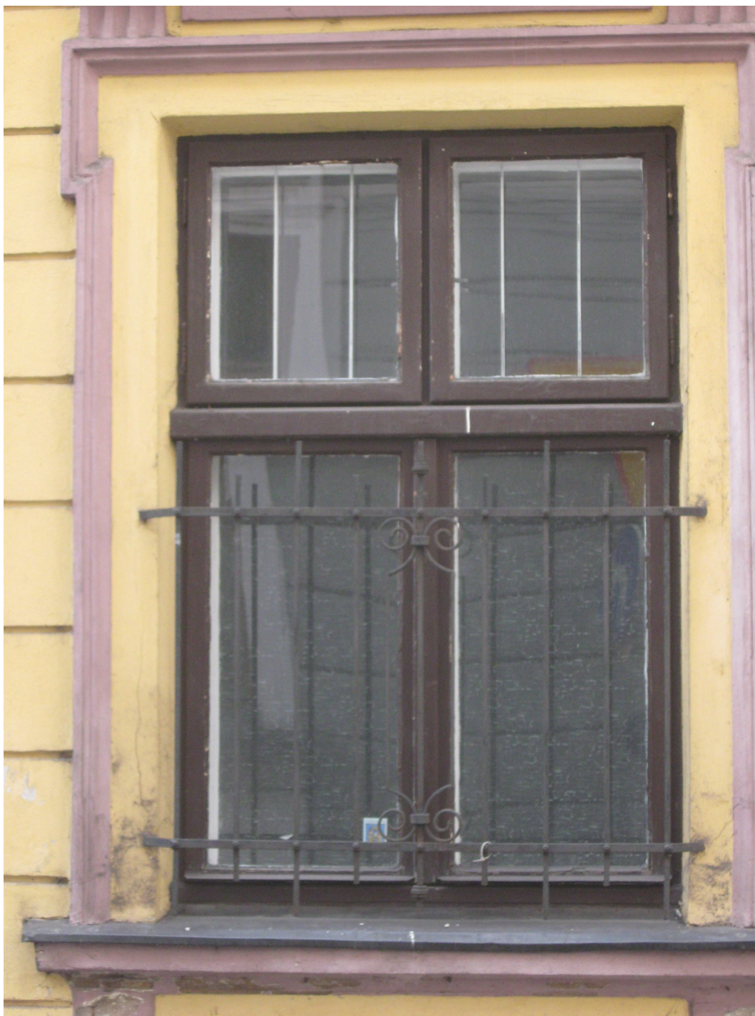
Fotografia nr 1. Istniejące okno w osi 1, 2, 3, 5, 7, 8 i 9 budynku administracyjnego Srebrna 2 w elewacji od strony ulicy Srebrnej
