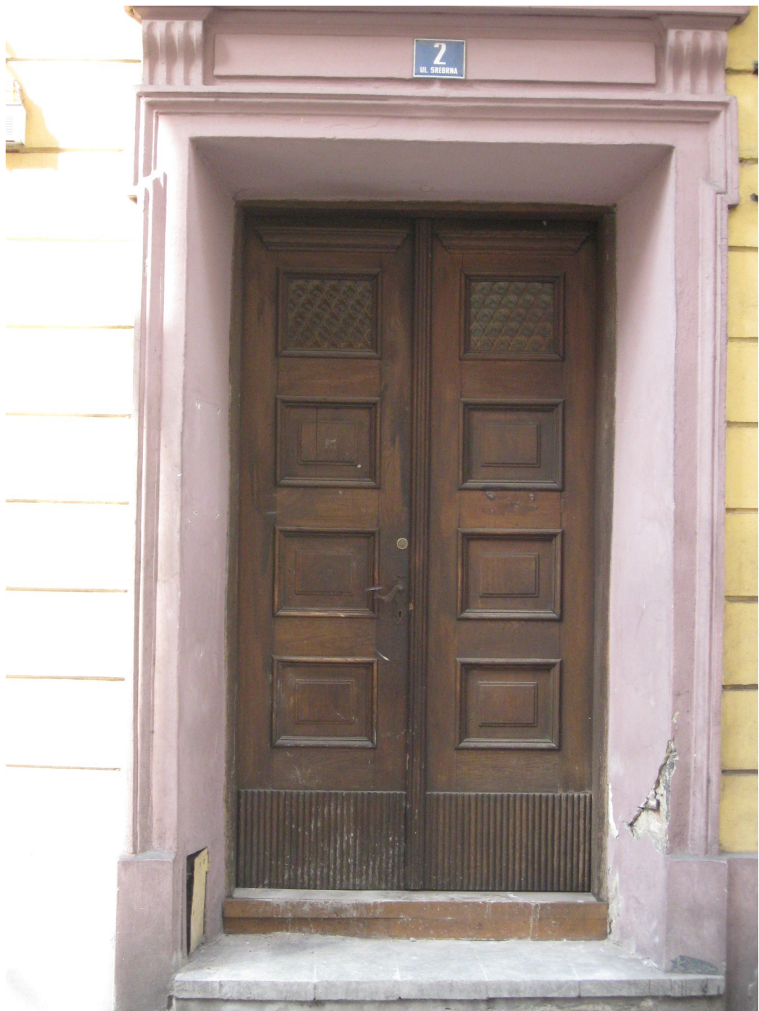
Fotografia nr 2. Istniejące drzwi w osi 4 budynku administracyjnego Srebrna 2 w elewacji od strony ulicy Srebrnej przeznaczone do renowacji (bez wymiany)
