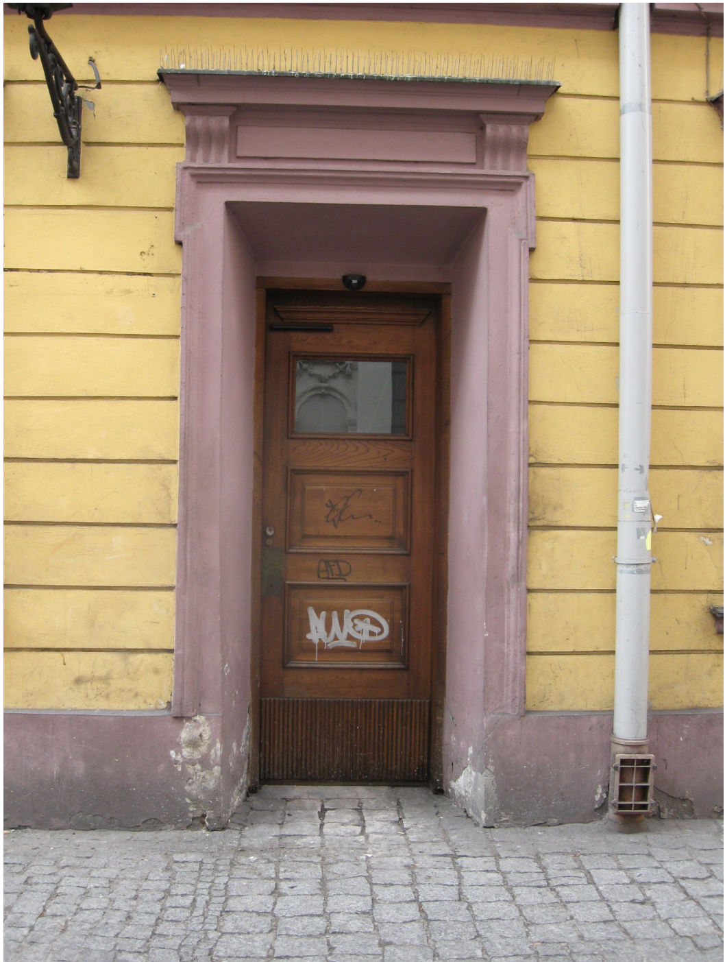
Fotografia nr 3. Istniejące drzwi w osi 6 budynku administracyjnego Srebrna 2 w elewacji od strony ulicy Srebrnej – przeznaczone do likwidacji
