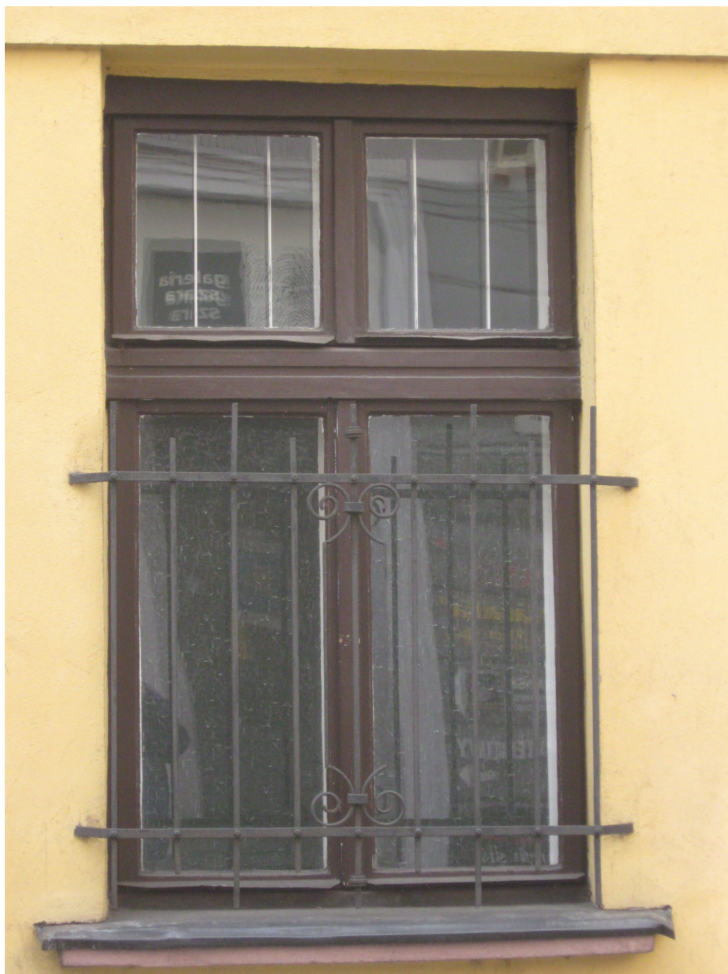
Fotografia nr 4. Istniejące okno w osi 10 budynku administracyjnego Srebrna 2 w elewacji od strony ulicy Srebrnej
