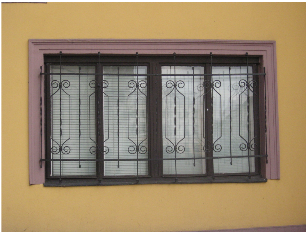
Fotografia nr 6. Istniejące okno w osi 12 budynku administracyjnego Rynek 1 w elewacji od strony ulicy Tadeusza Regera
