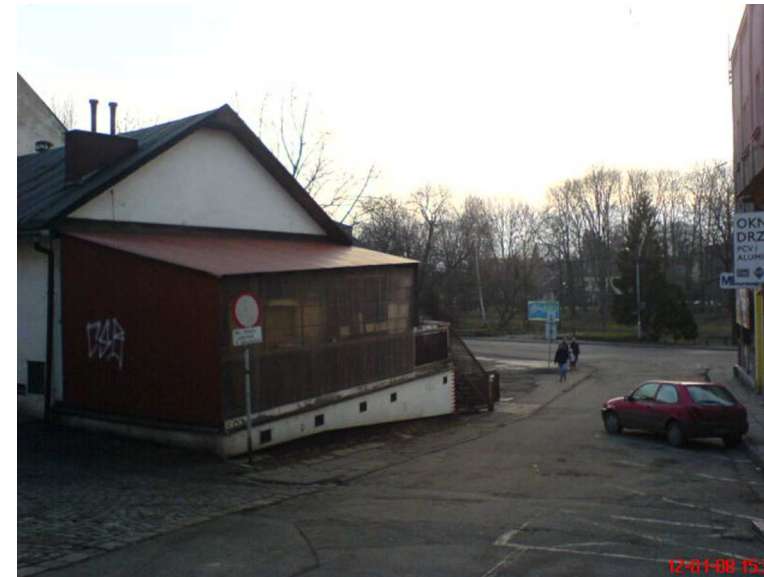
Budynek (przybudówka) wymagająca przebudowy.
