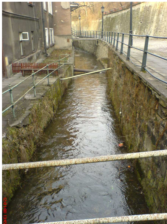
Kanał Młynówki w rejonie budynku przy ul. Przykopa 16-16a. Kamienne umocnienia brzegów kanału wymagają remontu.
