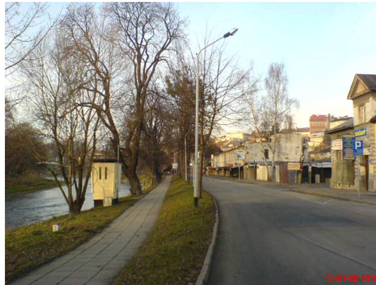
Al. Łyska w obszarze pomiędzy projektowanym mostem pieszym a Mostem Wolności.
