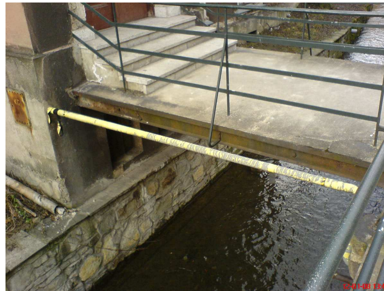
Kanał Młynówki w rejonie budynku przy ul. Przykopa 16-16a.
