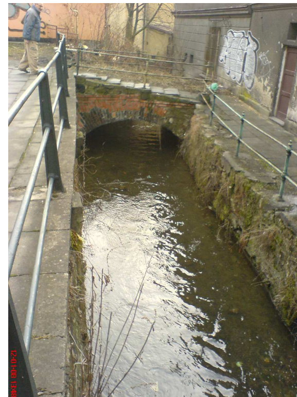
Kanał Młynówki w rejonie budynku przy ul. Przykopa 16-16a. Kamienne umocnienia brzegów kanału wymagają remontu.
