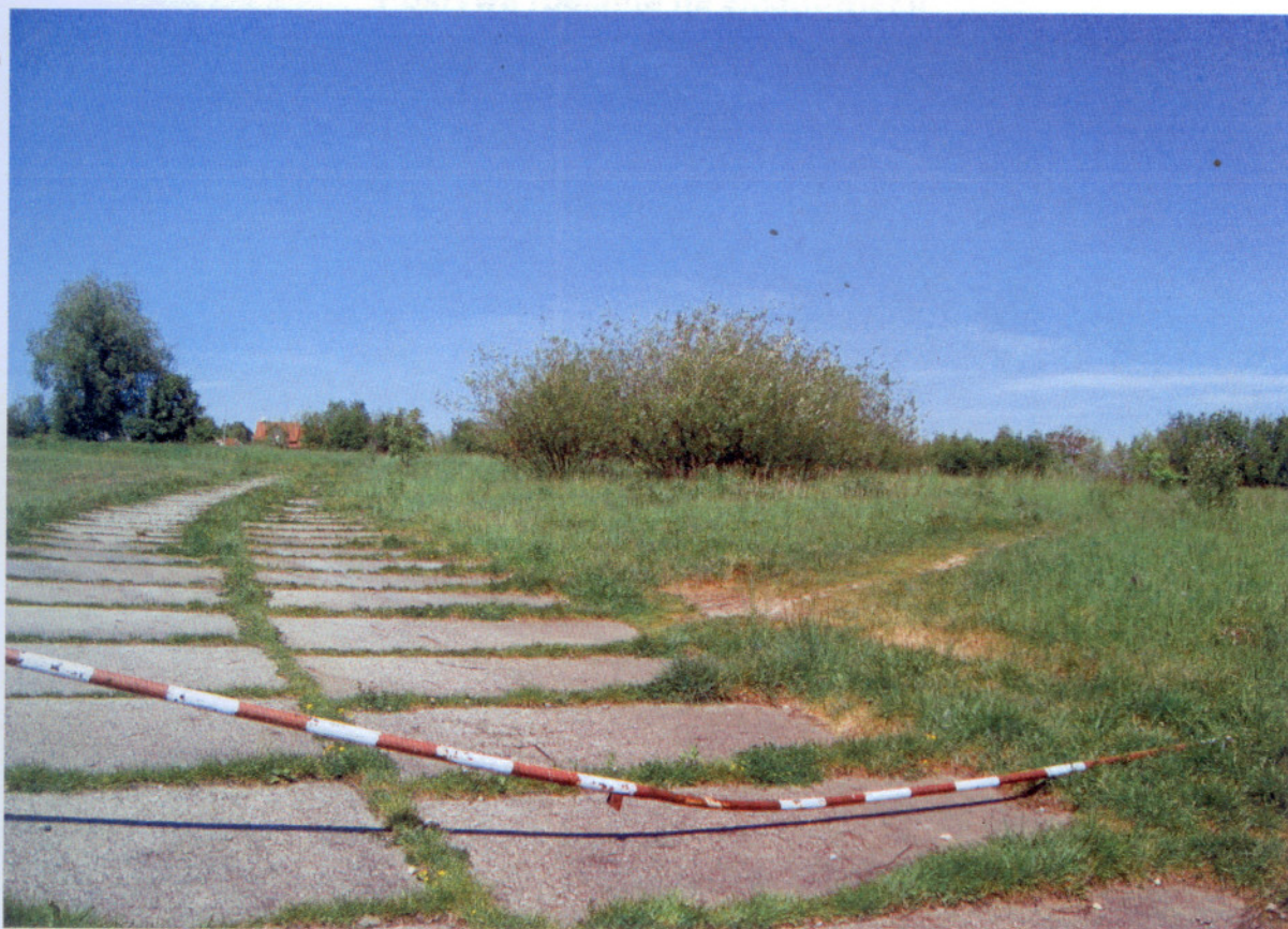
Widok z drogi dojazdowej na składowisko
