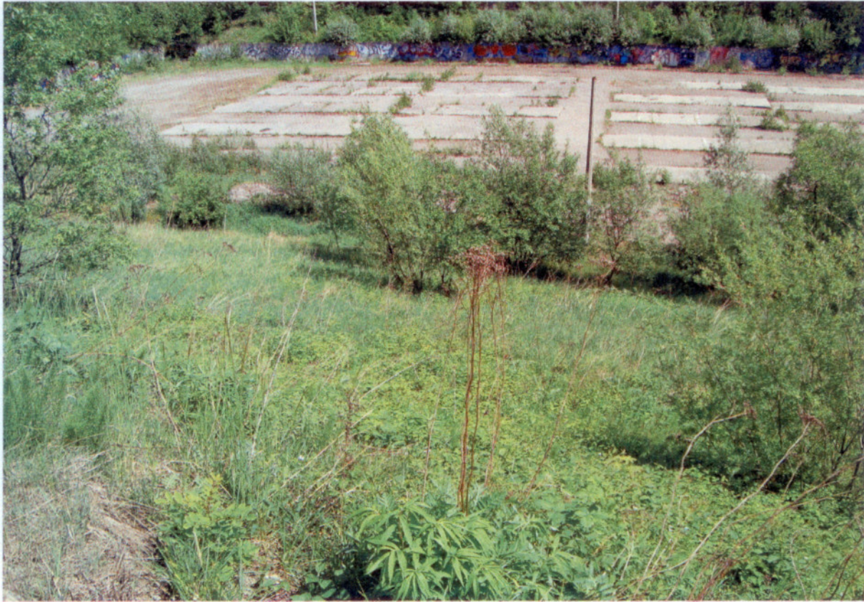
Widok na skarpę wschodnią
