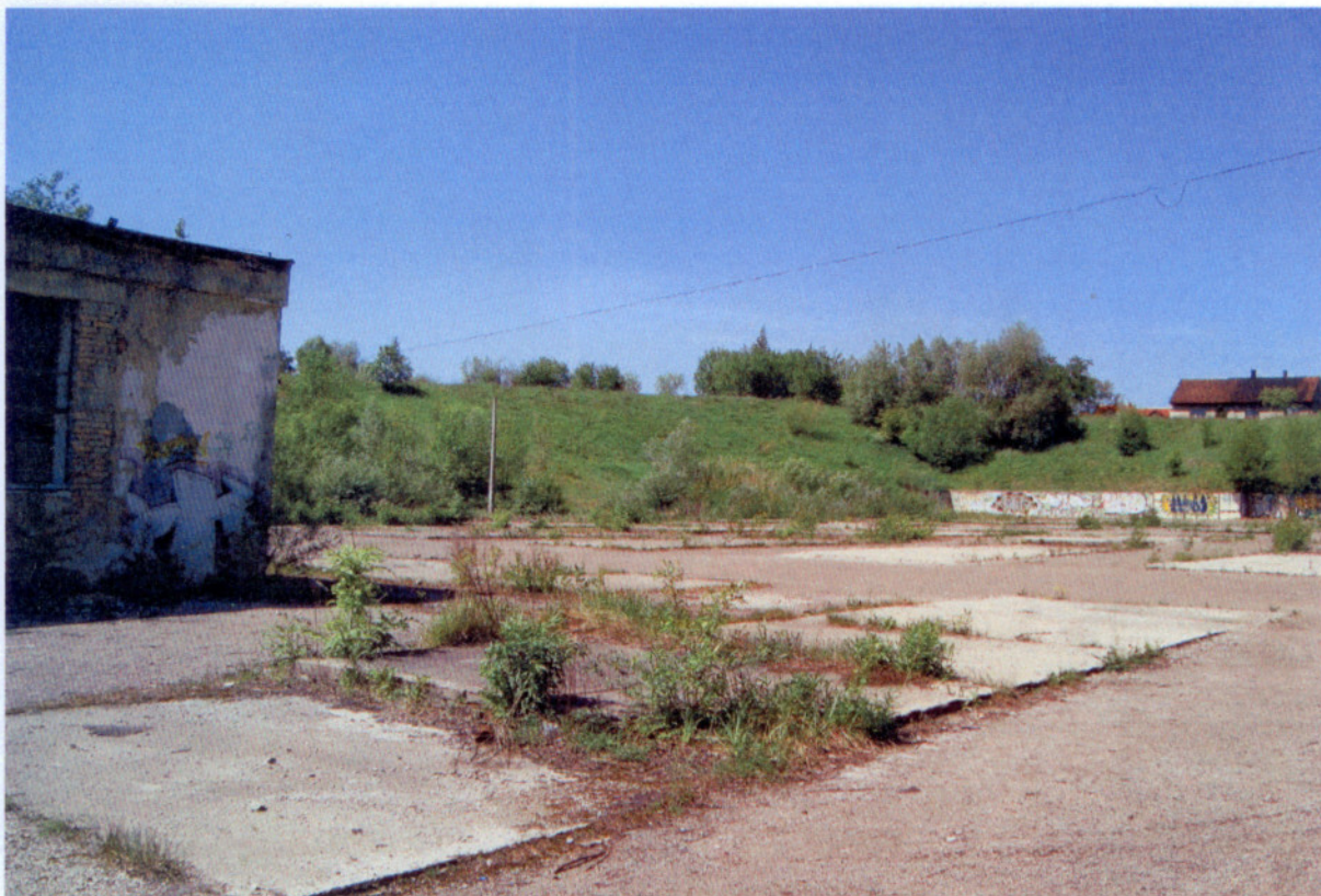
Widok ze strony zabudowań po byłej cegielni na wschodnią skarpę składowiska
