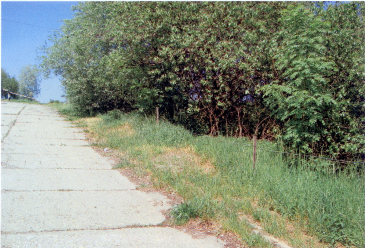
Widok z drogi dojazdowej na składowisko – od strony zachodniej
