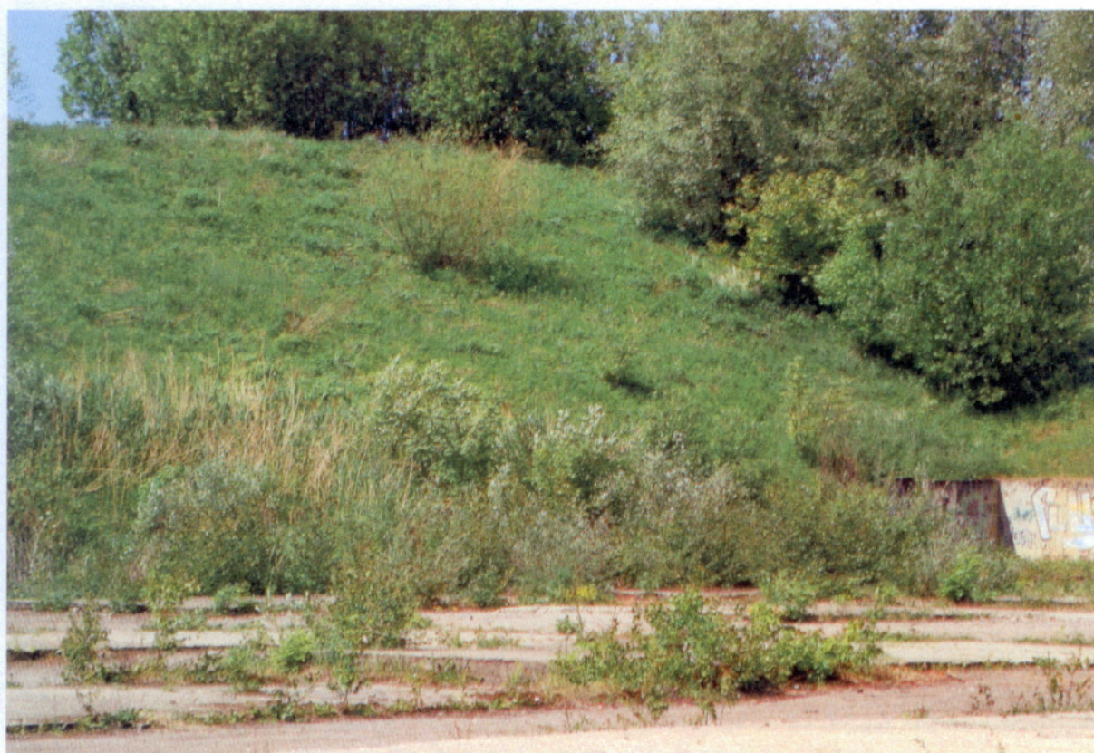
Widok ze strony zabudowań po byłej cegielni na wschodnią skarpę składowiska
