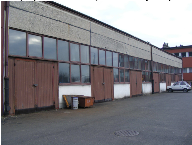
wymiana stolarki stalowej i bram wjazdowych
