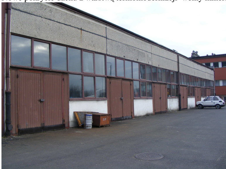
wymiana stolarki stalowej i bram wjazdowych
