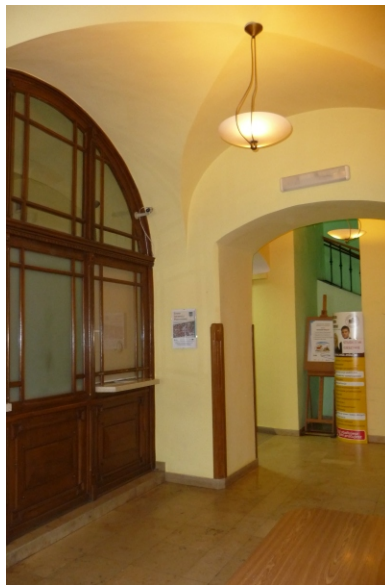
ROZBIÓRKA PRZEGRODY DREWNIANEJ
