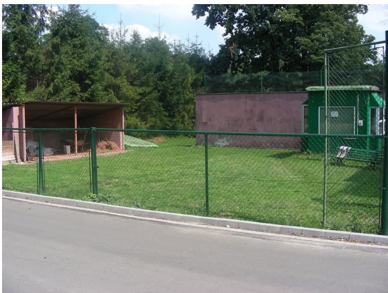
Widok od strony zachodniej (od ul. Sportowej) – widoczna wiata do rozbiórki
