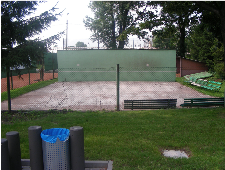
Widok od strony wschodniej (teren za ogrodzeniem) – widoczna ściana do rozbiórki
