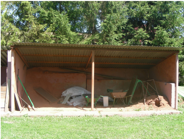
Wiata na mączkę ceglana do rozbiórki
