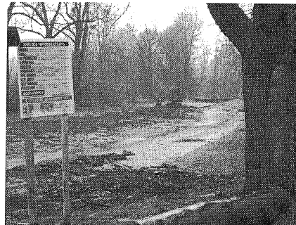
Budowa: „Modernizacja zalewu kajakowego”
